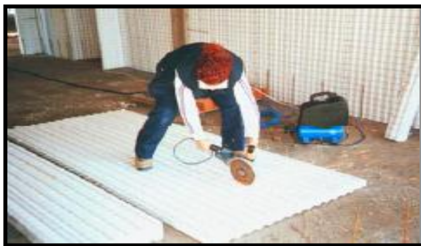
FIGURA 2 17 Corte y habilitación de paneles.
