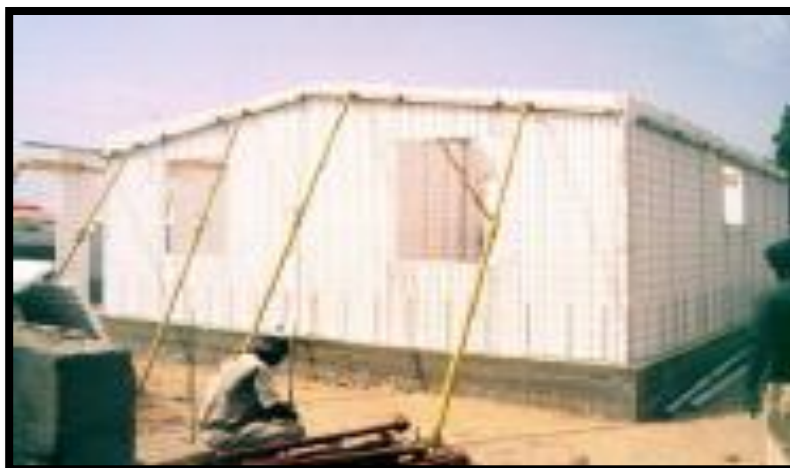
FIGURA 2 20 Apuntalamiento de paneles.
