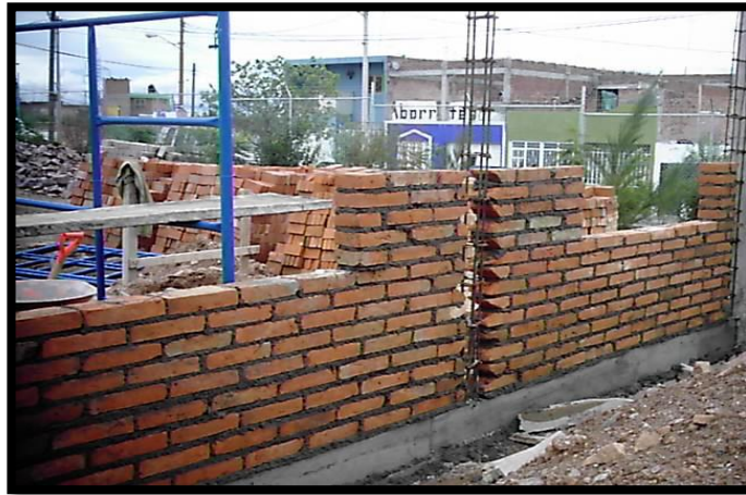
FIGURA 2 4 Muro No portante.
