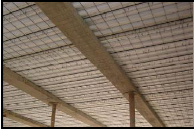
FIGURA 2 21 Apuntalamiento de paneles
