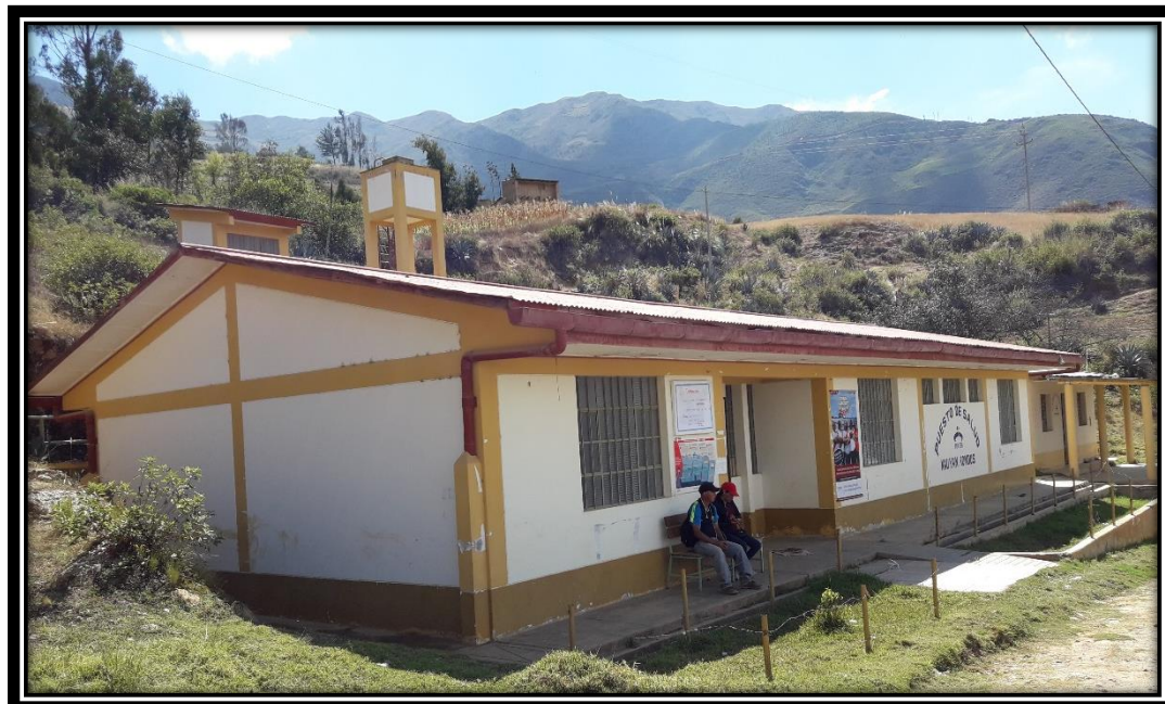
Figura 14. Ingreso del Puesto de Salud de Nauyan Rondos
