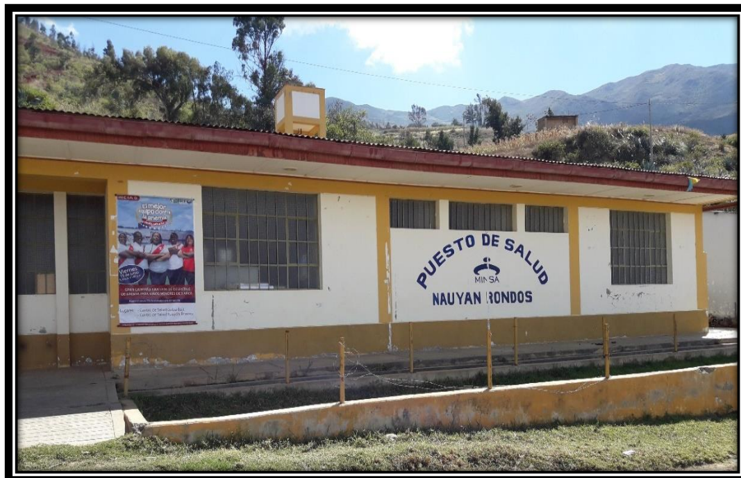
Figura 15. Vista Frontal de la estructura del Puesto de Salud Nauyan Rondos
