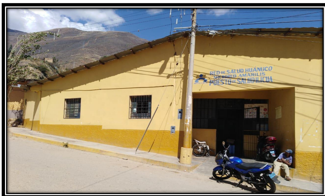
Figura 21. Vista Frontal de la estructura del Puesto de Salud Llicua
