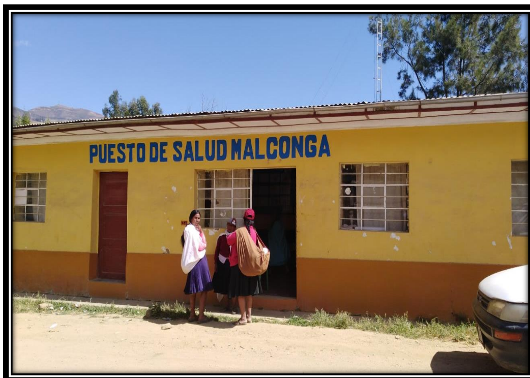
Figura 23. Vista Frontal de la estructura del Puesto de Salud Malconga
