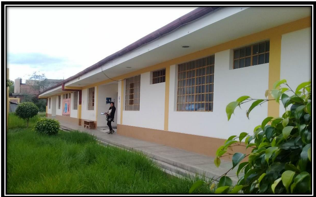
Figura 13. Vista Frontal de la estructura del Puesto de Salud Colpa Baja.
