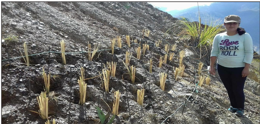
Ilustración 28. Instalación de las plantas Vetiveria Zizanoides.
