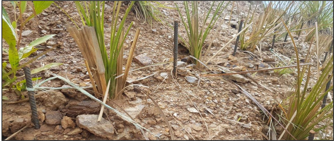
Ilustración 36. Control de erosión de suelos mediante las plantas Vetiveria Zizanoides.
