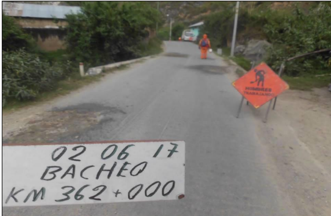
Imagen N°01- Mantenimiento Rutinario (Bacheo en afirmado)
