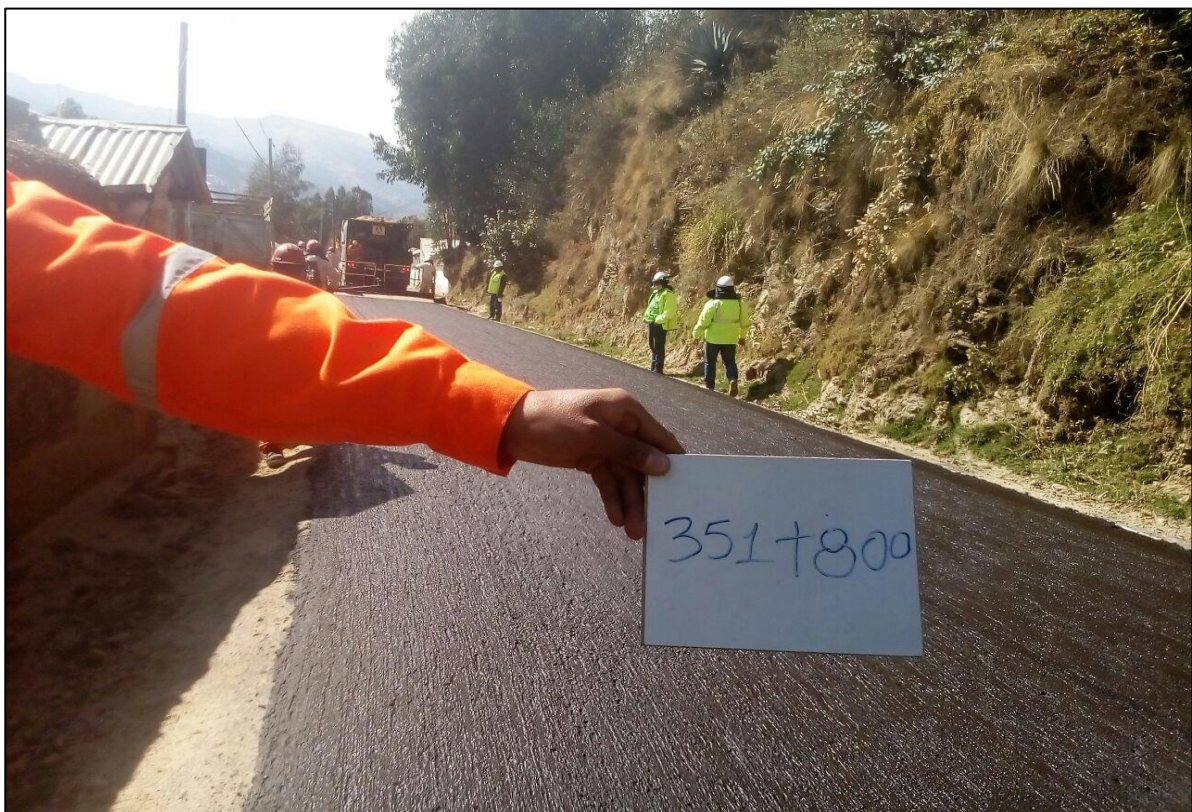
Imagen N°02 Mantenimiento Periódico (Trabajos de Imprimación con Slurry)
