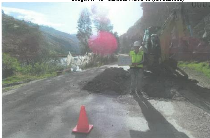
Imagen N° 10 –Calicata Tramo 05 (km 332+000)
