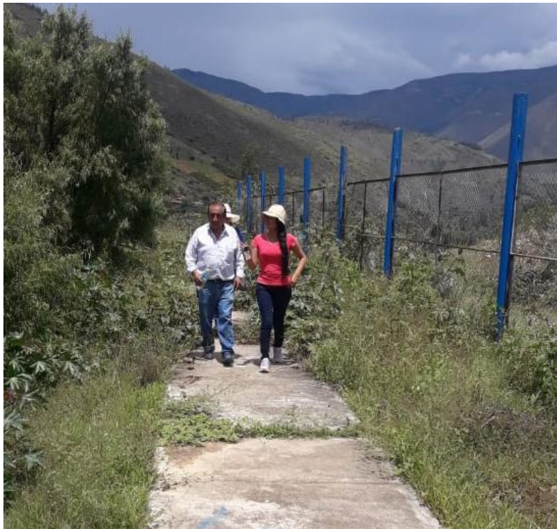
FOTOGRAFÍA 15: VISITA A LA PTAR CON EL ASESOR SIMEON CALIXTO VARGAS
