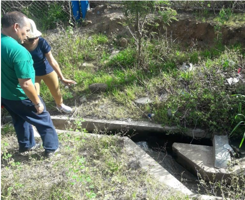
FOTOGRAFÍA 10: VISITA A LA PTAR CON EL JURADO ALEJANDRO DURAN NIEVA
