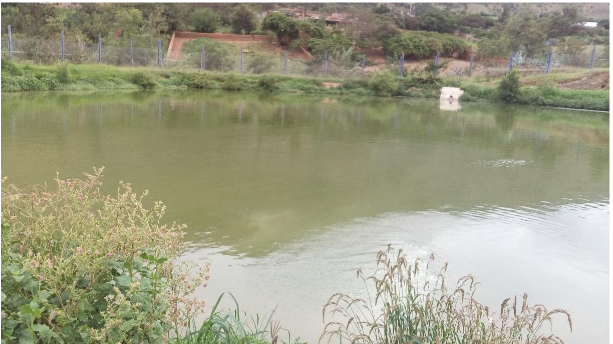
FOTOGRAFÍA 04: LAGUNA FACULTATIVA DE LA PLANTA DE TRATAMIENTO
