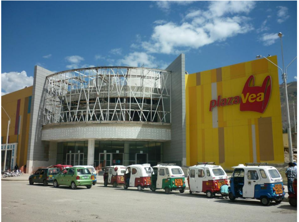
FOTOGRAFÍA N° 01 EXTERIORES DEL SUPERMERCADO PLAZA VEA DE HUÁNUCO
