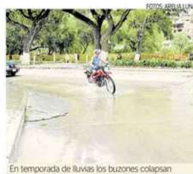
En temporada de lluvias los buzones colapsan
