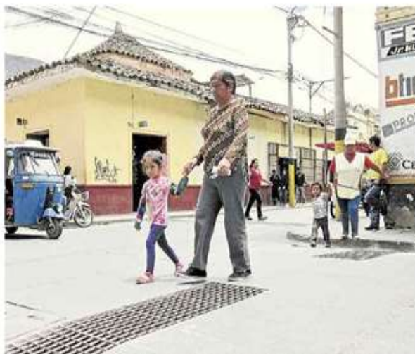
Sumideros de céntricas calles del drenaje, emanan nauseabundos olores
