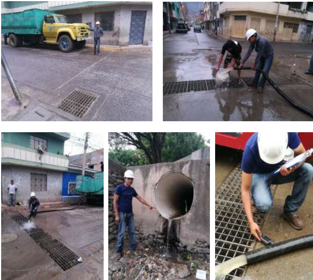
IMAGEN N°25: Pruebas Hidráulicas en los Jirones Críticos
