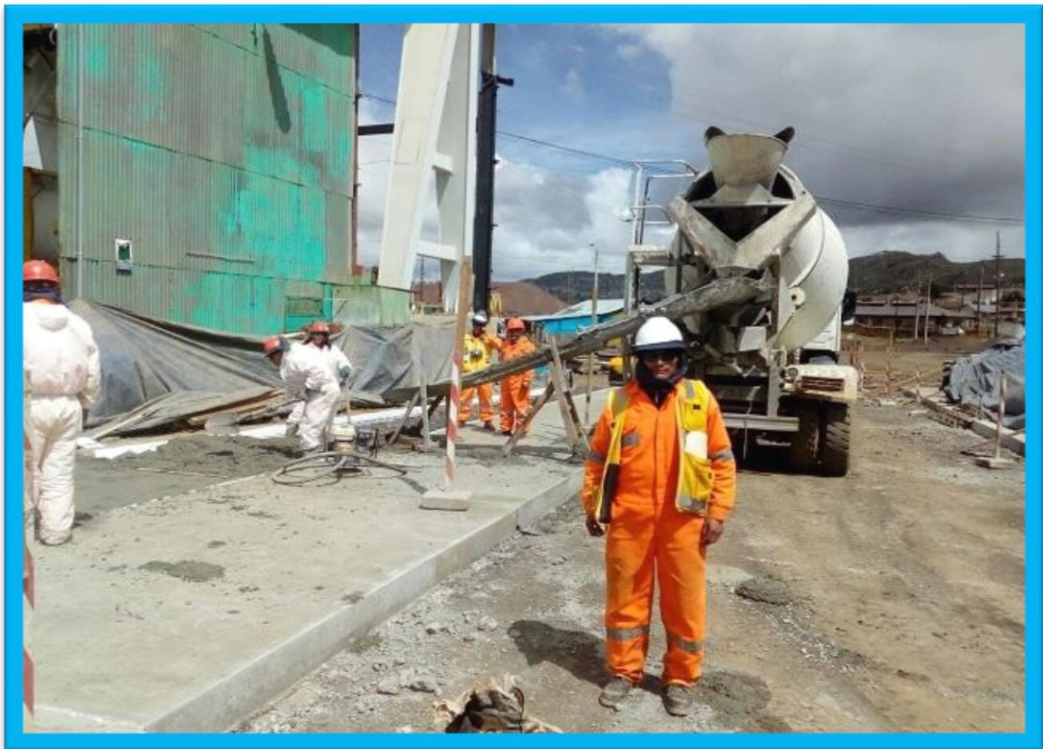
IMAGEN 30. AÑO 2017, Construcción de patio de maniobras y almacén de peróxido y cianuro, en compañía Minera Cerro SAC
