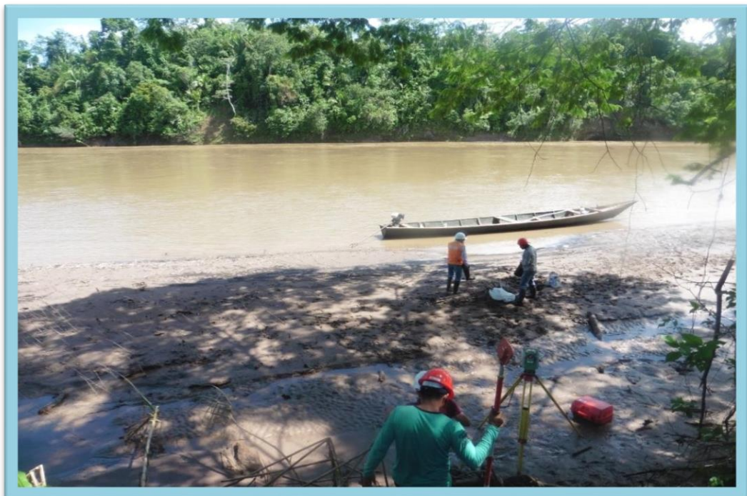
IMAGEN 25. Año 2014, Levantamiento Topográfico proyecto: construcción de Puente Colgante para tubería de agua en Puerto Bermúdez -Pasco.
