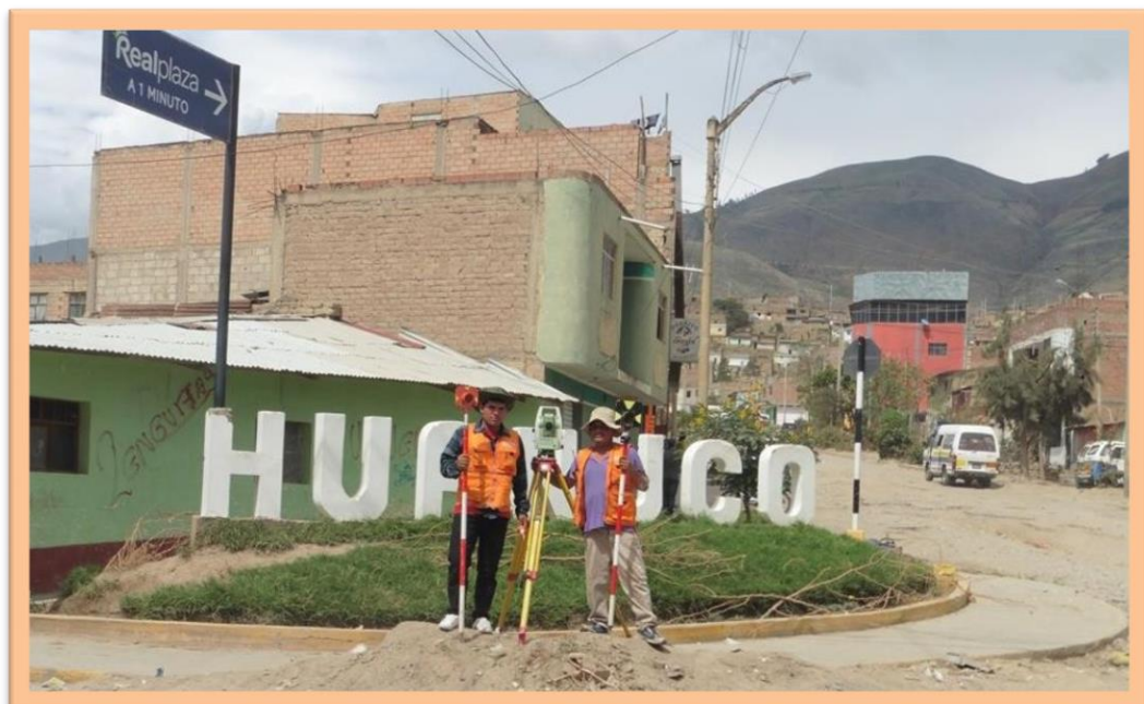
IMAGEN 29. Año 2016, Levantamiento topográfico para proyecto: pavimentación de la AV. Circunvalación- circuito Vial, Huánuco.
