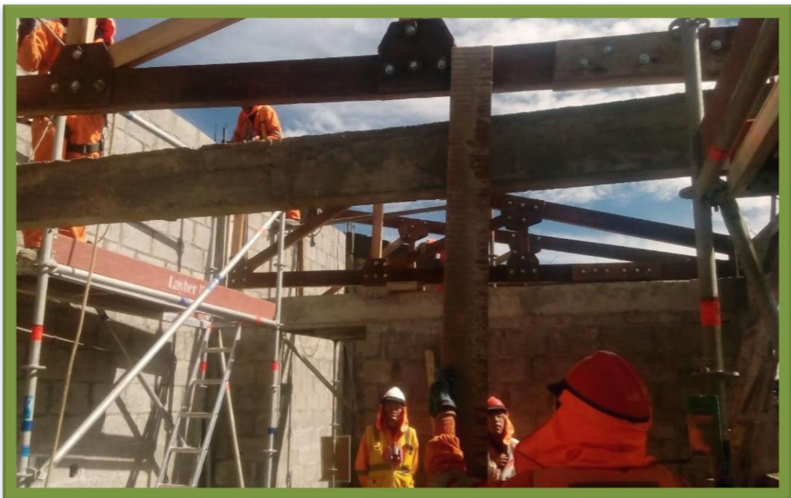
IMAGEN 37. AÑO 2018, Construcción de vestuario de la planta concentradora paragsha de la Compañía Minera Cerro SAC
