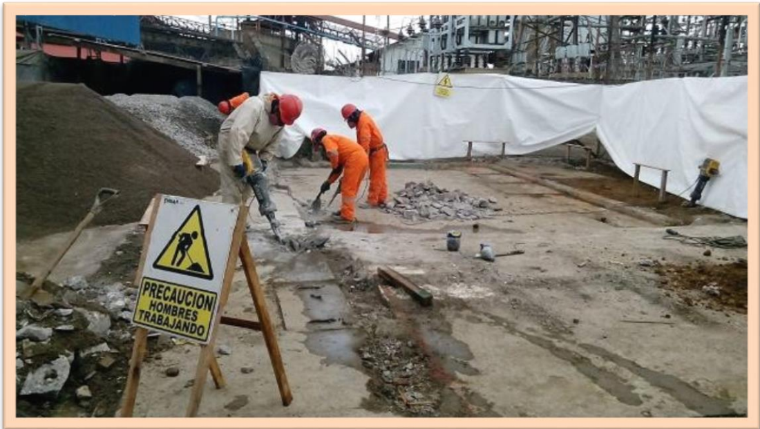
IMAGEN 36. . AÑO 2018, Construcción de vestuario de la planta concentradora paragsha de la Compañía Minera Cerro SAC
