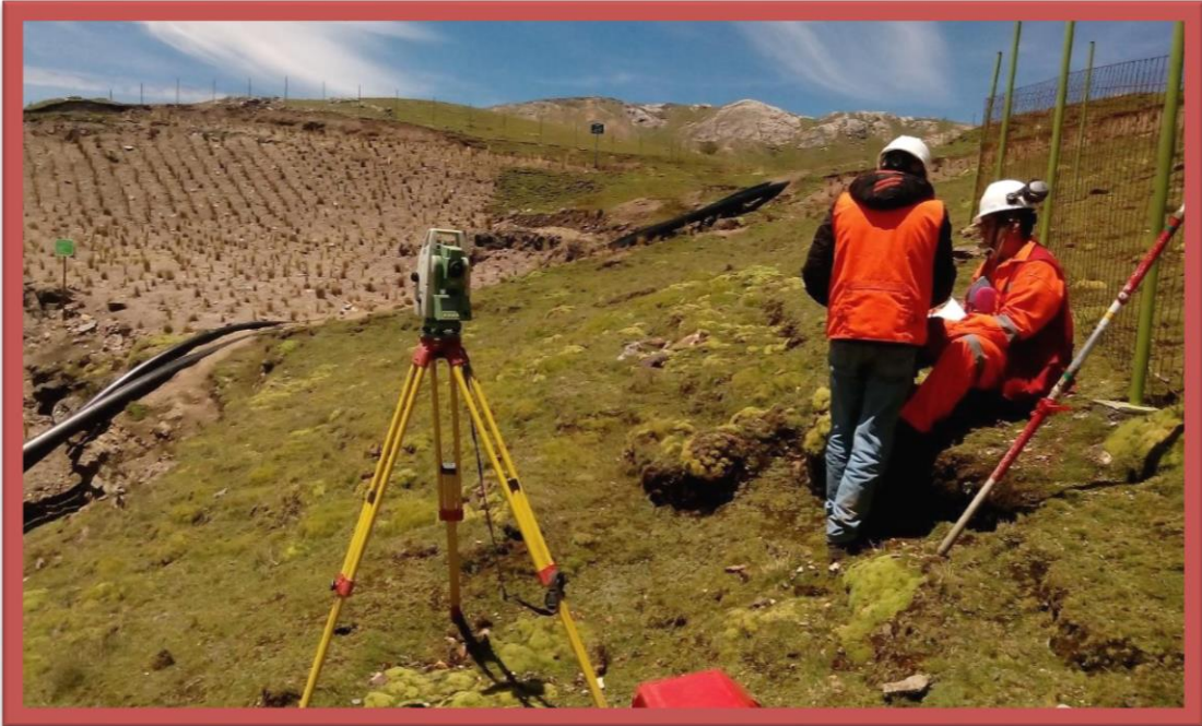
IMAGEN 39. AÑO 2018, Levantamiento Topográfico para los Planos As-Built
