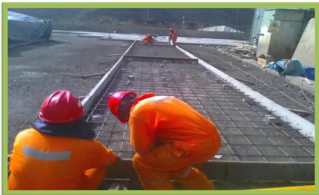
IMAGEN 31. AÑO 2017, Construcción de patio de maniobras y almacén de peróxido y cianuro, en compañía Minera Cerro SAC
