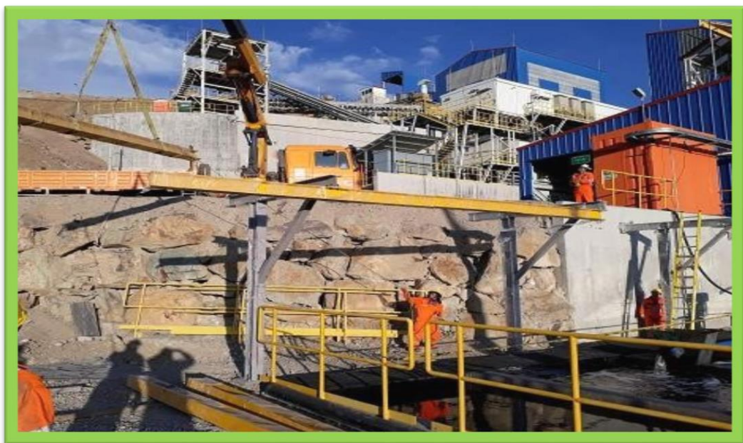
IMAGEN 163.AÑO 2017, Construcción Monorriel para puente Grúa en Cochas de Plomo y Zinc de la planta Concentradora de la Compañía Minera Alpamarca SA
