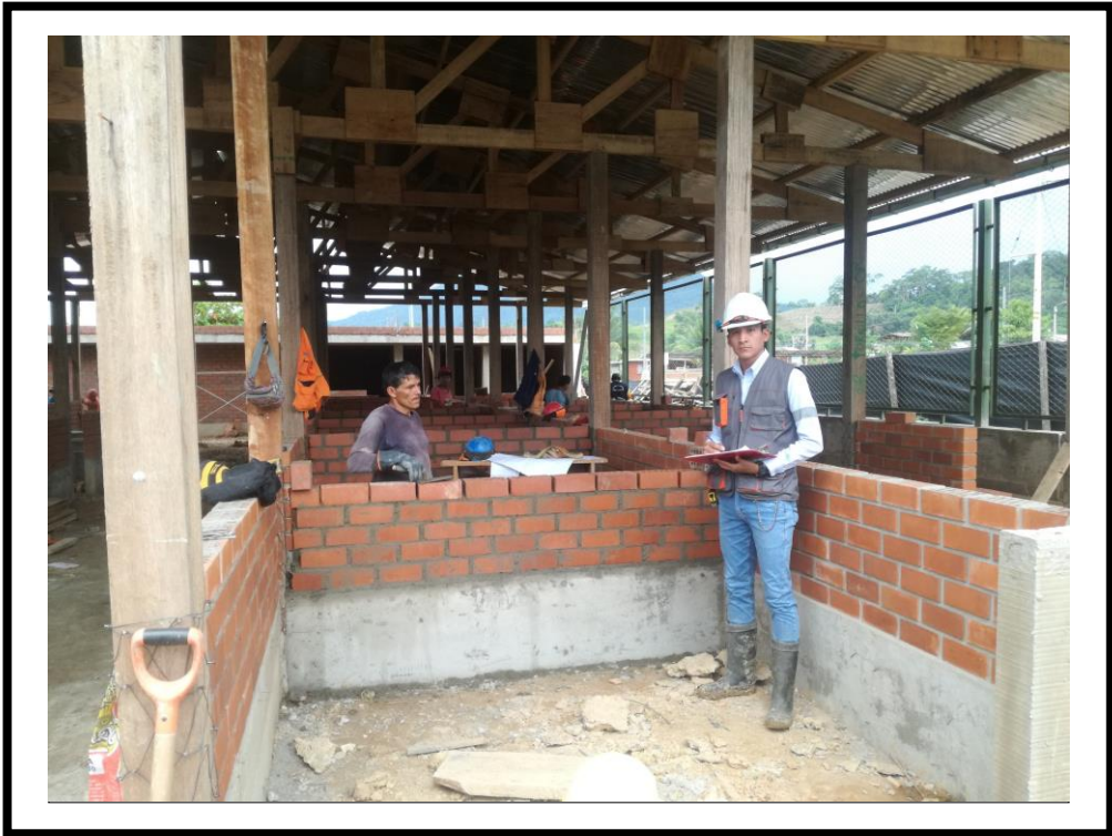
FOTOGRAFIA N° 37: Se puede observar en la fotografía la ejecución del muro (M-71) con las cuadrillas operario – peón, ejecutando la partida estudiada construcción de muro de albañilería con ladrillo King Kong 18H de arcilla colocado de soga con acabado dos caravistas.
