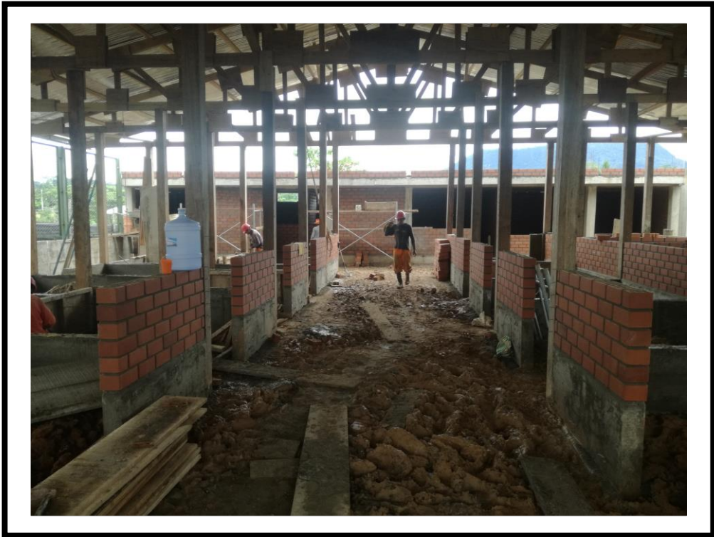
FOTOGRAFIA N° 35: Se puede observar en la fotografía culminados los muros de los ejes C'-C' y D'-D', ejecutados la partida estudiada construcción de muro de albañilería con ladrillo King Kong 18H de arcilla colocado de soga con acabado dos caravistas.
