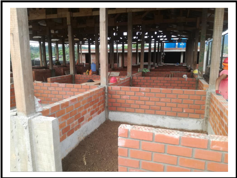
FOTOGRAFIA N° 40: Se puede observar en la fotografía la culminación de la ejecución de la partida estudiada construcción de muro de albañilería con ladrillo King Kong 18H de arcilla colocado de sogá con acabado dos caravistas.
