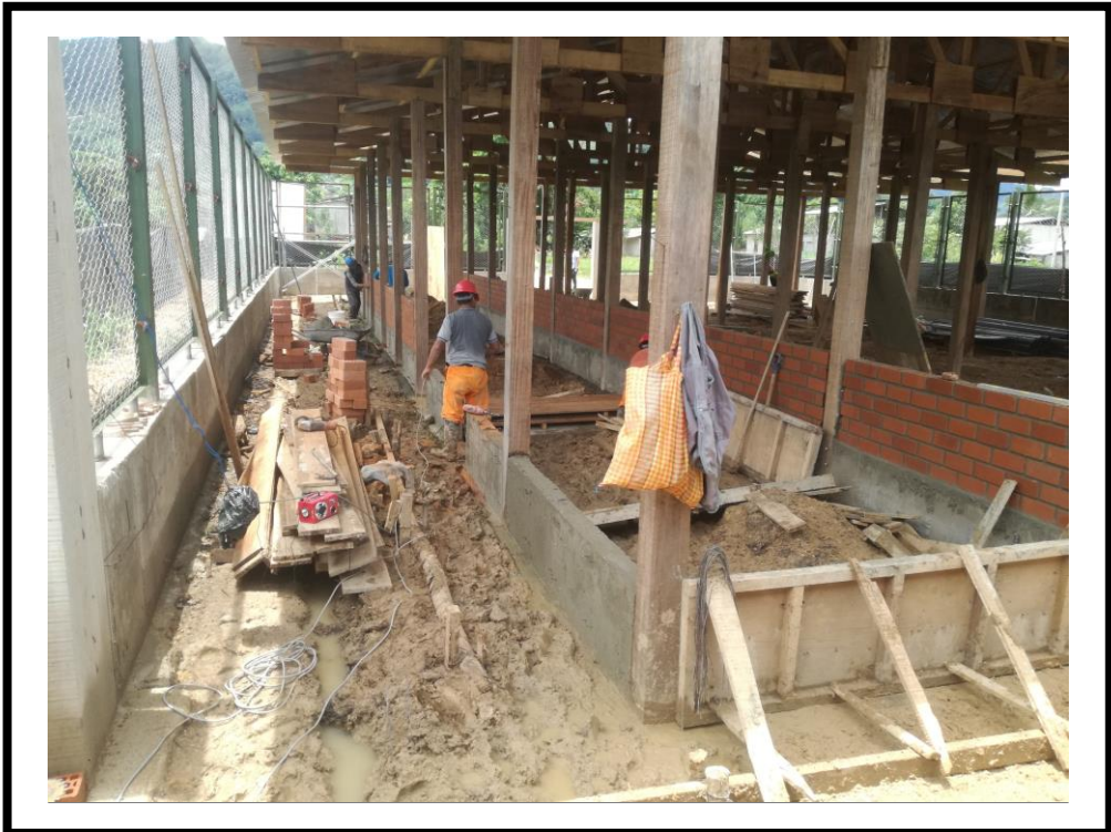
FOTOGRAFIA N° 30: Se puede observar en la fotografía la ejecución del muro (M-18, M-25) con las cuadrillas operario – peón, ejecutando la partida estudiada construcción de muro de albañilería con ladrillo King Kong 18H de arcilla colocado de saga con acabado dos caravistas.
