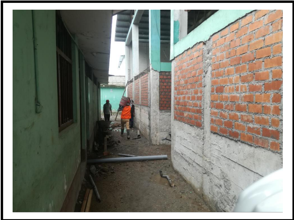
FOTOGRAFIA N° 06: Se puede observar en la fotografía el acarreo del material por el peón por el corredor hacia el operario para proseguir con la ejecución de la partida estudiada.
