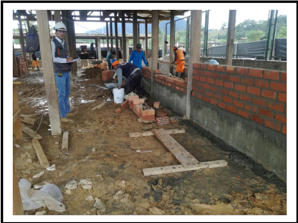
FOTOGRAFIA N° 28: Se puede observar en la fotografía la ejecución del muro (M-11, M-12) con las cuadrillas operario – peón, ejecutando la partida estudiada construcción de muro de albañilería con ladrillo King Kong 18H de arcilla colocado de soga con acabado dos caravistas.
