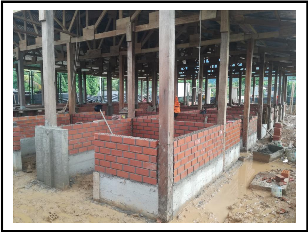
FOTOGRAFIA N° 39: Se puede observar en la fotografía la culminación de la ejecución de la partida estudiada construcción de muro de albañilería con ladrillo King Kong 18H de arcilla colocado de sogá con acabado dos caravistas.
