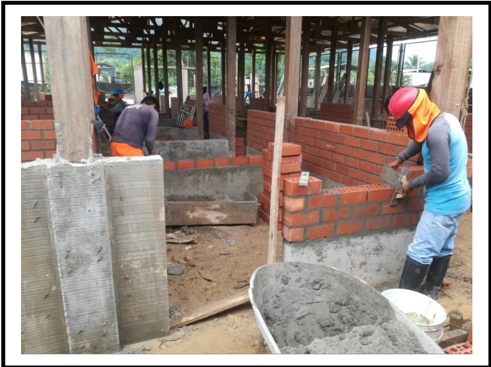
FOTOGRAFIA N° 36: Se puede observar en la fotografía la ejecución del muro (M-58, M-59) con las cuadrillas operario – peón, ejecutando la partida estudiada construcción de muro de albañilería con ladrillo King Kong 18H de arcilla colocado de soga con acabado dos caravistas.
