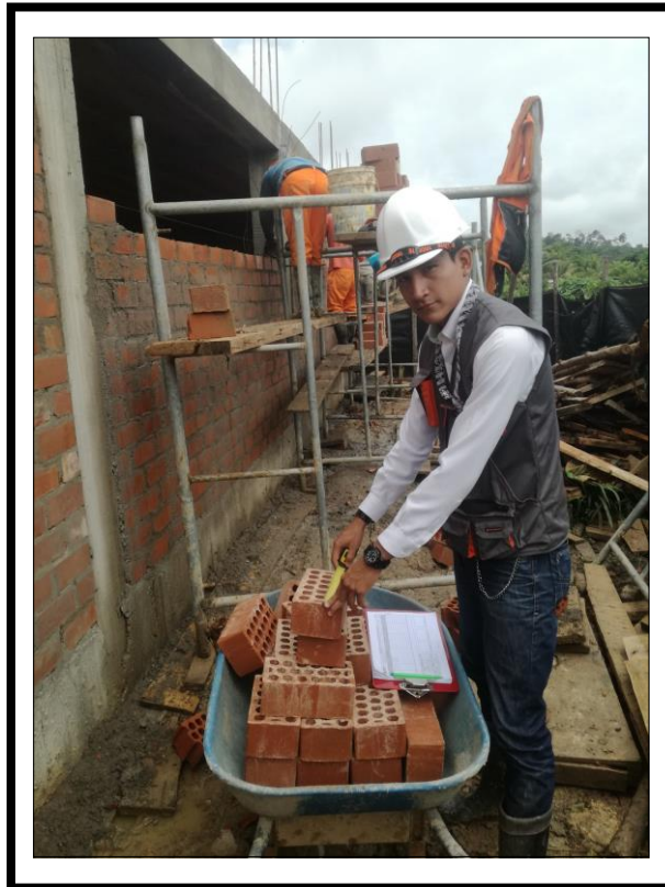
FOTOGRAFIA N° 34: Se puede observar en la fotografía tomando las dimensiones de las unidades de albañilería King Kong 18H
