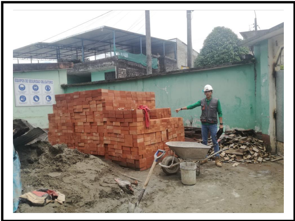
FOTOGRAFIA N° 19: Se puede observar en la fotografía las unidades de albañilería King Kong 18H proveniente del distribuidor Casa de los Ladrillos Chapacuate.
