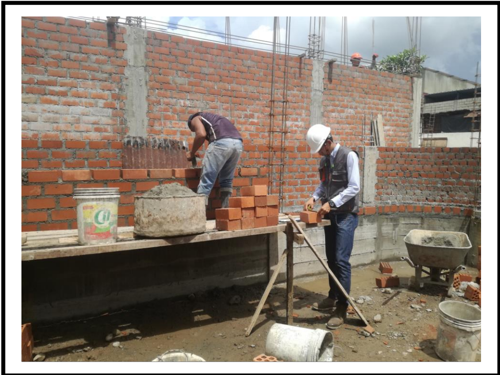
FOTOGRAFIA N° 16: Se puede observar en la fotografía la ejecución del muro (M-61) con la cuadrilla operario – peón, ejecutando la partida estudiada construcción de muro de albañilería con ladrillo King Kong 18H de arcilla colocado de sogá.
