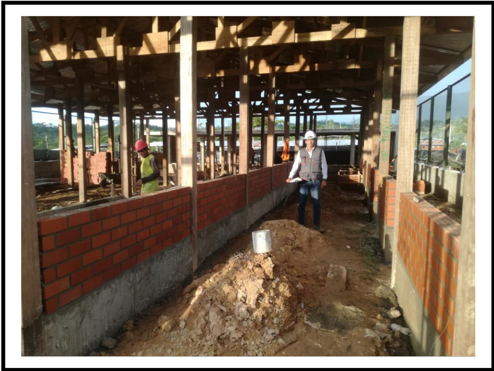
FOTOGRAFIA N° 31: Se puede observar en la fotografía culminados los muros de los ejes E'-E' y F'-F', ejecutados la partida estudiada construcción de muro de albañilería con ladrillo King Kong 18H de arcilla colocado de soga con acabado dos caravistas.
