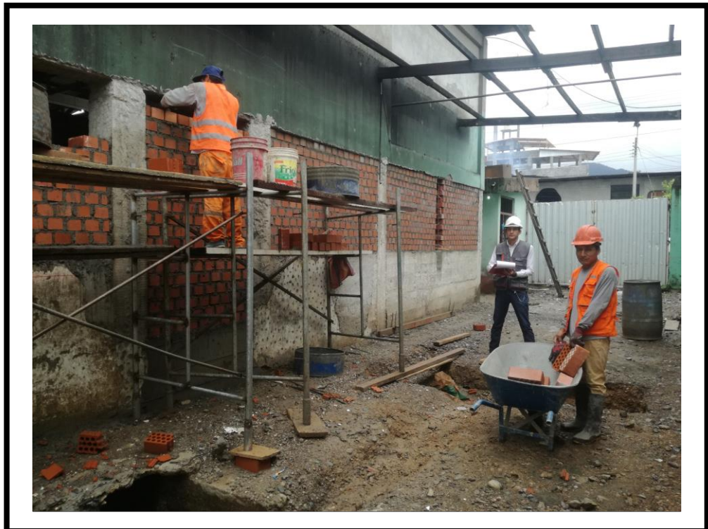
FOTOGRAFIA N° 04: Se puede observar en la fotografía la ejecución del muro (M-29) con la cuadrilla operativo – peón, ejecutando la partida estudiada construcción de muro de albañilería con ladrillo King Kong 18H de arcilla colocado de cabeza.
