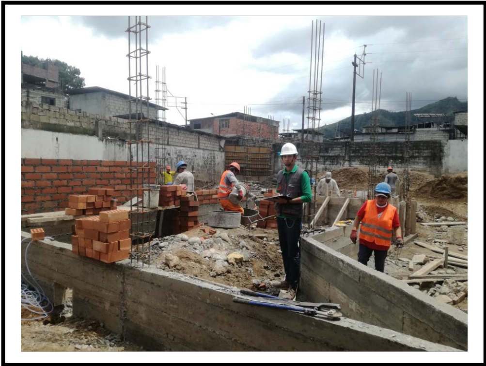
FOTOGRAFIA N° 17: Se puede observar en la fotografía la ejecución del muro (M-81) con la cuadrilla operario – peón, ejecutando la partida estudiada construcción de muro de albañilería con ladrillo King Kong 18H de arcilla colocado de sogá.
