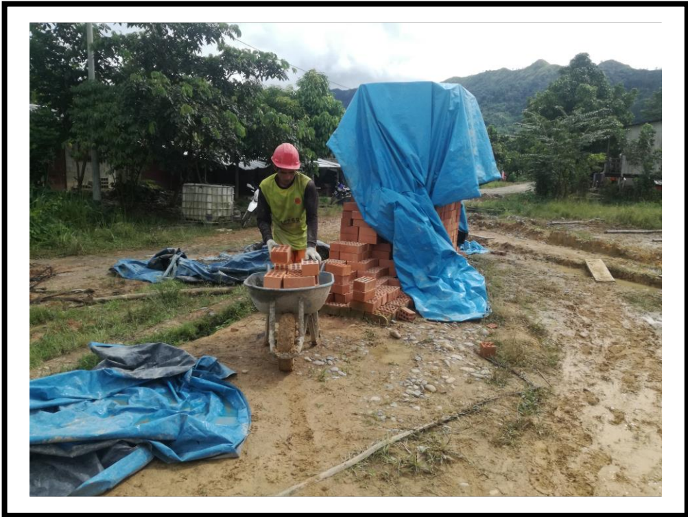
FOTOGRAFIA N° 29: Se puede observar en la fotografía el acarreo de las unidades de albañilería King Kong 18H hacia el operario.
