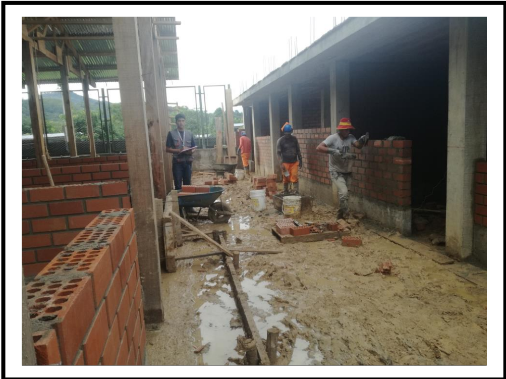
FOTOGRAFIA N° 32: Se puede observar en la fotografía la ejecución del muro (M-50, M-49, M-53) con las cuadrillas operario – peón, ejecutando la partida estudiada construcción de muro de albañilería con ladrillo King Kong 18H de arcilla colocado de soga.
