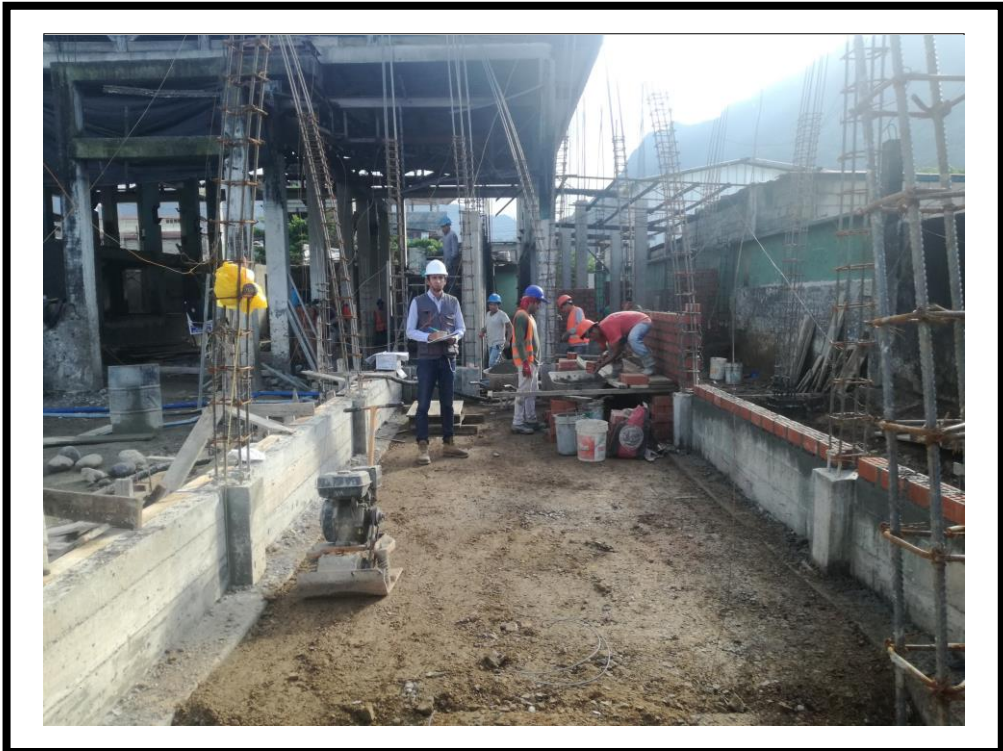
FOTOGRAFIA N° 08: Se puede observar en la fotografía la ejecución del muro (M-39) con la cuadrilla operario – peón, ejecutando la partida estudiada construcción de muro de albañilería con ladrillo King Kong 18H de arcilla colocado de saga.
