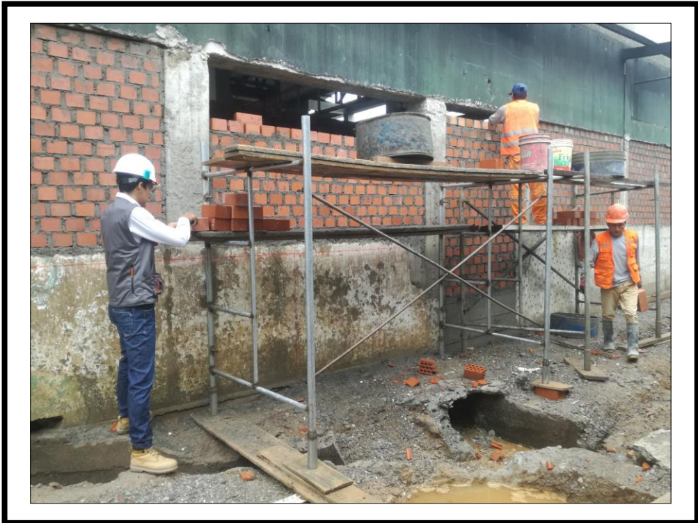
FOTOGRAFIA N° 05: Se puede observar en la fotografía como se toman las dimensiones de la unidad de albañilería empleada en la partida (ladrillo King Kong 18H).
