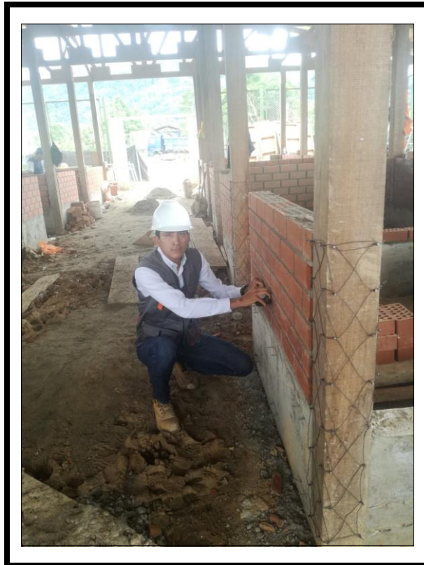
FOTOGRAFIA N° 38: Se puede observar en la fotografía tomando las dimensiones de la junta vertical de la partida estudiada.
