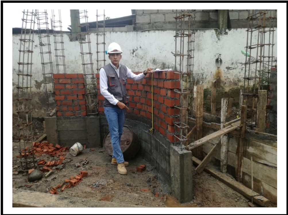
FOTOGRAFIA N° 22: Se puede observar en la fotografía la ejecución del muro (M-112) con la cuadrilla operario – peón, ejecutando la partida estudiada construcción de muro de albañilería con ladrillo King Kong 18H de arcilla colocado de saga.
