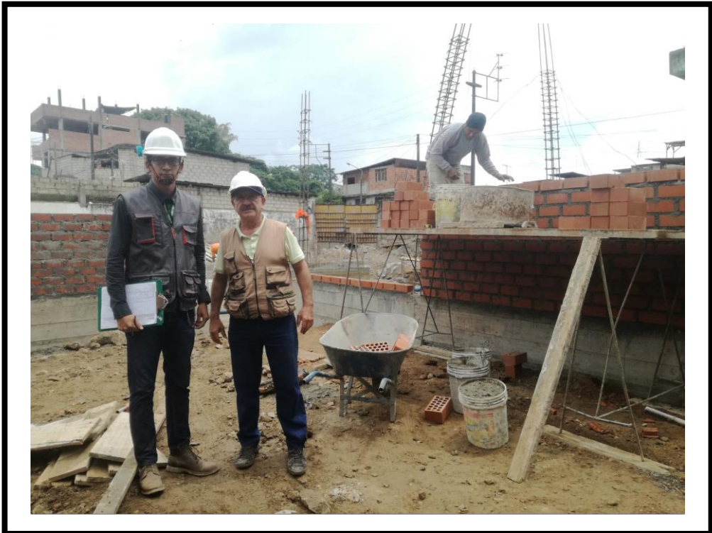
FOTOGRAFIA N° 14: Se puede observar en la fotografía la ejecución del muro (M-55) con la cuadrilla operario – peón, ejecutando la partida estudiada construcción de muro de albañilería con ladrillo King Kong 18H de arcilla colocado de soga, con la participación del ingeniero Edwin Sanchez Cachay residente de obra.
