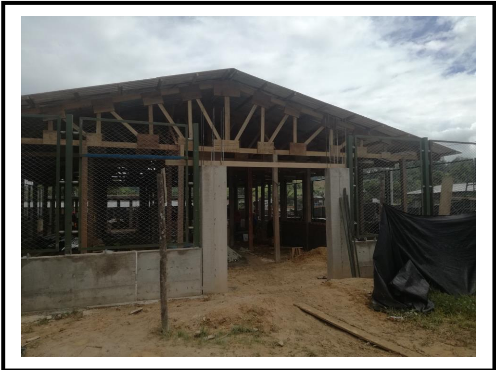
FOTOGRAFIA N° 26: Se puede observar en la fotografía la ejecución de las partidas predecesoras a las investigadas.
