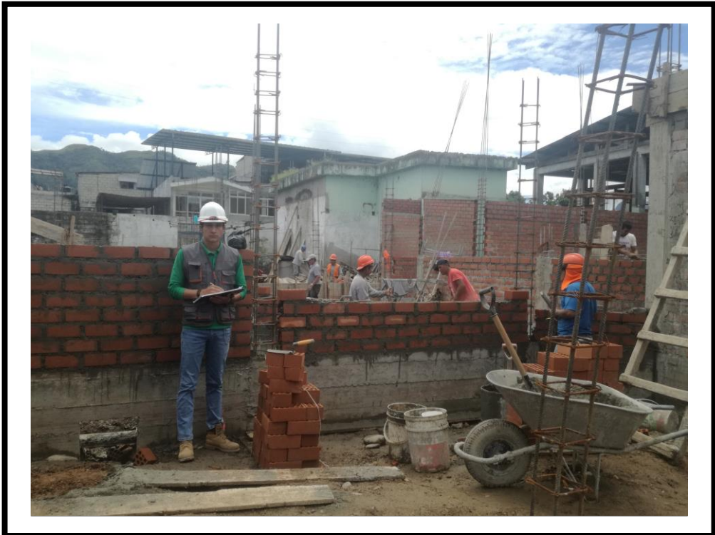
FOTOGRAFIA N° 18: Se puede observar en la fotografía la ejecución del muro (M-85) con la cuadrilla operario – peón, ejecutando la partida estudiada construcción de muro de albañilería con ladrillo King Kong 18H de arcilla colocado de sogá.
