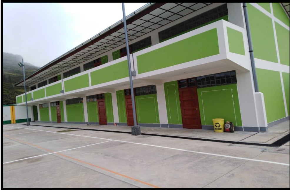
Fotografía N°3: Se observa el Pabellón N°1 culminada en su totalidad.
