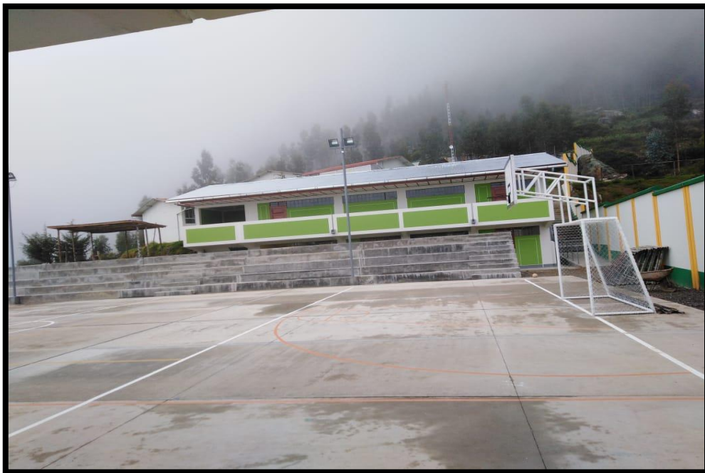
Fotografía N°4: Se observa el Pabellón N°2, la tribuna y losa deportiva culminada en su totalidad.
