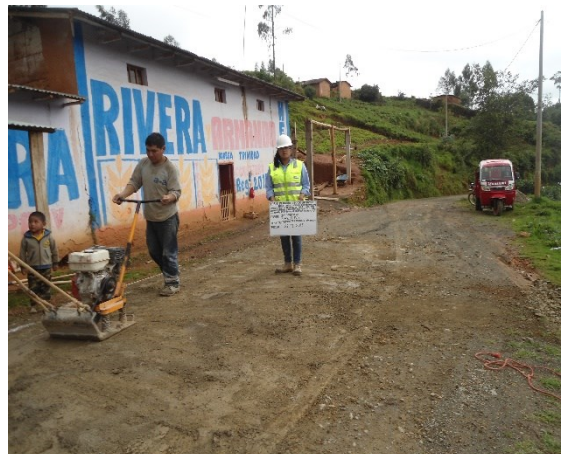
Figura 11. Compactación para la muestra
