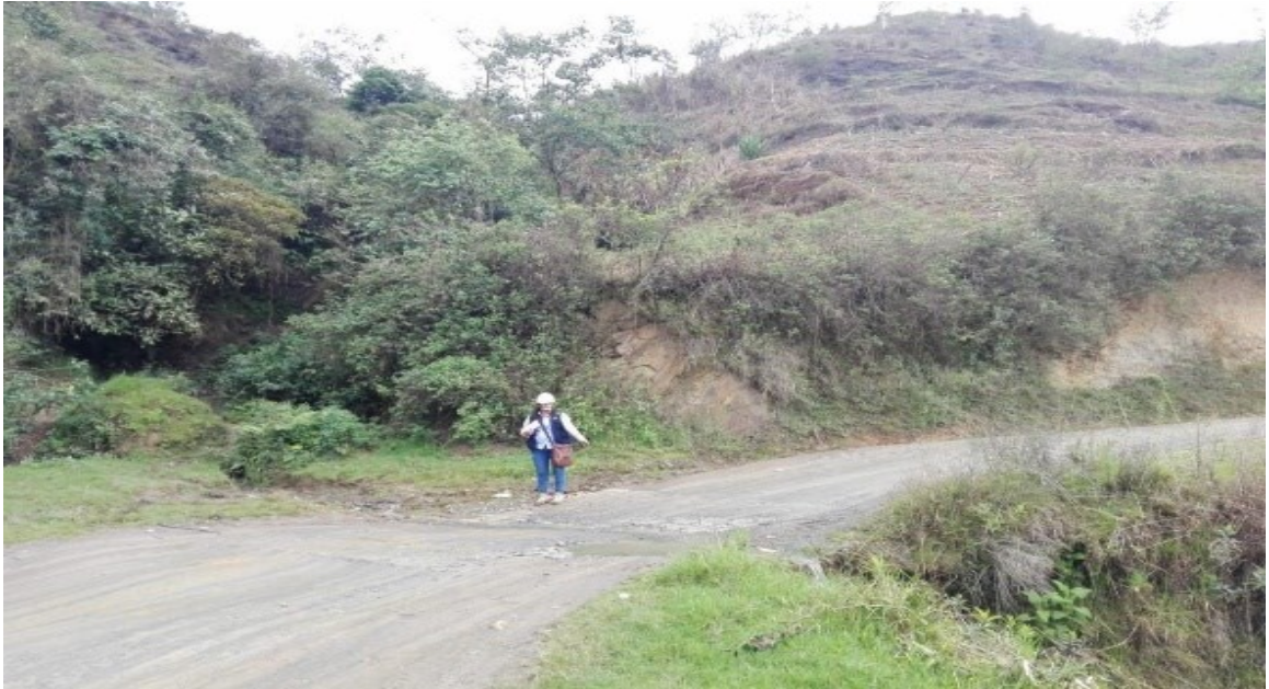
Figura 27. Mensura del ancho en el Baden Progresiva 2+000
