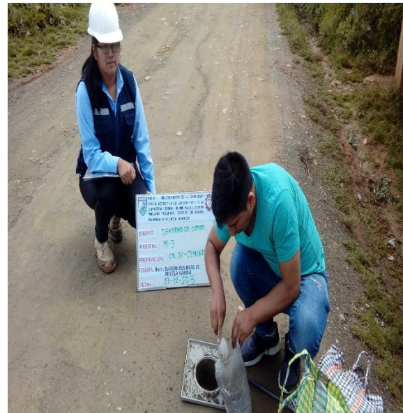
Figura 77 Se vuelve el material a la muestra llevándose una porción para el análisis en laboratorio.
