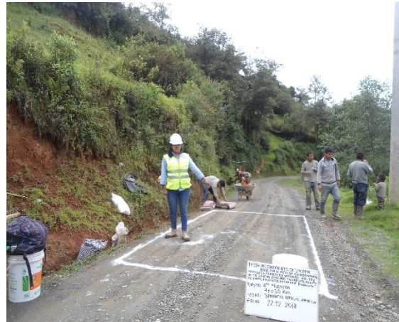
Figura 9. Trazo de la muestra de 2.50 m x 5.00 m x 0.12 m
