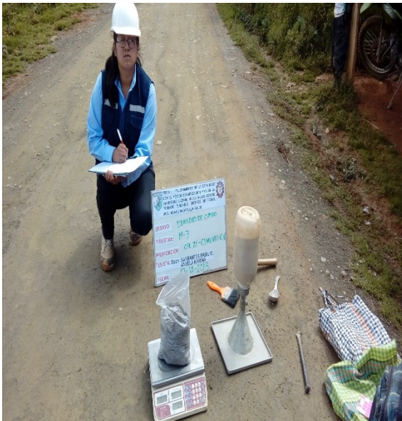
Figura 76 Se coloca el envase y se deja llenar el orificio, e pesa la muestra que se ha sacado del orificio.
