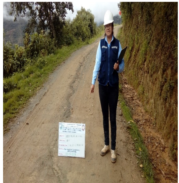
Figura 93 M-04 Fisura longitudinal leve 0.70m, fisura transversal leve 0.15m y Desprendimiento de finos 9.44%
