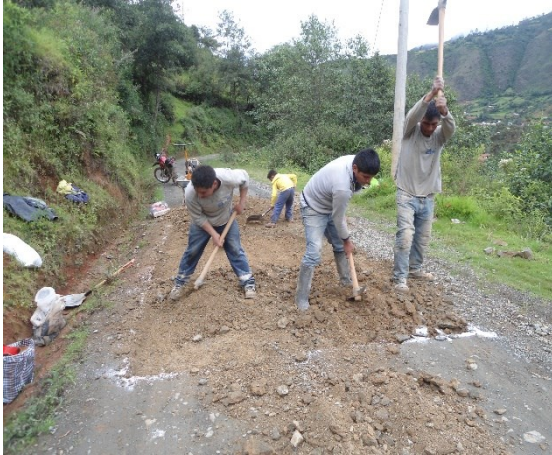
Figura 14. Mezcla con Cal y Cemento
