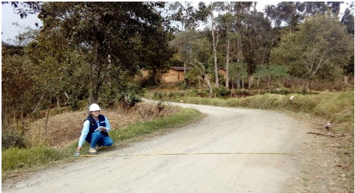
Figura 28. Mensura del ancho en Vivienda Progresiva 6+000
