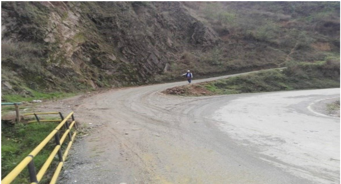
Figura 26. Mensura del ancho en el Puente Charamayo Progresiva 0+000
