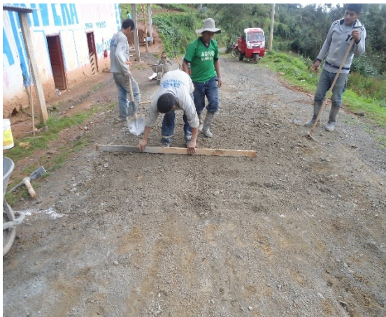
Figura 12. Nivelación para la Muestra
