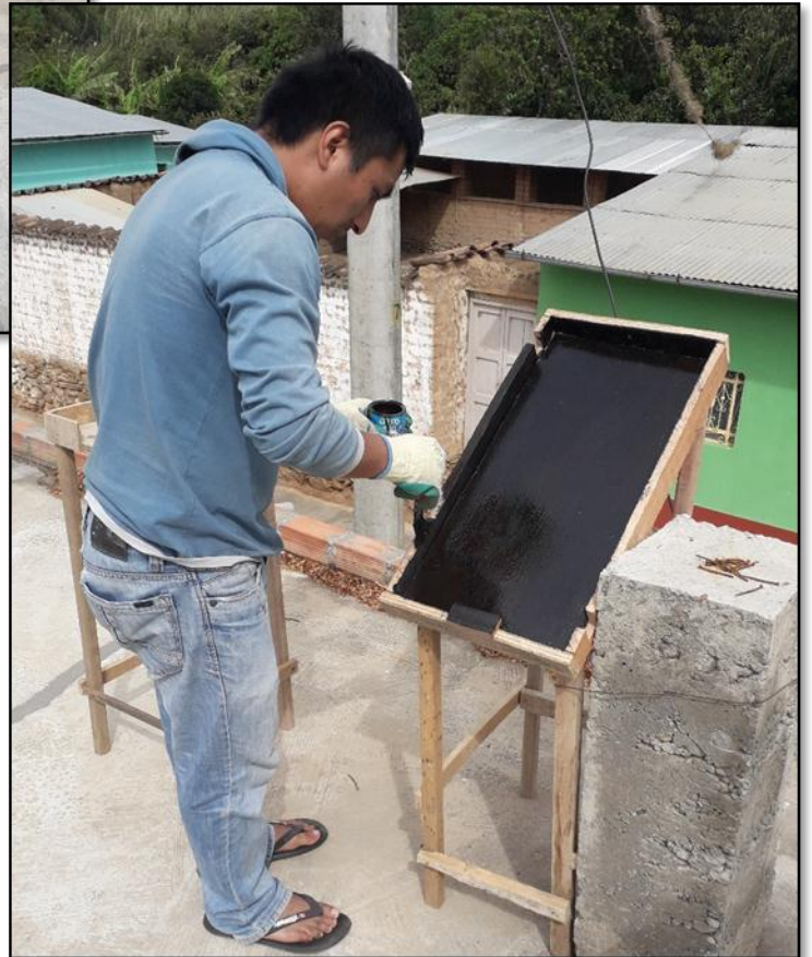
IMAGEN N°5. Construcción de concentrador solar
