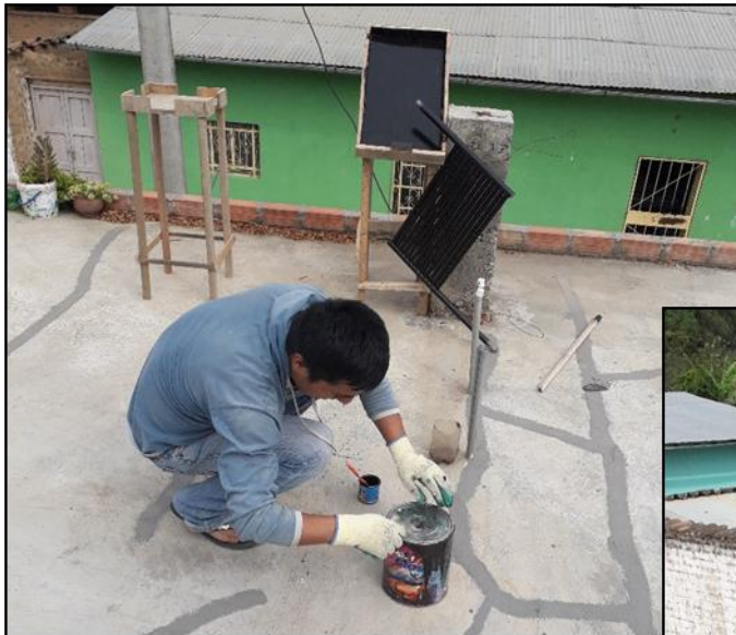
IMAGEN N°4. Construcción de concentrador solar
