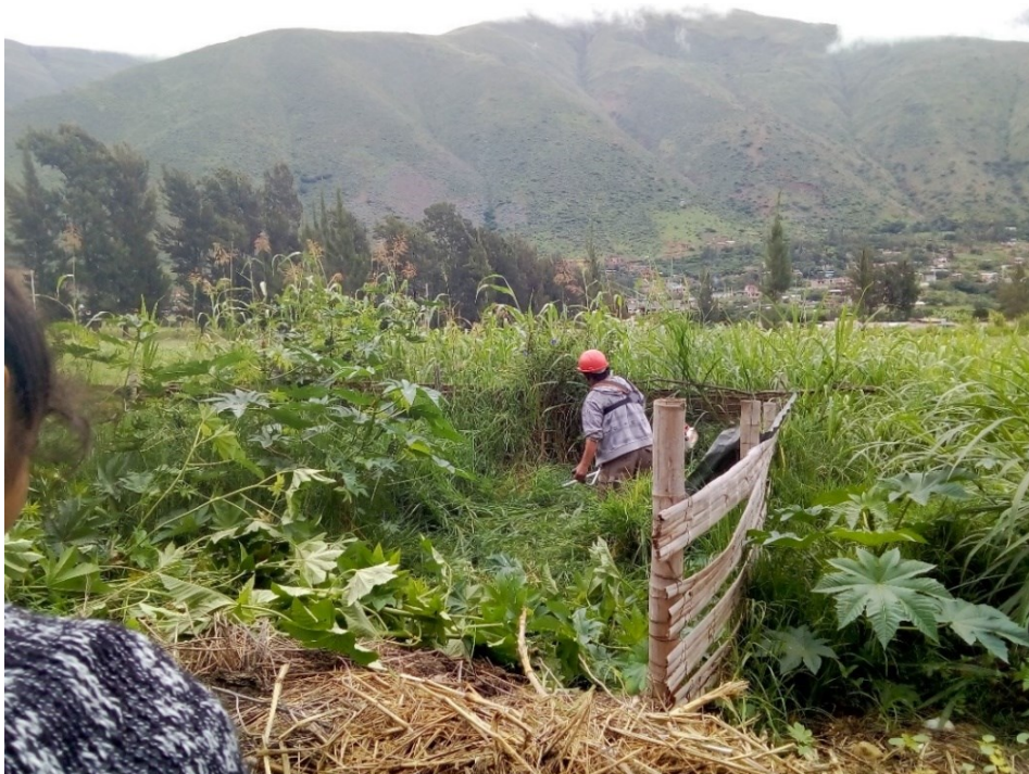
FOTOGRAFIA 25: Habilitación del área de compostaje
