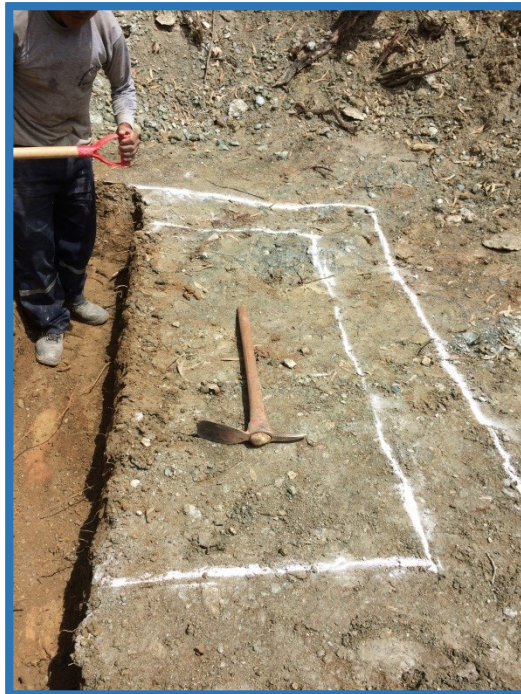
Trazo para la excavación de cimiento de los ubs.
