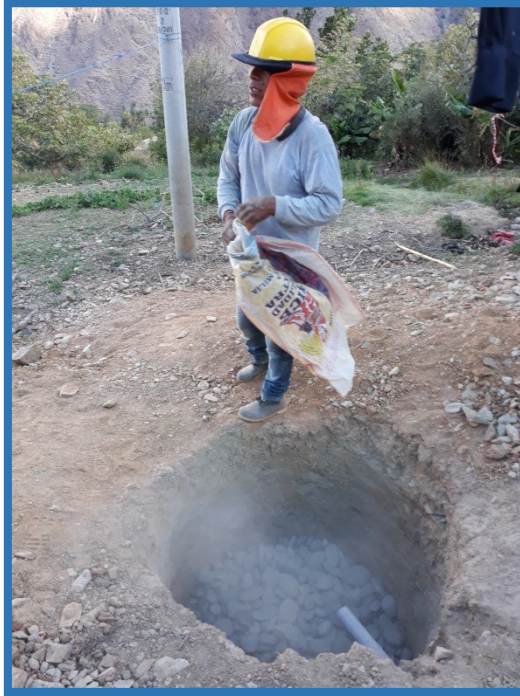
Personal obrero en acarreo de grava seleccionada para el llenado de los pozos de percolación o filtros.
