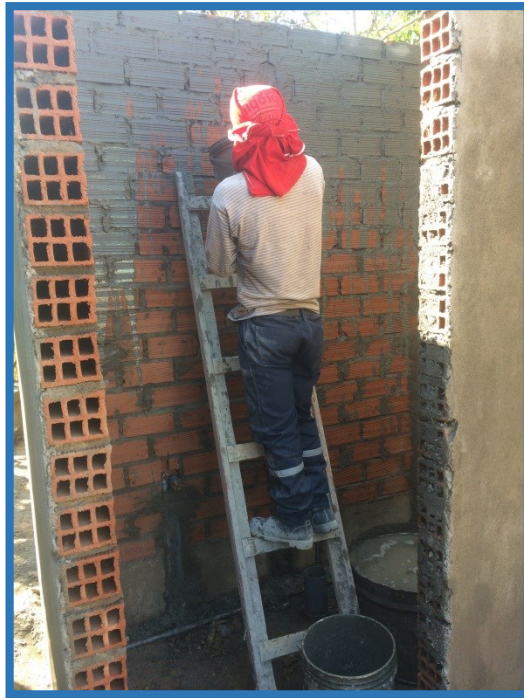
Tarrajeo de Muros de ladrilo en los respectivos UBS.
