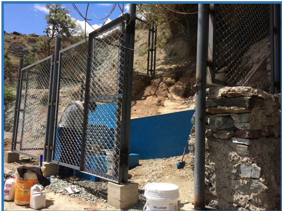
Captación 03 zona B concluida con su respectivo cerco perimétrico.
