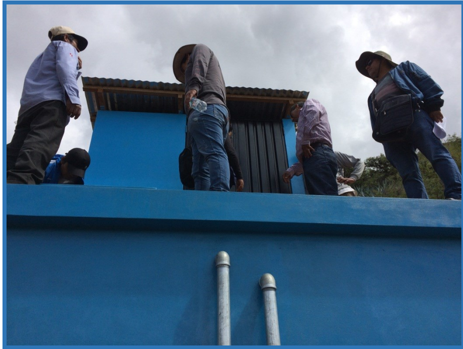
Entrega de obra a la municipalidad.
