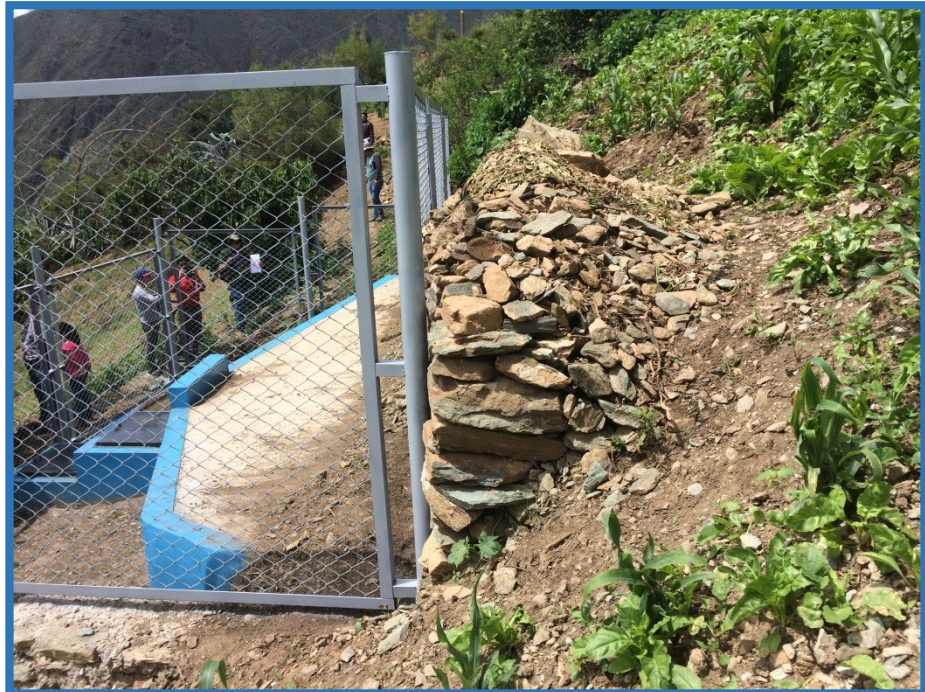
Captación 02 zona A concluida con su respectivo cerco perimétrico.
