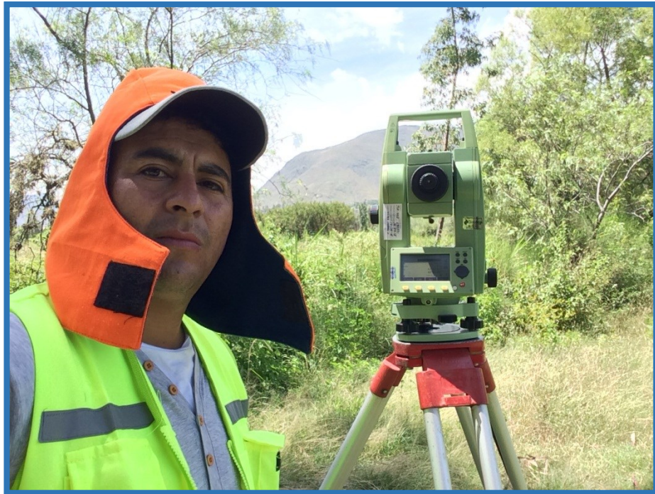
Trazo y replanteo de línea de conducción, aducción y redes de distribución.
