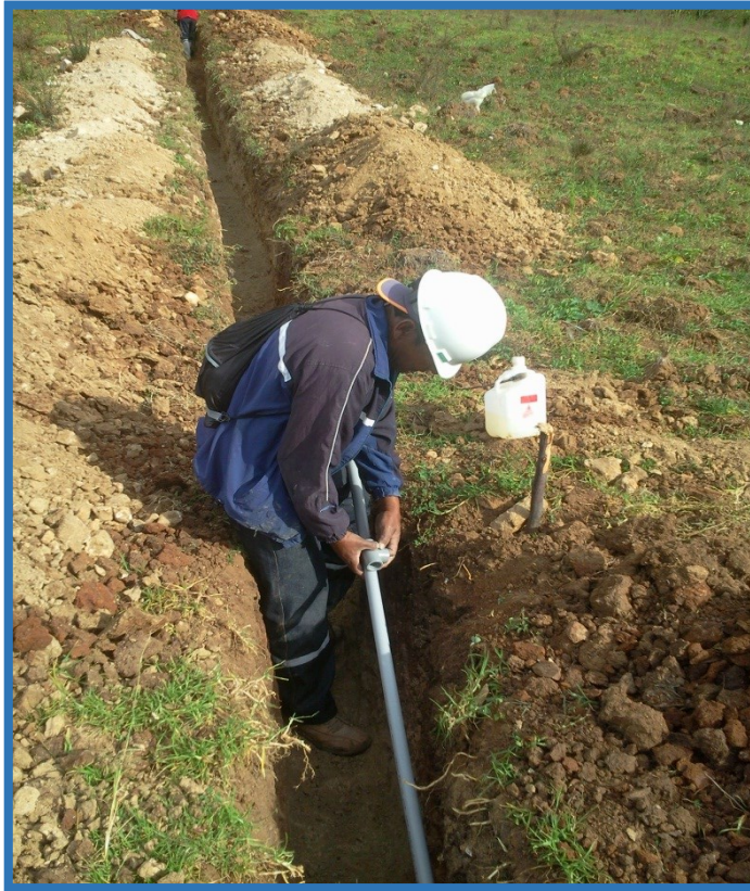
Operario en instalación y tendidos de tubería para agua potable.
