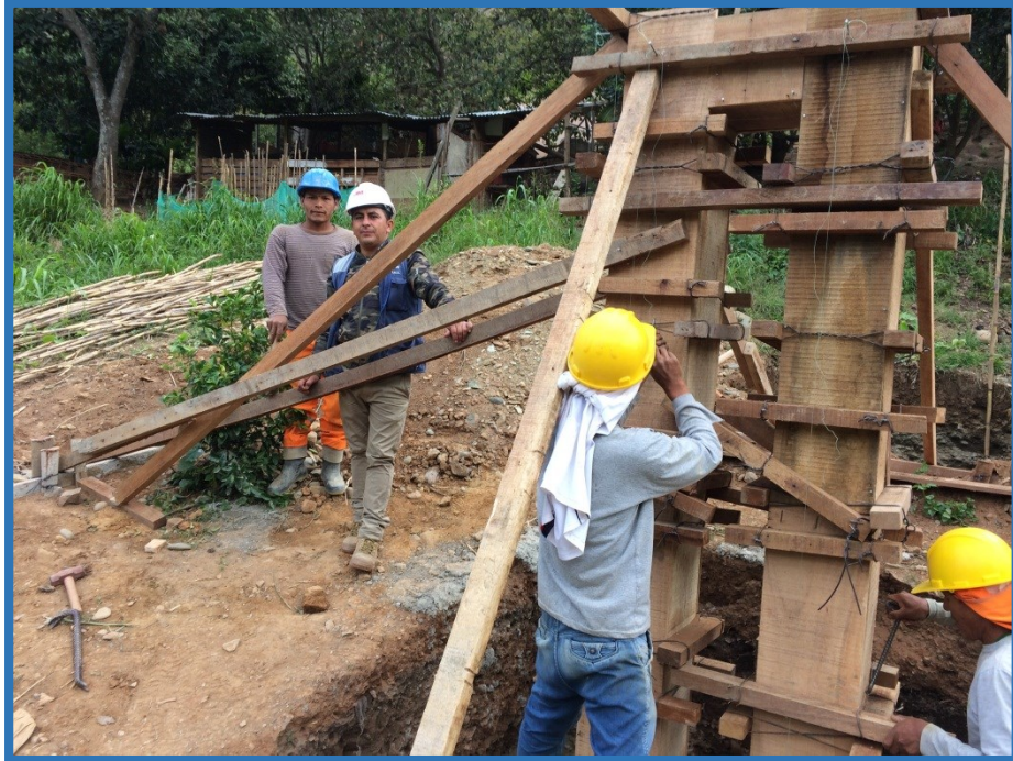
Encofrado de columnas para los pases aéreos.
