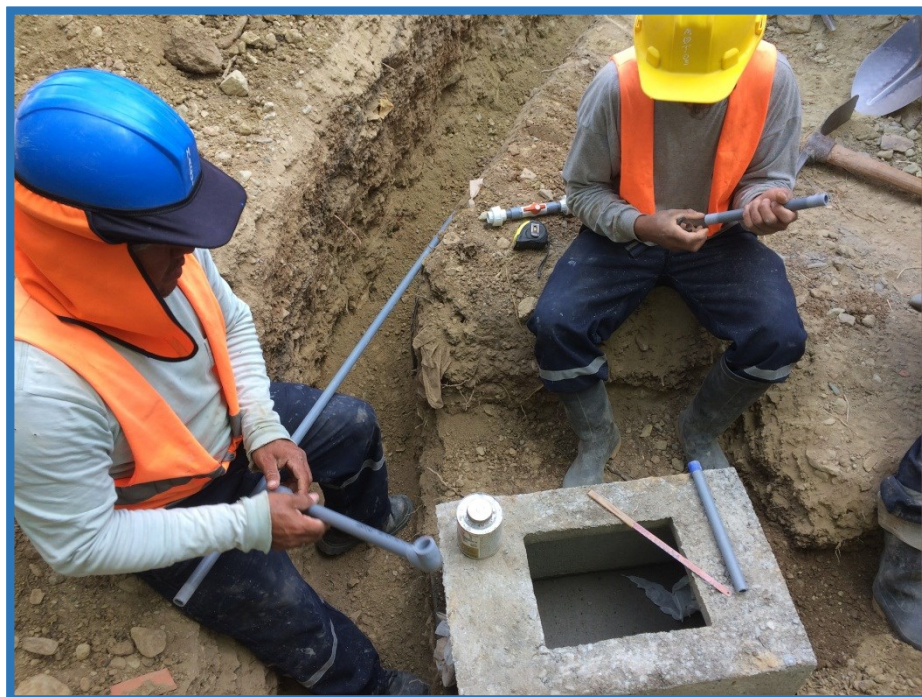
Colocación de cajas de agua y su respectiva conexión domiciliaria para cada UBS.
