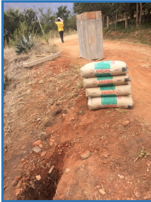
Acarreo de Cemento para la construcción de cajas de válvulas de aire, purga, VRP y control.
