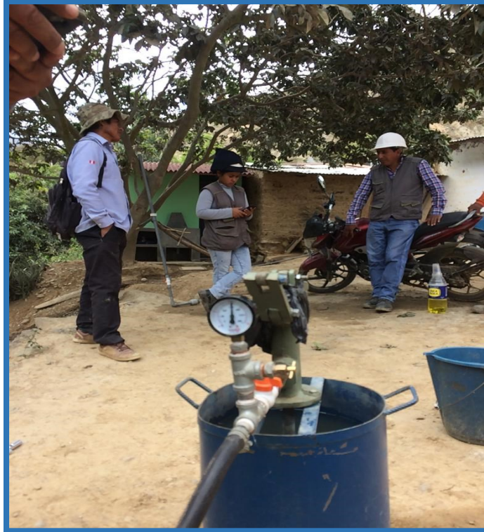
Prueba Hidráulica con la presencia del JAS del caserío Huanquilla.
