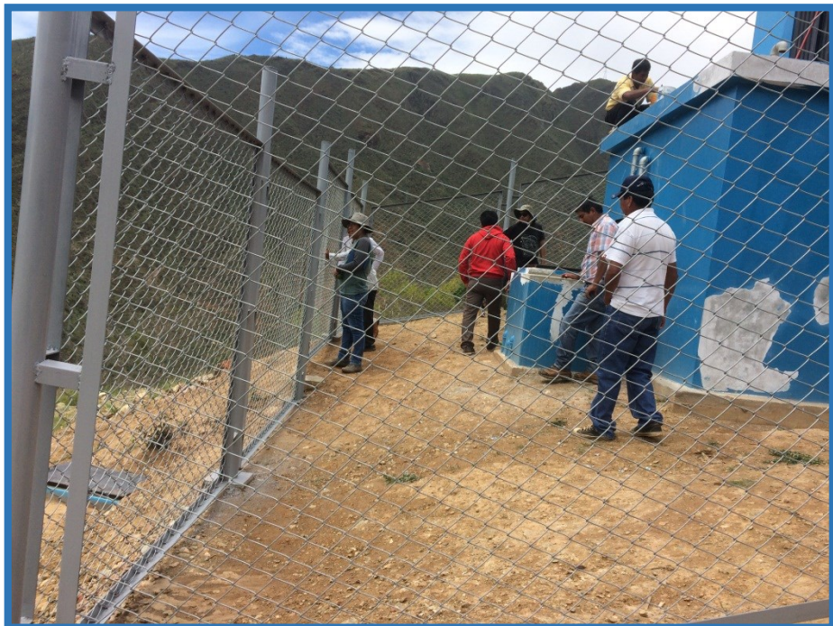
Reservorio 02 zona B culminado pintura, cerco perimétrico.
