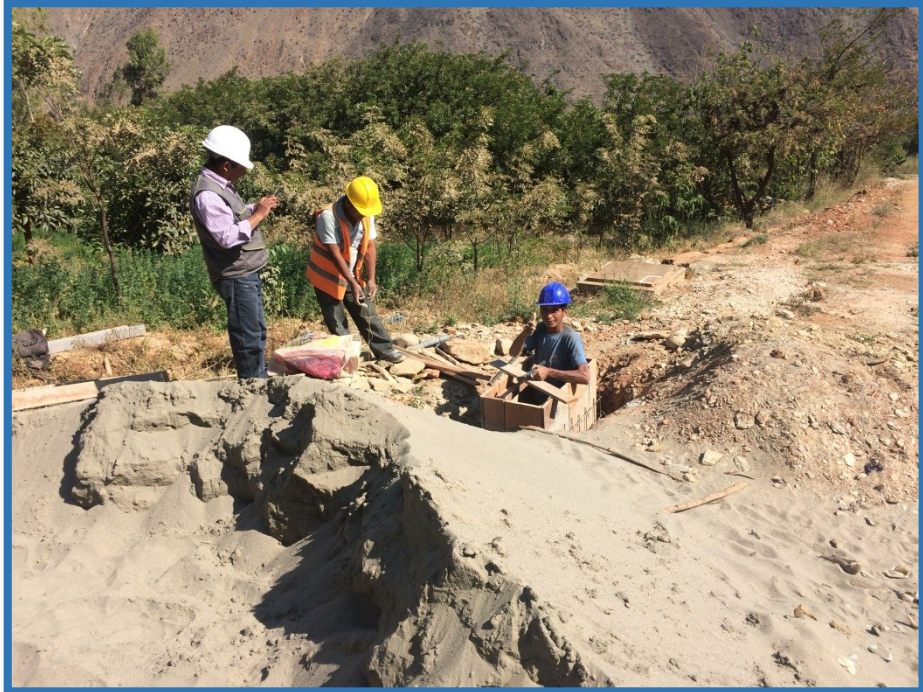
Encofrad de cajas de válvulas de aire, purga, VRP y control.
