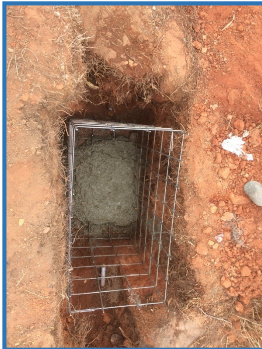
Llenado de concreto de cajas de válvulas de aire, purga, VRP y control.
