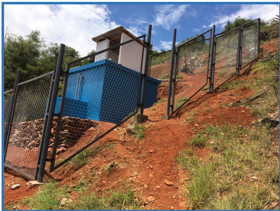
Reservorio 01 zona A concluido pintado y su respectivo cerco perimétrico
