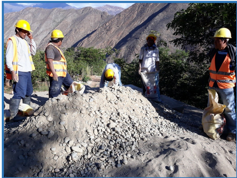
Personal obrero en acarreo de grava seleccionada para los pozos de percolación o filtros.
