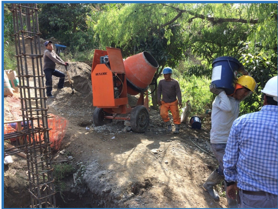
Llenado de concreto para columnas de pase aéreo.
