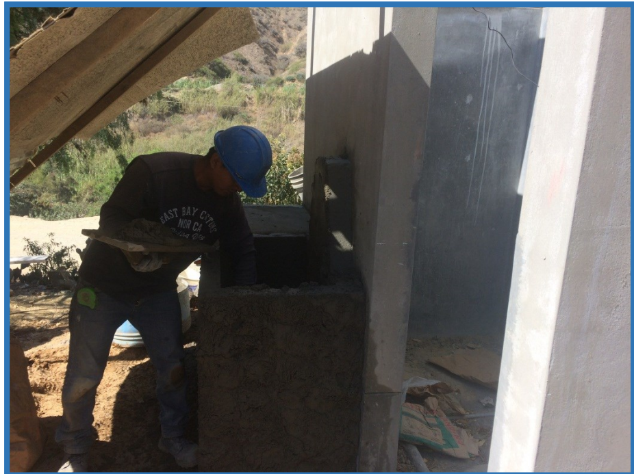
Tarrajeo de lavaderos en los respectivos UBS.
