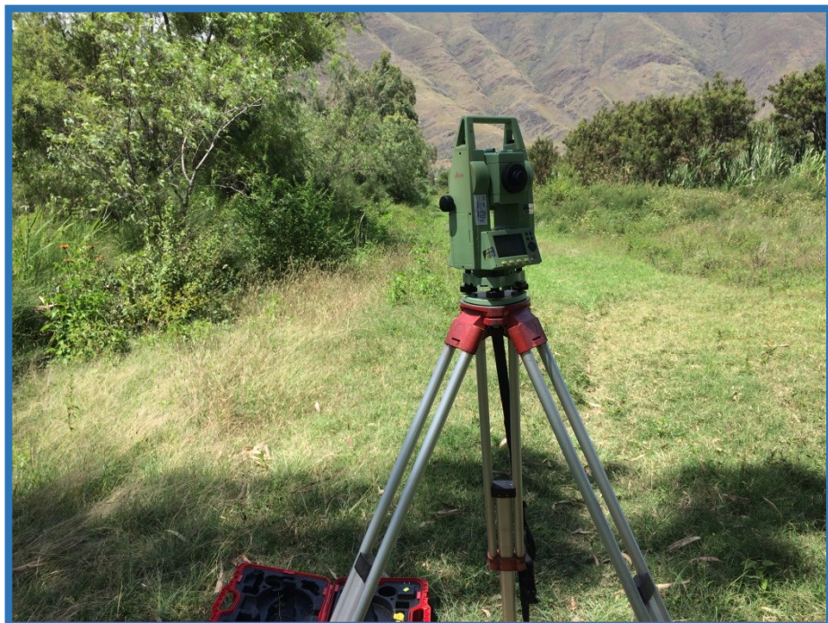
Equipo utilizado para replanteo estación total leica.
