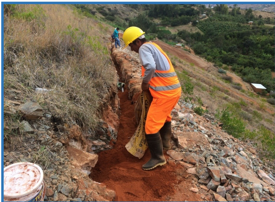
Acarreo y llenado de material zarandeado para cama de apoyo.
