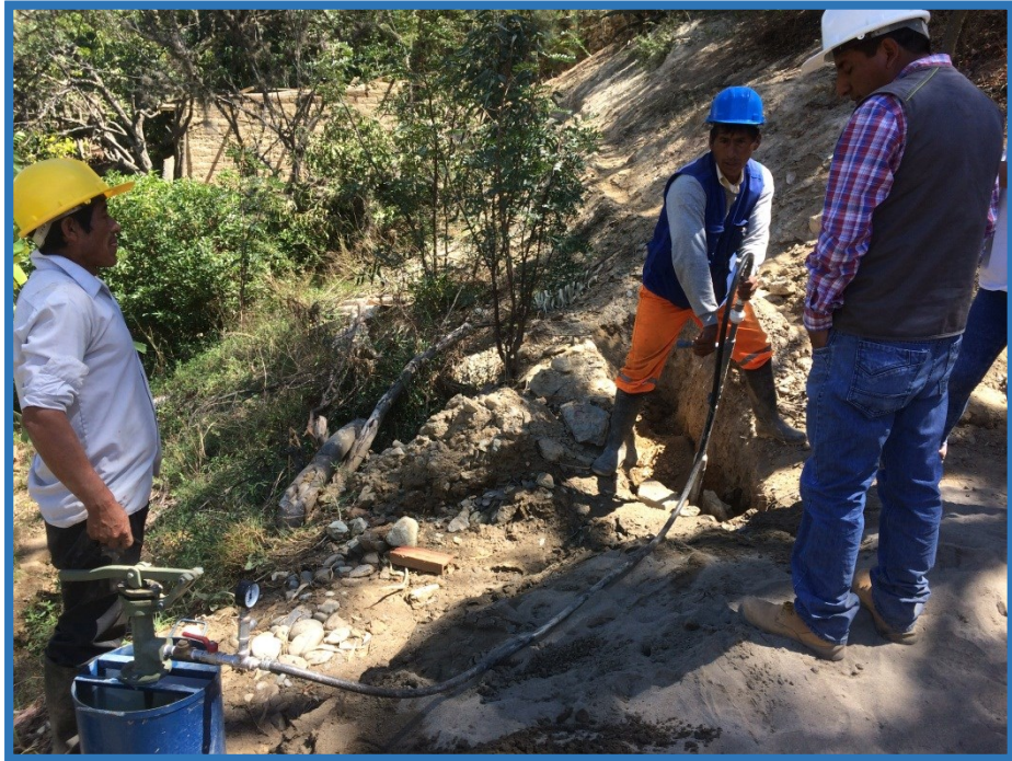
Operario haciendo las pruebas hidráulicas.
