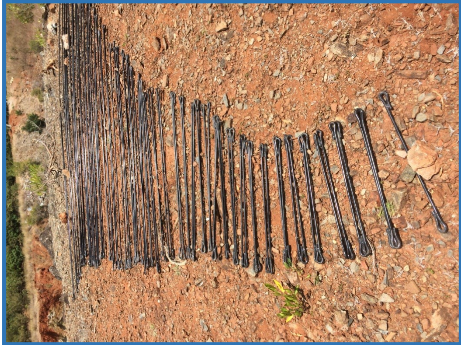
Distribución de péndolas para llevar el correcto colocado en los cables tipo boa de los pases aéreos.
