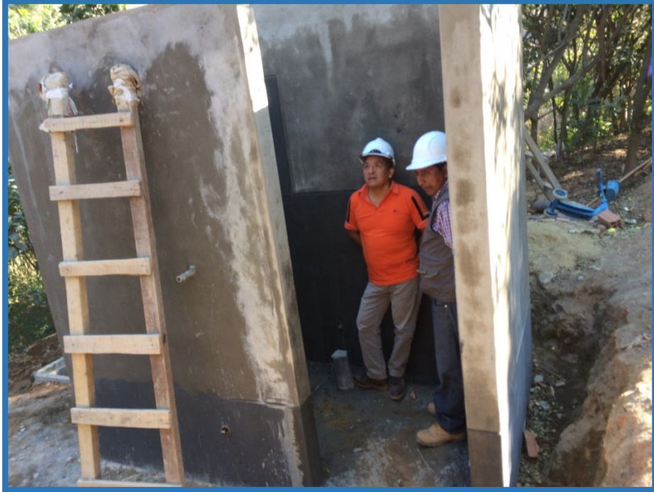
Presencia del Residente de obra verificando los tarrajeos respectivos en los UBS.
