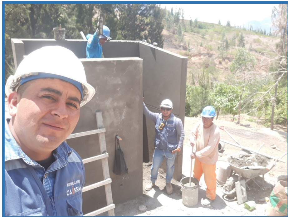
Presencia de los asistentes de obra en el Tarrajeo de Muros de ladrilo en los respectivos UBS.
