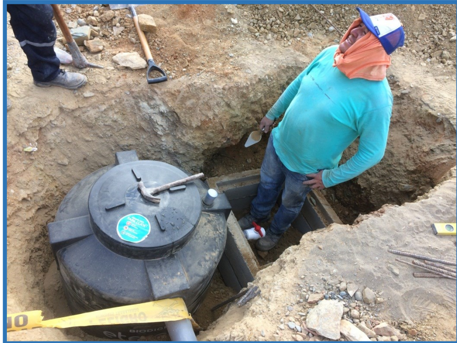
Instalación de biodigestores con sus respectivos accesorios y caja de lodos.
