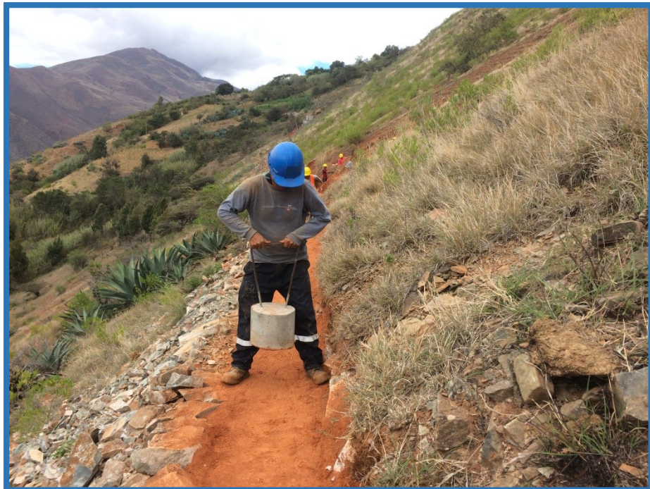
Relleno y compactado manual de zanjas.
