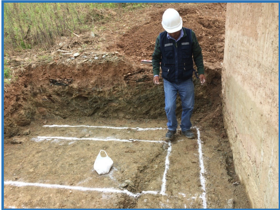
Trazo para la excavación de cimiento de los ubs.
