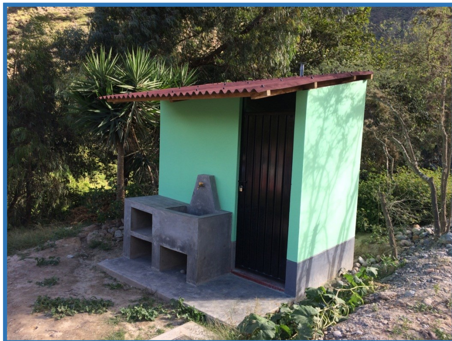
UBSconcluido pintado techado, pulido.
