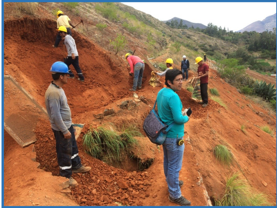
Presencia del supervisor de obra para ver los trabajos de relleno de zanjas
