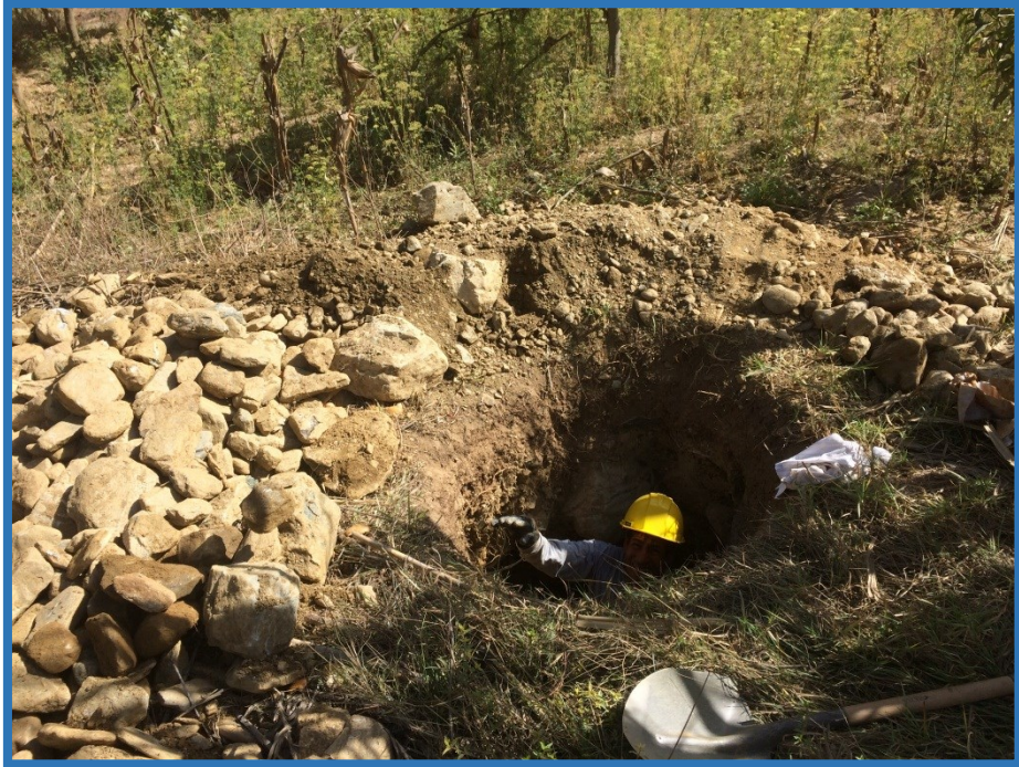
Excavación de pozos circulares de 1 metro de diámetro por 2 metros de profundidad para los filtros.
