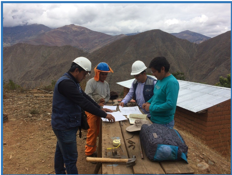
Coordinación del supervisor de obra con los asistentes de obra para ver la habilitación del acero con el respectivo operario.
