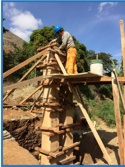
Llenado de concreto para columnas de pase aéreo.
