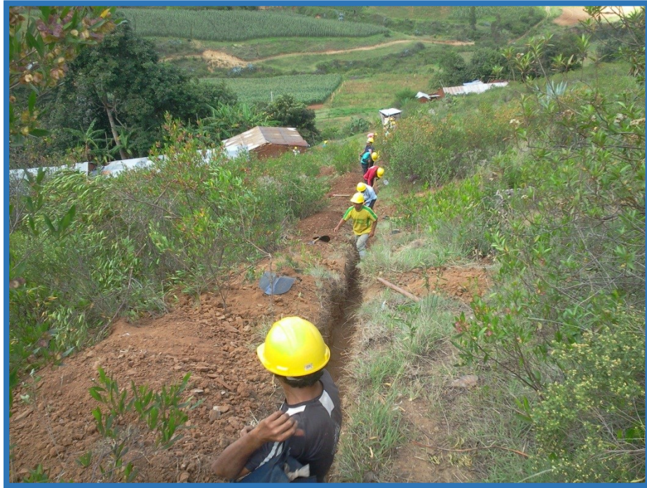
Personal obrero en excavación manual de zanjas.
