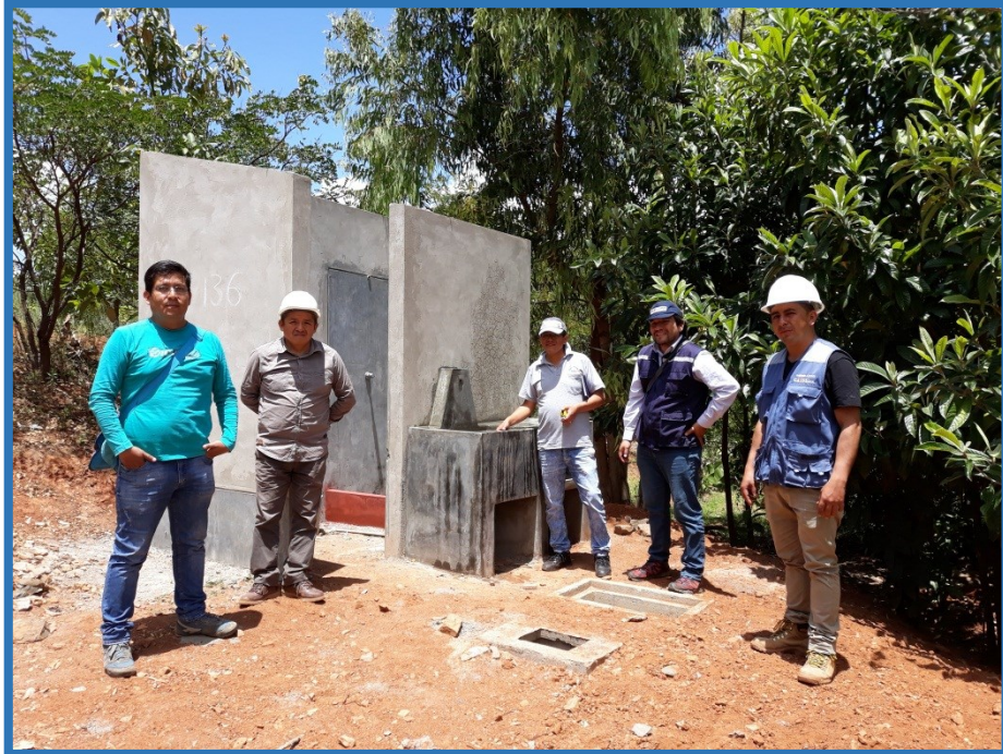
Presencia del Ingeniero del ministerio de vivienda, Ing. de la municipalidad, supervisor, residente y asistente de obra.
