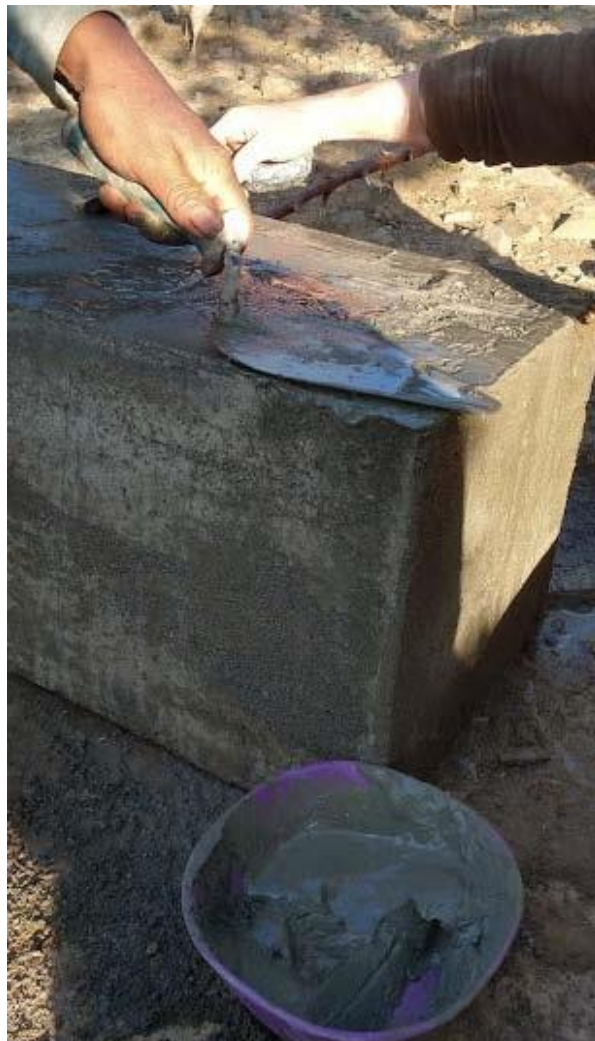
Figura 10. Reparaciones de las grietas o salidas de agua
