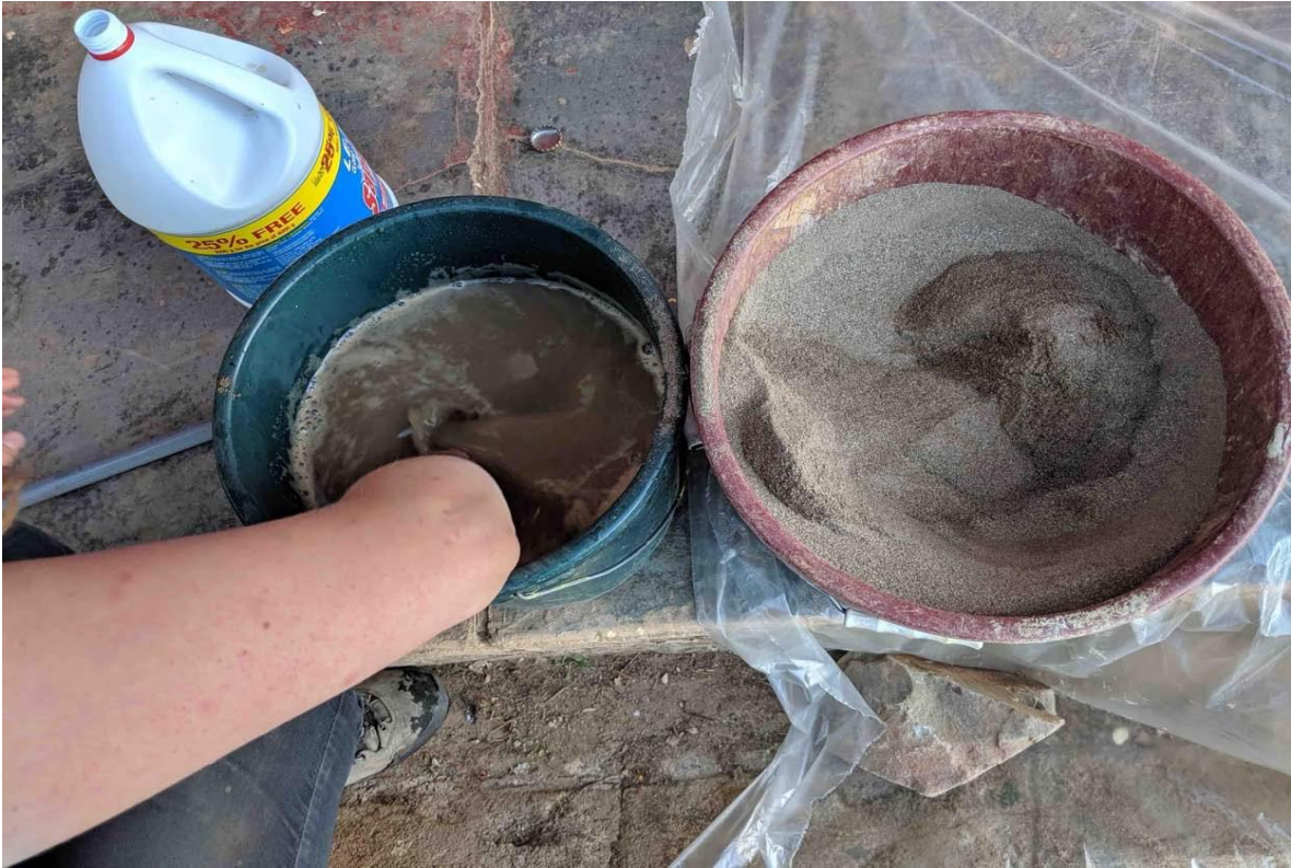
Figura 13. Lavado de la arena fina, gruesa y piedra chancada
