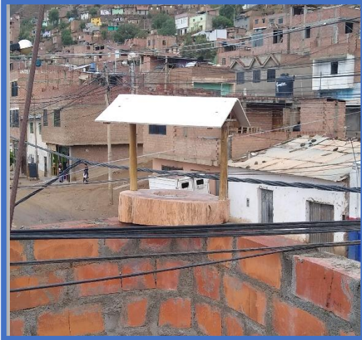
Estación de monitoreo del PAS
