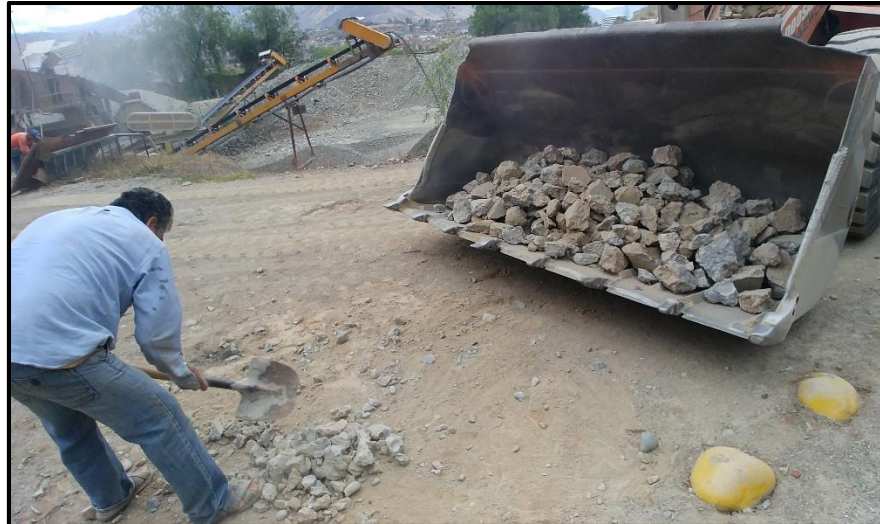
Foto 4. Carguío de tanda de bloques de concreto reciclado de vías peatonales
