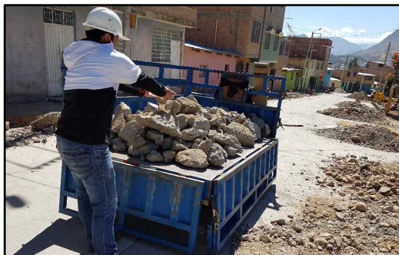
Foto 3. Recolección de bloques rotos de concreto de vías peatonales, en jr Circunvalación
