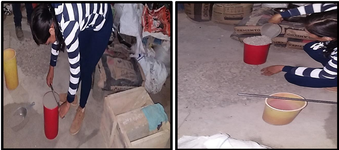
Figura 3.10: Enrasado de los agregados
