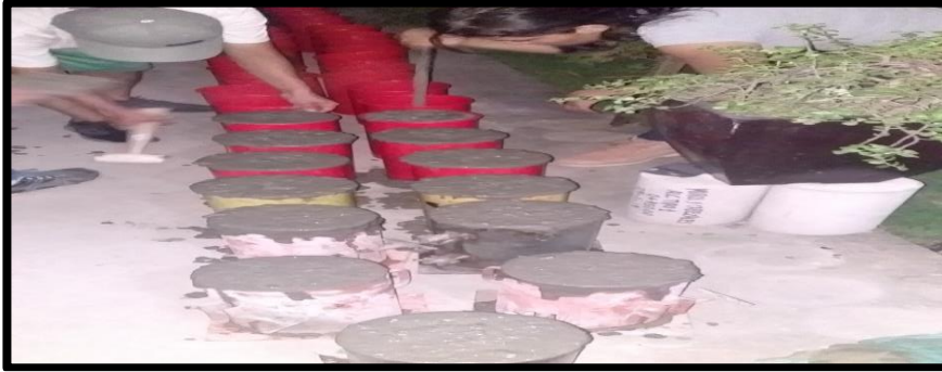
Figura 3.15: Colocación de la mezcla en los moldes
