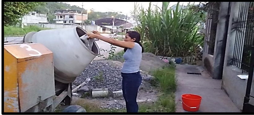
Figura 3.12: Elaboración de mezcla de concreto
