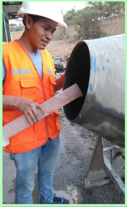
IMAGEN N°08: se procede a añadir agua con una probeta graduada para una resistencia del concreto 210 kg/cm 2 .
