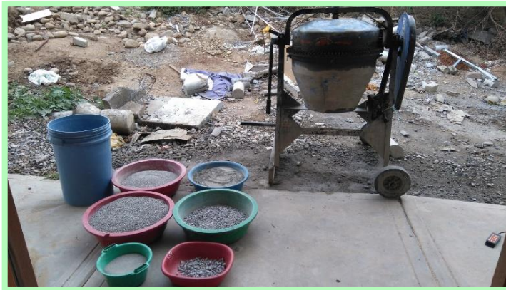
IMAGEN N°06: en la imagen se observa agregado listo para la elaboración del concreto con resistencia 210 kg/cm 2 .
