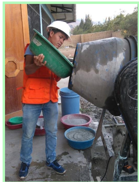
IMAGEN N°07: en la imagen se observa el proceso de preparación de la mezcla para un concreto de resistencia 210 kg/cm 2 .
