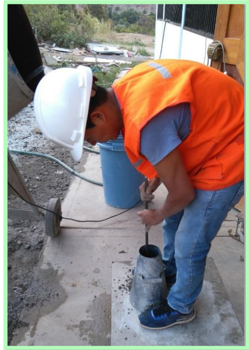
IMAGEN N°09: a continuación, se realiza e ensayo de cono de abrams, se realiza el varillado como lo indica la norma ASTM.
