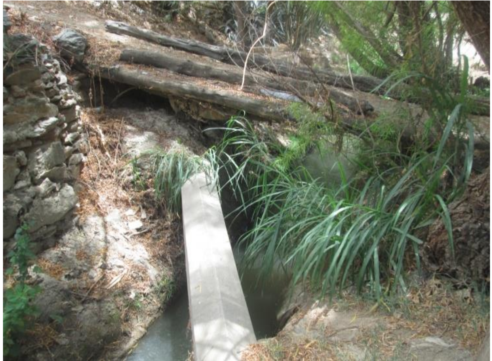
Figura 14: Línea de conducción hacia el río Huallaga.
