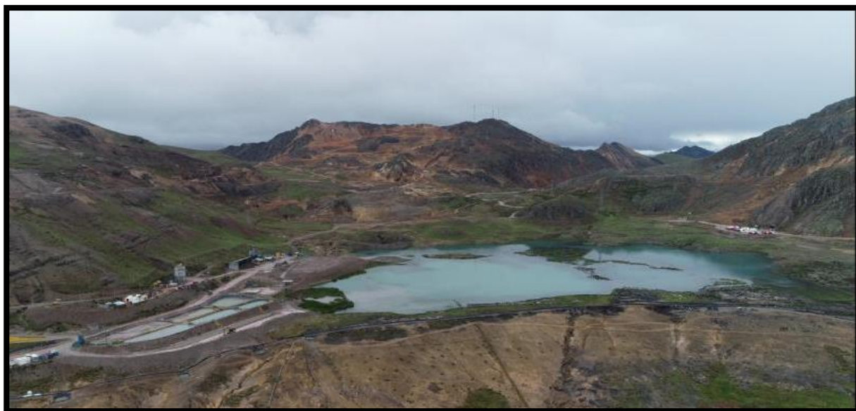
Vista fotográfica 08: Laguna Naticocha Norte y la Planta de agua residual industrial
