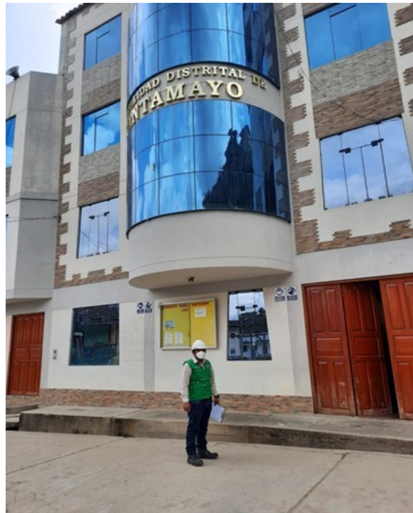
Figura N° 4 Coordinación y autorización con las autoridades de la Municipalidad Distrital de Tantamayo para la ejecución de investigación por el tesista
