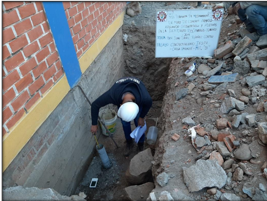
Foto n° 9 Medición de agua filtrada por el suelo
