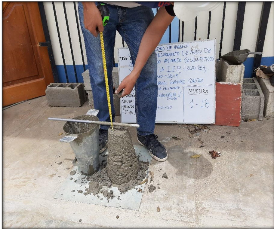
Foto n° 17 Determinación del asentamiento de la mezcla fresca (slump)
