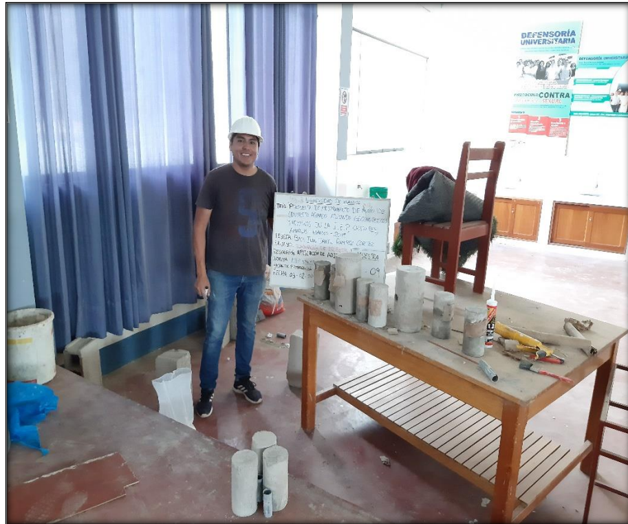
Foto n° 25 Sellado a un extremo de las probetas a aplicar el aditivo grout de alta resistencia
