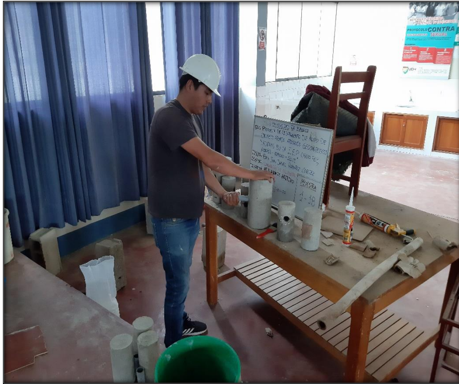
Foto n° 23 Retiro de la tubería pvc 1" para la aplicación del puente de adherencia sikadur 32 y luego el aditivo grout de alta resistencia
