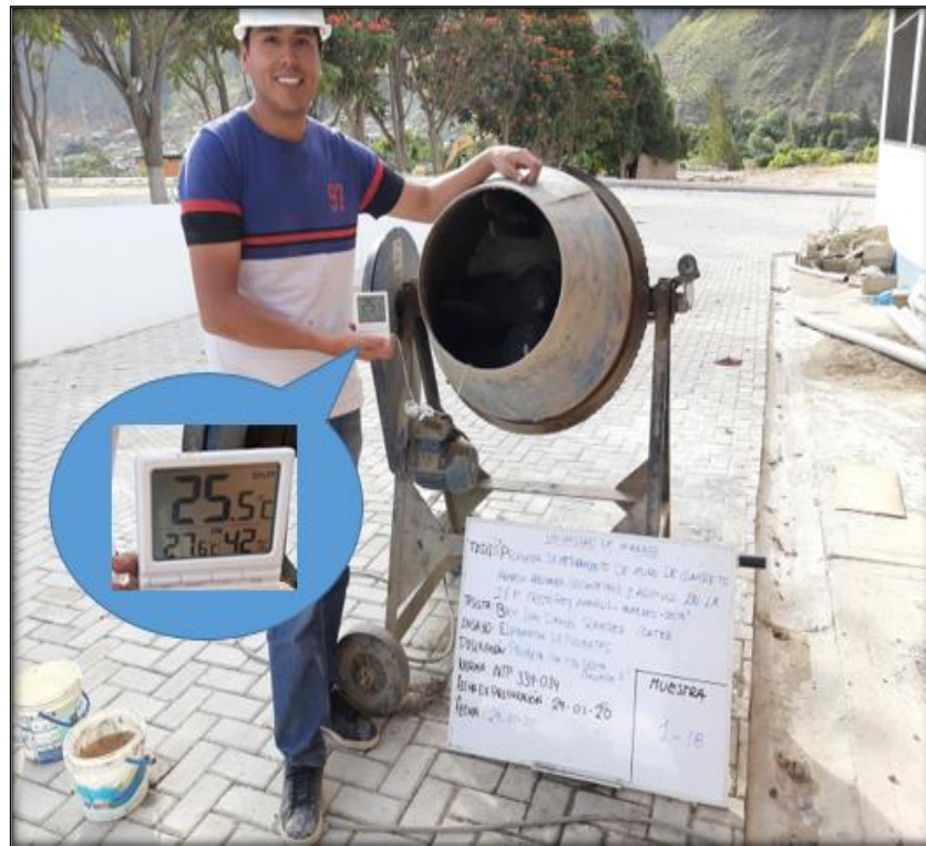
Foto n° 19 Control de la temperatura en estado fresco
