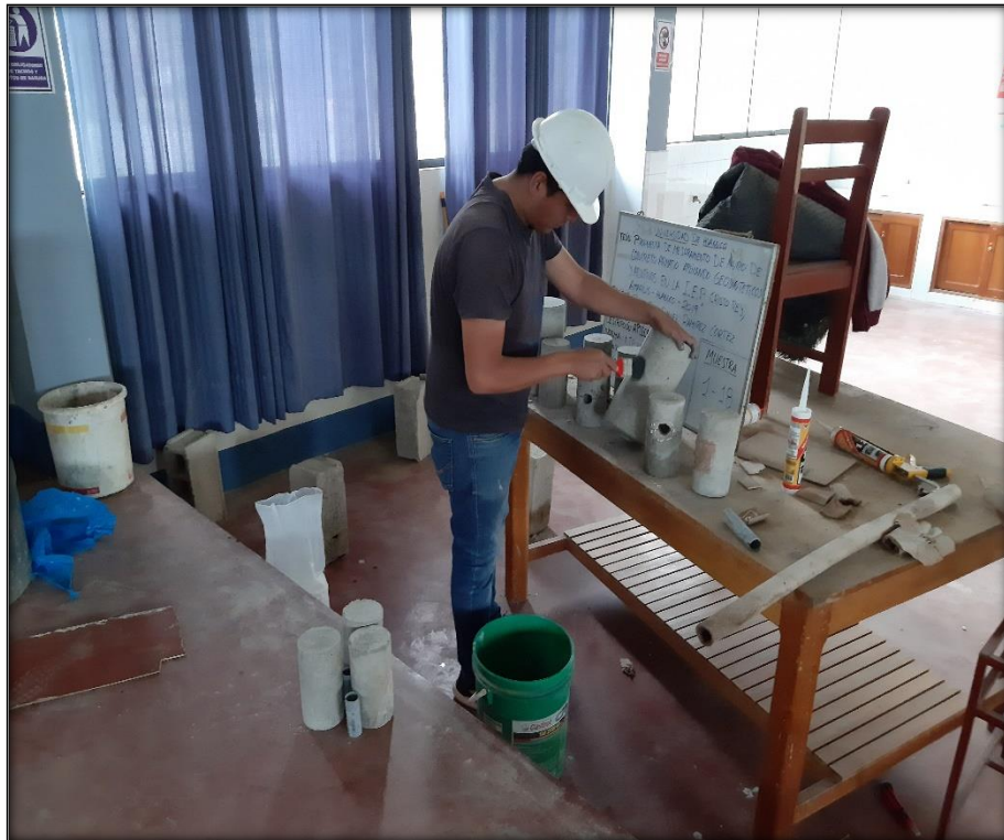
Foto n° 24 Aplicación del aditivo de puente de adherencia sikadur gel 32
