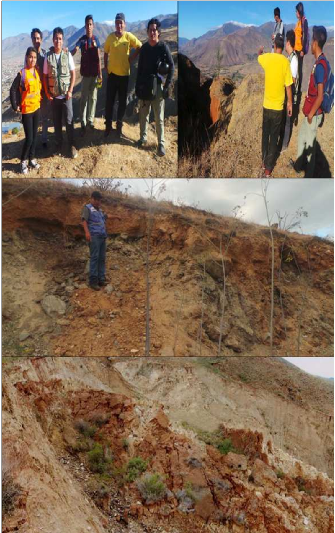
Fotografía 1: Reconocimiento de terreno y deslizamiento de suelo en la parte alta del A.A.H.H. La Florida – Huánuco.
