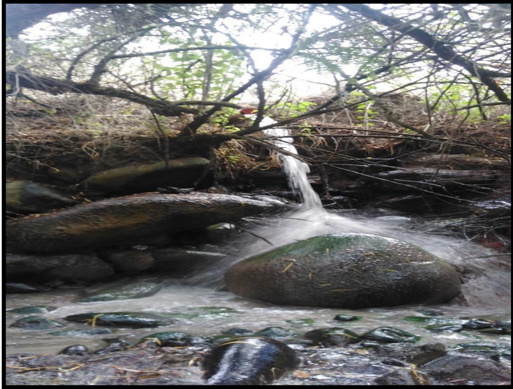
Fotografía 3 Punto de descarga de agua residual de la PTAR
