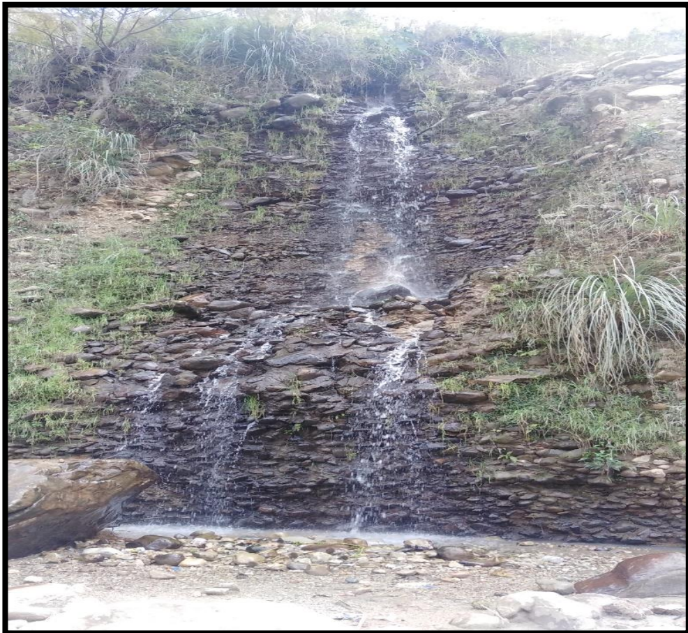
Fotografía 4 Descarga de agua contaminada
