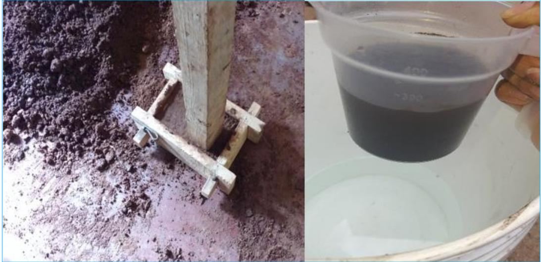
**Fotografía 10. Selección de 1m<sup>3</sup> de tierra y la dosificación de 250ml de aditivo impermeabilizante perma-zyme diluido en agua y elaboración del adobe**
