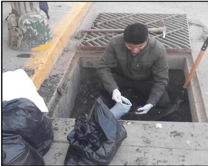
Extracción de la primera muestra de una de las cámaras de recolección de aguas pluviales en la Av. 28 de agosto.
