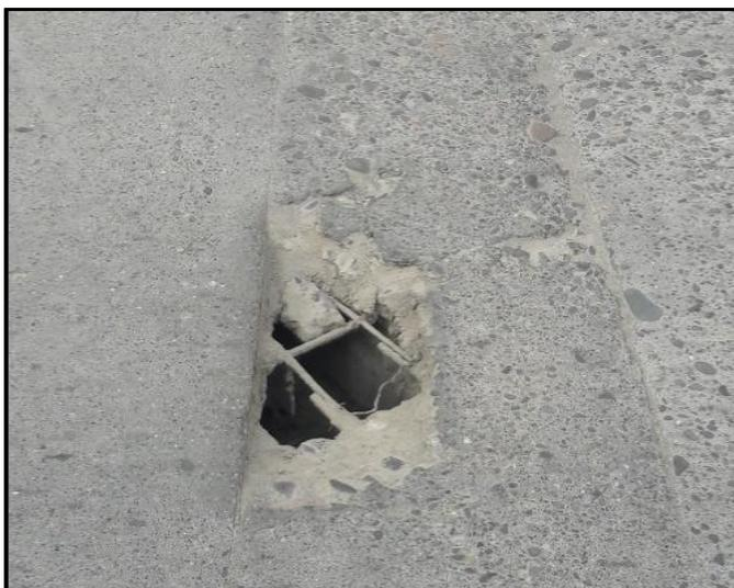
Colector pluvial con revestimiento deteriorado.
