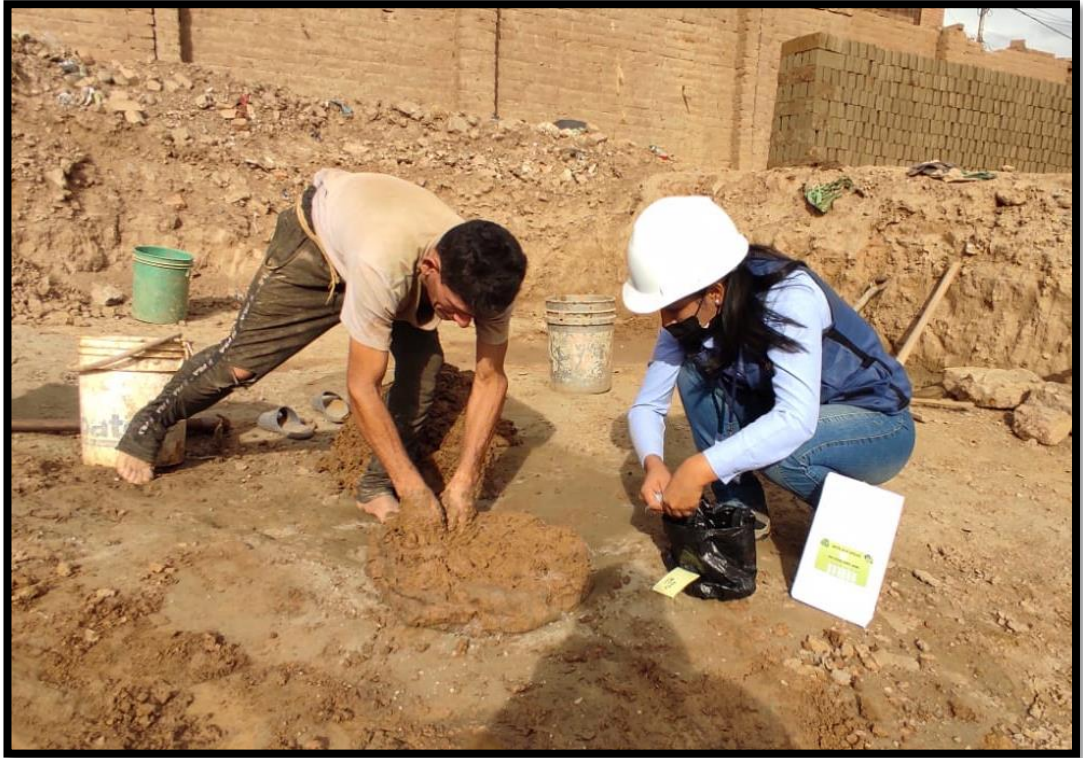
Foto 9: Mezcla de la arcilla y agua.
