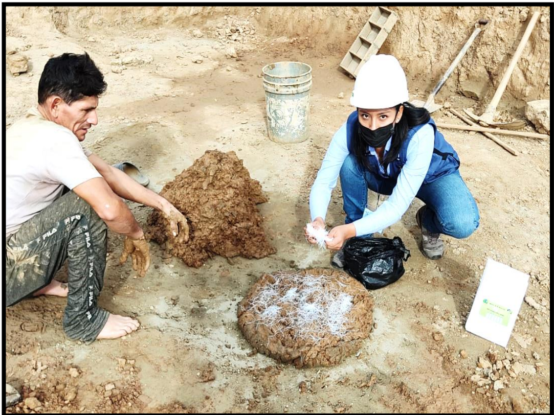
Foto 10: Añadimos las fibras de plástico según su concentración.
