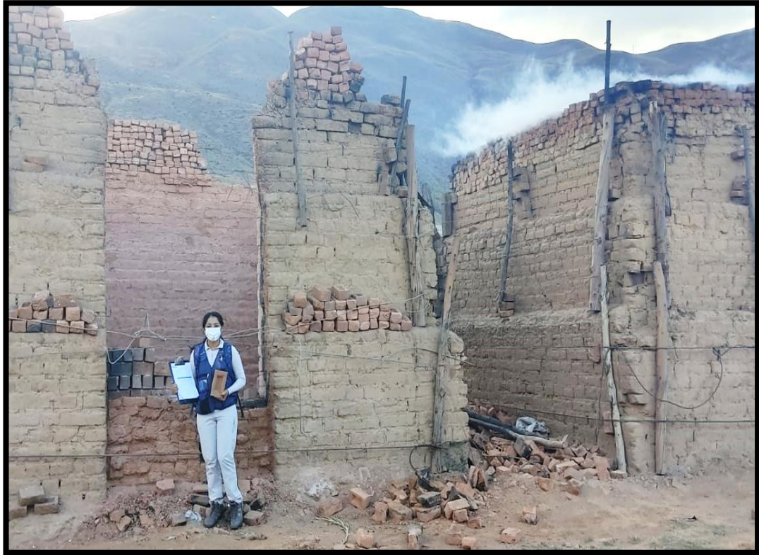
Foto 13: Retiramos los ladrillos ecológicos y su cocción fue de 500°c
