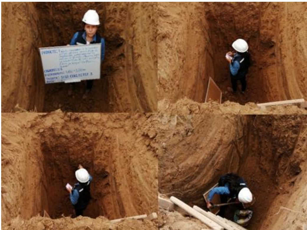
Foto N°06. En las fotografías se aprecia el reconocimiento directo del terreno, así como la toma de muestras de la calicata N°04.
