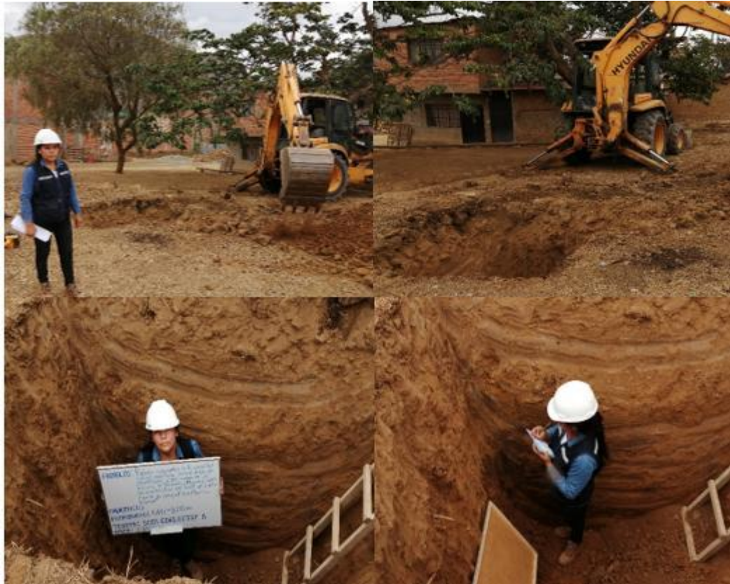
Foto N° 05. En las fotografías se aprecia el reconocimiento directo del terreno, así como la toma de muestras de la calicata N°03.
