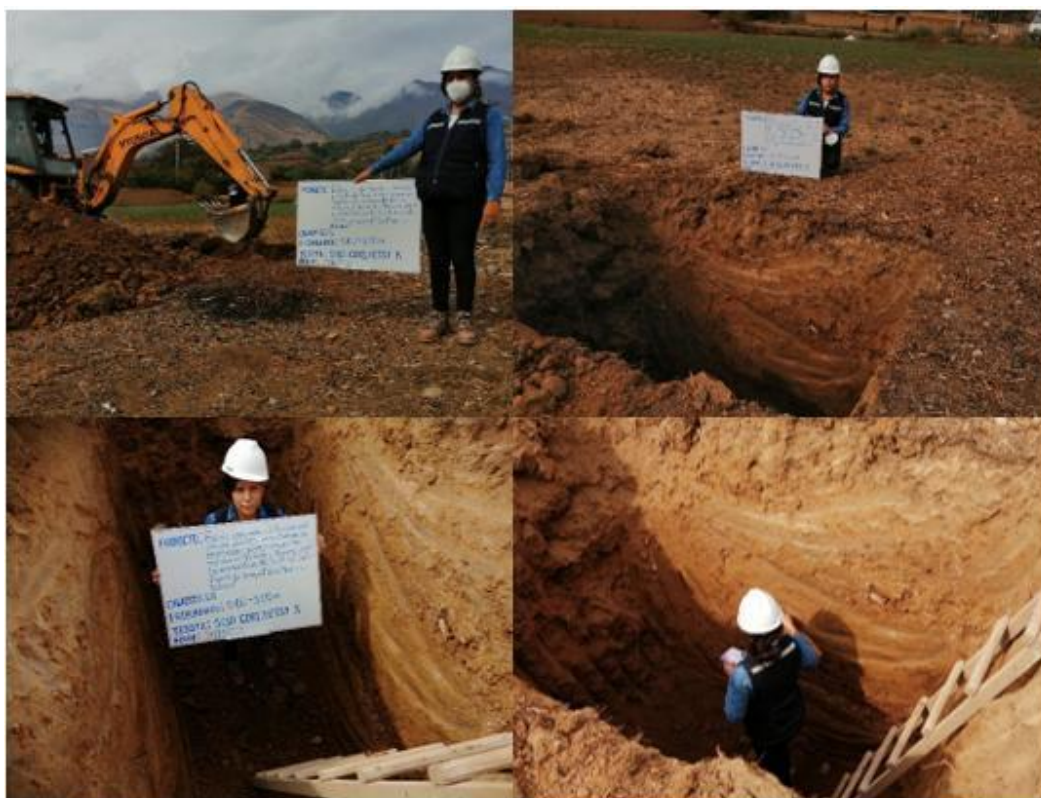
Foto N°03. En las fotografías se aprecia el reconocimiento directo del terreno, así como la toma de muestras de la calicata N°01.
