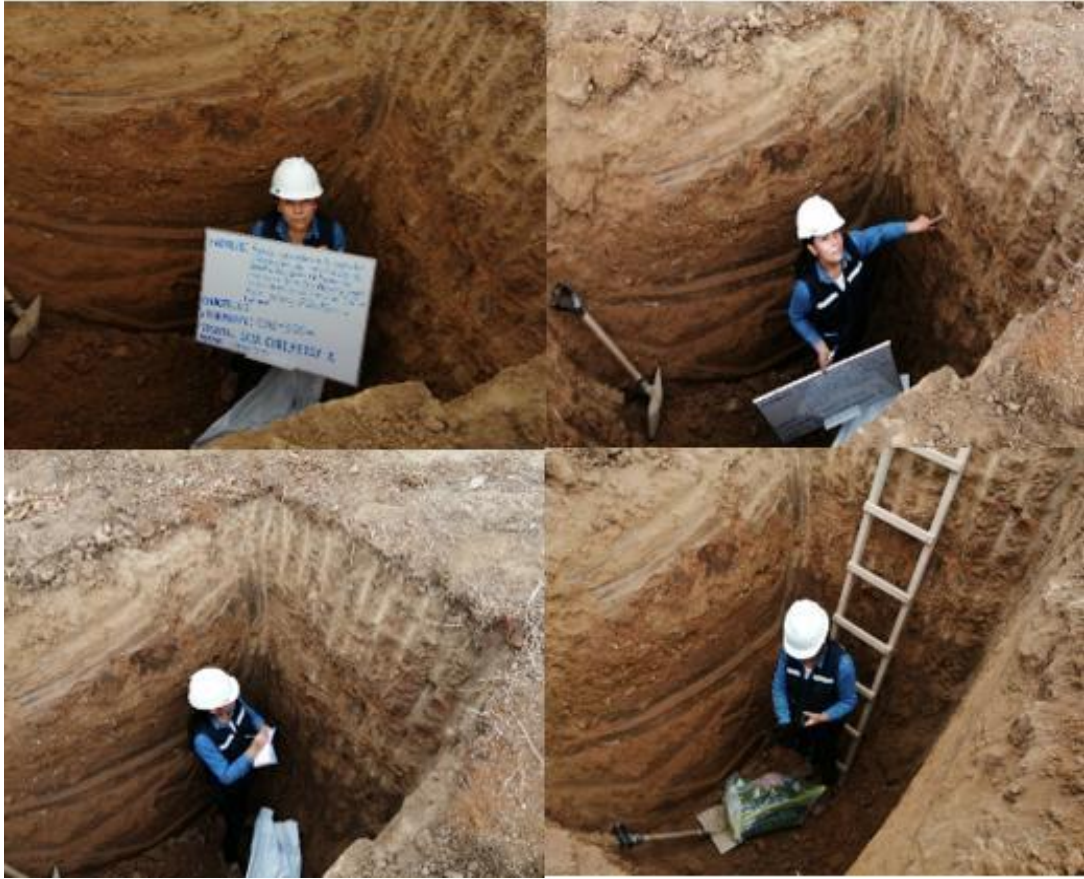
Foto N°07. En las fotografías se aprecia el reconocimiento directo del terreno, así como la toma de muestras de la calicata N°05.
