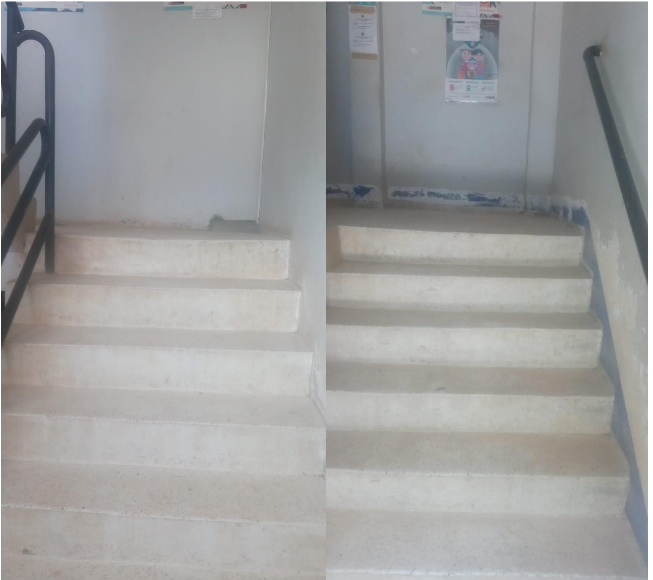
Foto 2: Se observa escaleras de acceso a las oficinas de la Segunda Fiscalía Provincial Penal Corporativa de Huamalés.
