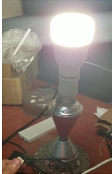
Figura 52: Foco encendido mediante el Servidor OpenHab
