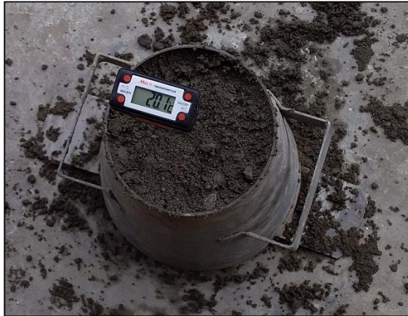
Fotografía 39 Control de temperatura del concreto
