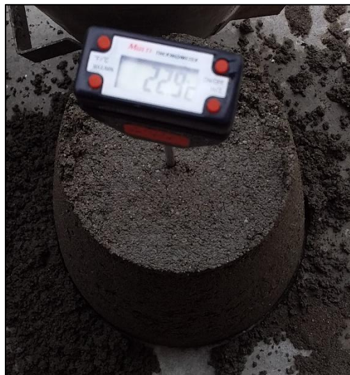
Fotografía 40 Control de temperatura del concreto
