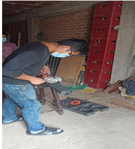
Corte de tubería para canaletas
