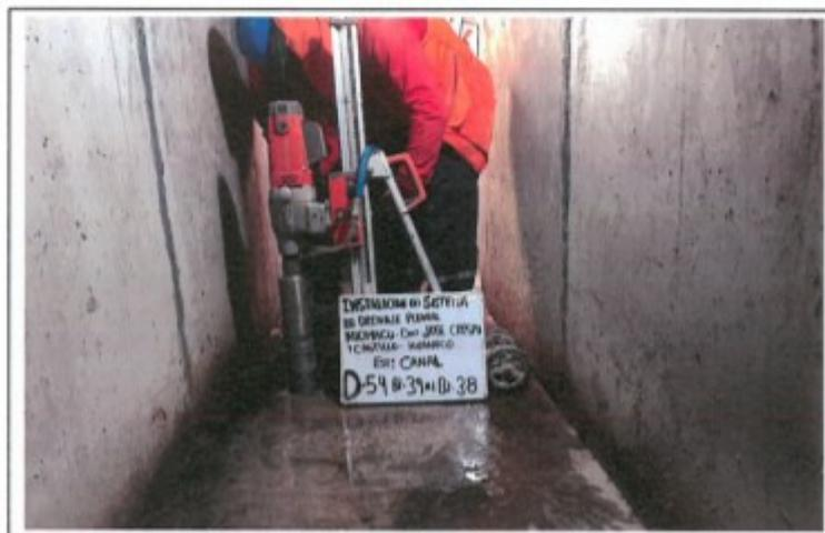
FOTO. 134.- PERFORACION DEL TESTIGO DIAMANTINO N° 54, D-54, CANAL BZ-39 AL BZ-38
