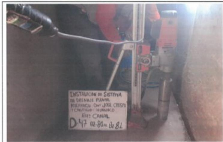
FOTO. 106.- PERFORACION DEL TESTIGO DIAMANTINO N° 47, D-47, CANAL BZ-80 AL BZ-81
