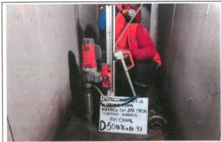
FOTO. 118.- PERFORACION DEL TESTIGO DIAMANTINO N° 50, D-50, CANAL BZ-96 AL BZ-97
