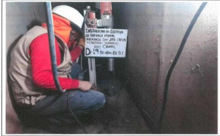
FOTO. 35.- EXTRACCION DEL TESTIGO DIAMANTINO N° 19, D-19, CANAL BZ-118 AL BZ-53
