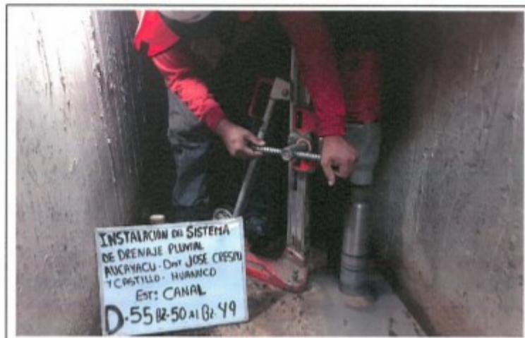
FOTO. 138.- PERFORACION DEL TESTIGO DIAMANTINO N° 55, D-55, CANAL BZ-50 AL BZ-49
