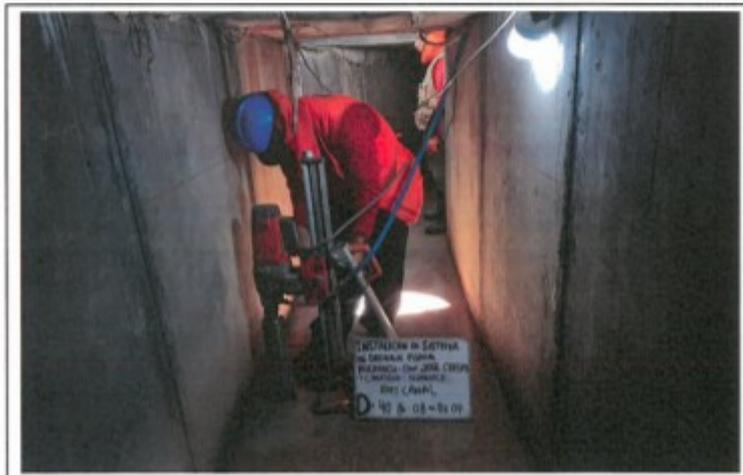
FOTO. 78.- PERFORACION DEL TESTIGO DIAMANTINO N° 40, D-40, CANAL BZ-08 AL BZ-07
