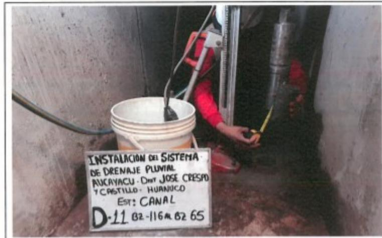
FOTO. 20.- MEDICION TESTIGO DIAMANTINA N° 11, D-11, CANAL BZ-116 AL BZ-65
