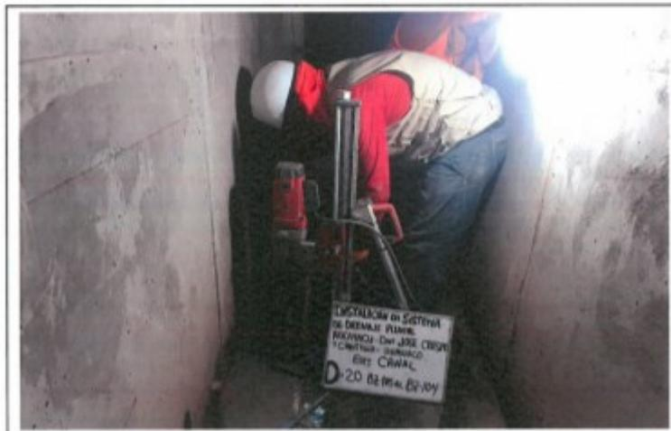
FOTO. 38.- PERFORACION DEL TESTIGO DIAMANTINO N° 20, D-20, CANAL BZ-105 AL BZ-104
