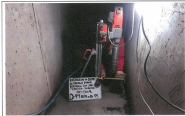
FOTO. 116.- MEDICION TESTIGO DIAMANTINA N° 49, D-49, CANAL BZ-94 AL BZ-95
