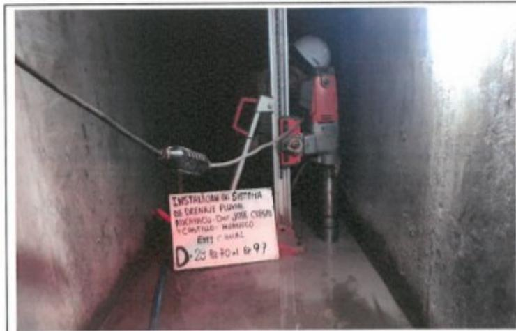
FOTO. 54.- PERFORACION DEL TESTIGO DIAMANTINO N° 28, D-28, CANAL BZ-70 AL BZ-99
