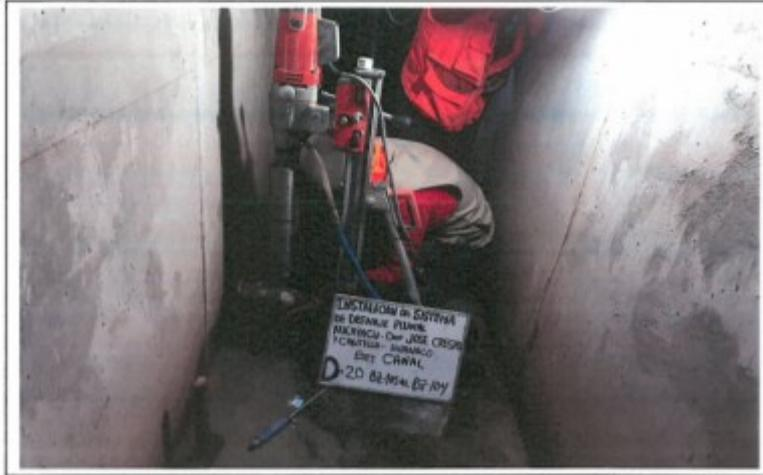
FOTO. 39.- EXTRACCION DEL TESTIGO DIAMANTINO N° 20, D-20, CANAL BZ-105 AL BZ-104
