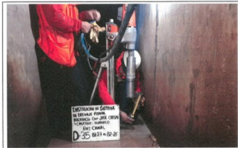
FOTO. 68.- MEDICION TESTIGO DIAMANTINA N° 35, D-35, CANAL BZ-27 AL BZ-26
