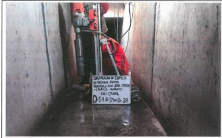
FOTO. 135.- EXTRACCION DEL TESTIGO DIAMANTINO N° 54, D-54, CANAL BZ-39 AL BZ-38
