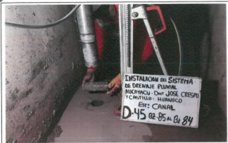
FOTO. 99.- EXTRACCION DEL TESTIGO DIAMANTINO N° 45, D-45, CANAL BZ-85 AL BZ-84
