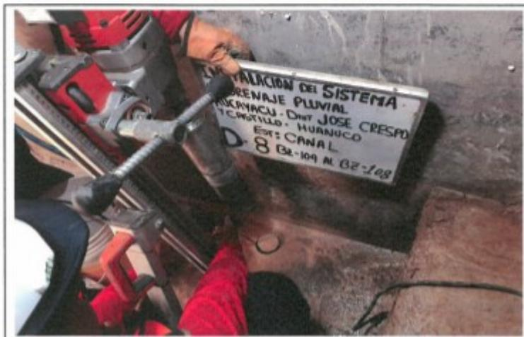
FOTO. 14.- PERFORACION DEL TESTIGO DIAMANTINO N° 08, D-8, CANAL BZ-109 AL BZ-108
