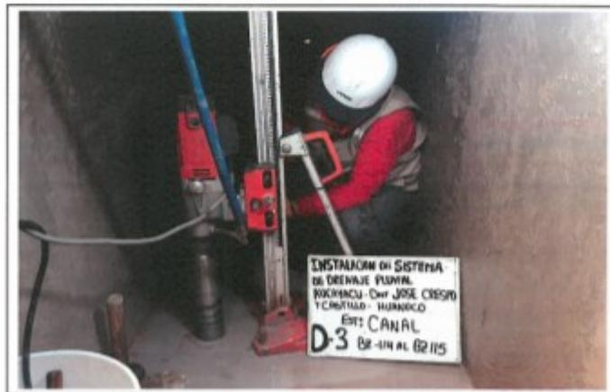
FOTO. 02.- PERFORACION DEL TESTIGO DIAMANTINO N° 03, D-3, CANAL BZ-114 AL BZ-115
