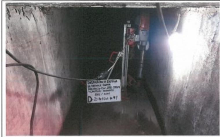
FOTO. 55.- EXTRACCION DEL TESTIGO DIAMANTINO N° 28, D-28, CANAL BZ-70 AL BZ-99
