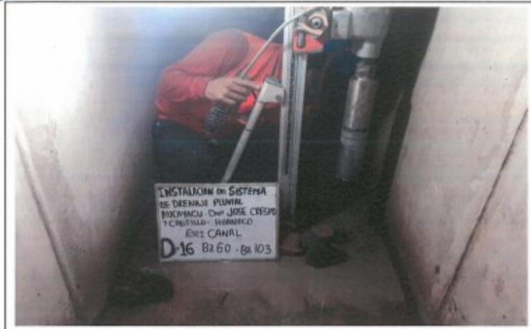
FOTO. 31.- EXTRACCION DEL TESTIGO DIAMANTINO N° 16, D-16, CANAL BZ-60 AL BZ-103
