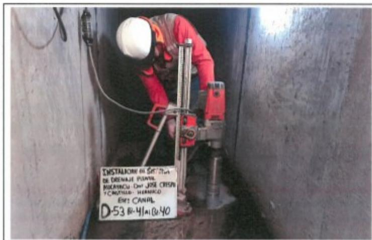
FOTO. 130.- PERFORACION DEL TESTIGO DIAMANTINO N° 53, D-53, CANAL BZ-41 AL BZ-40
