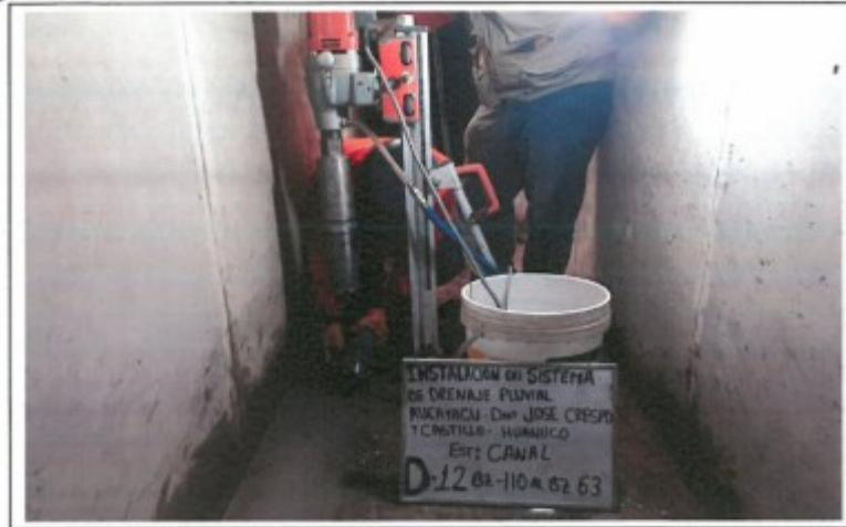
FOTO. 23.- EXTRACCION DEL TESTIGO DIAMANTINO N° 12, D-12, CANAL BZ-110 AL BZ-63
