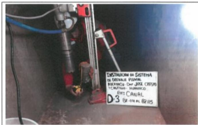
FOTO. 04.- MEDICION TESTIGO DIAMANTINA N° 03, D-3, CANAL BZ-114 AL BZ-115
