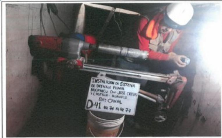
FOTO. 83.- EXTRACCION DEL TESTIGO DIAMANTINO N° 41, D-41, CANAL BZ-76 AL BZ-77
