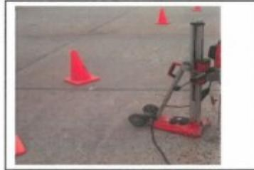
4.-Pedestal para la fijación del equipo de Diamantina
