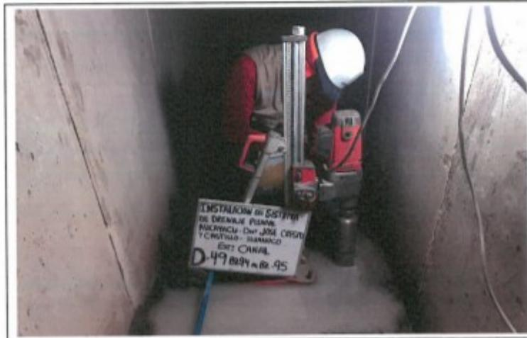
FOTO. 114.- PERFORACION DEL TESTIGO DIAMANTINO N° 49, D-49, CANAL BZ-94 AL BZ-95
