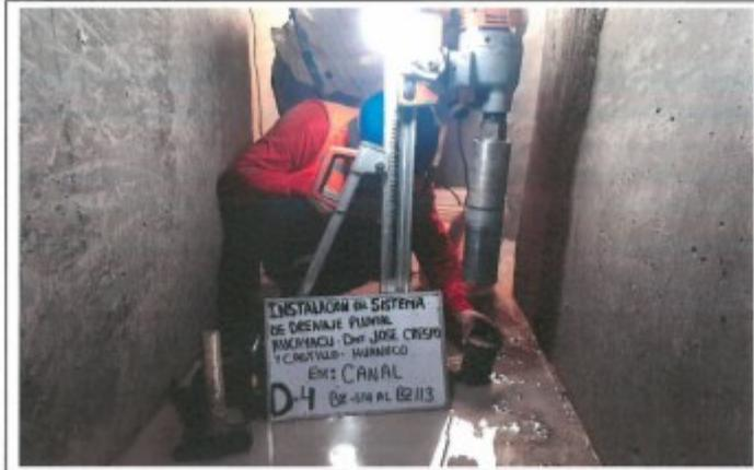
FOTO. 07.- EXTRACCION DEL TESTIGO DIAMANTINO N° 04, D-4, CANAL BZ-114 AL BZ-113
