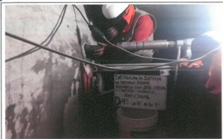
FOTO. 87.- EXTRACCION DEL TESTIGO DIAMANTINO N° 42, D-42, CANAL BZ-77 AL BZ-78
