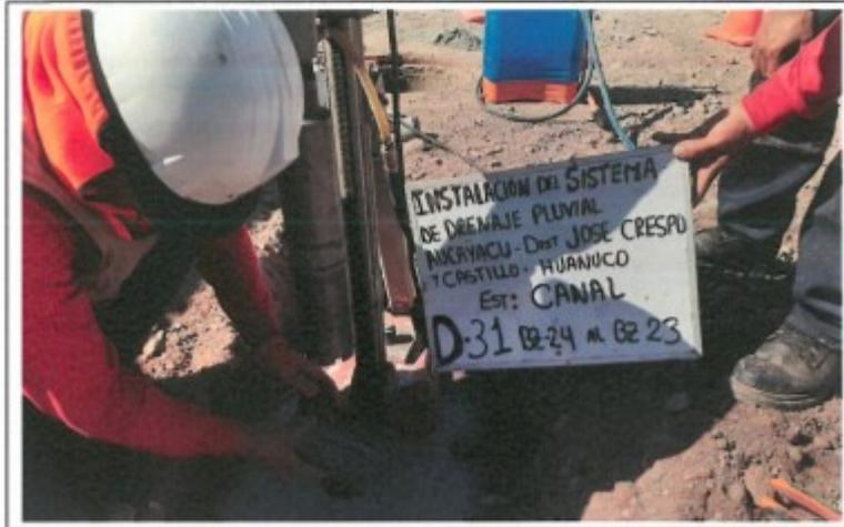
FOTO. 59.- EXTRACCION DEL TESTIGO DIAMANTINO N° 31, D-31, CANAL BZ-24 AL BZ-23
