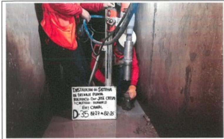
FOTO. 67.- EXTRACCION DEL TESTIGO DIAMANTINO N° 35, D-35, CANAL BZ-27 AL BZ-26
