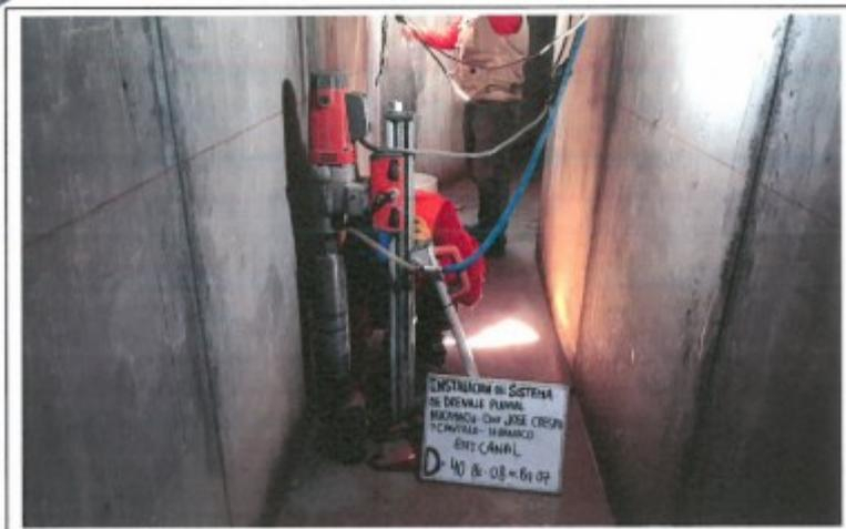
FOTO. 79.- EXTRACCION DEL TESTIGO DIAMANTINO N° 40, D-40, CANAL BZ-08 AL BZ-07
