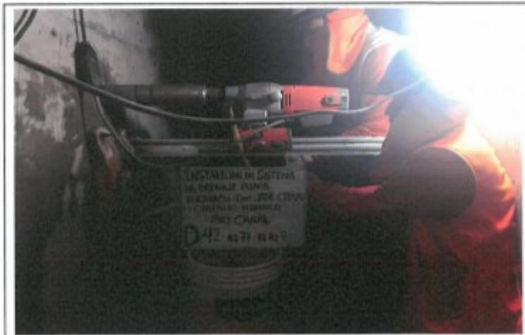
FOTO. 86.- PERFORACION DEL TESTIGO DIAMANTINO N° 42, D-42, CANAL BZ-77 AL BZ-78
