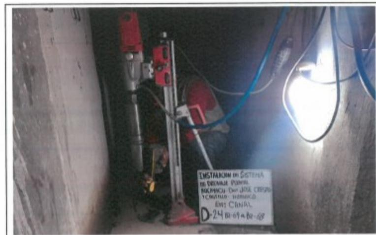
FOTO. 48.- MEDICION TESTIGO DIAMANTINA N° 24, D-24, CANAL BZ-69 AL BZ-68
