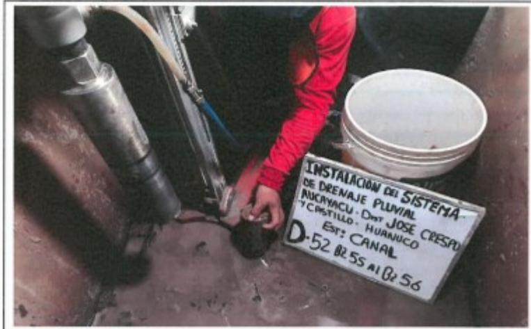
FOTO. 127.- EXTRACCION DEL TESTIGO DIAMANTINO N° 52, D-52, CANAL BZ-55 AL BZ-56
