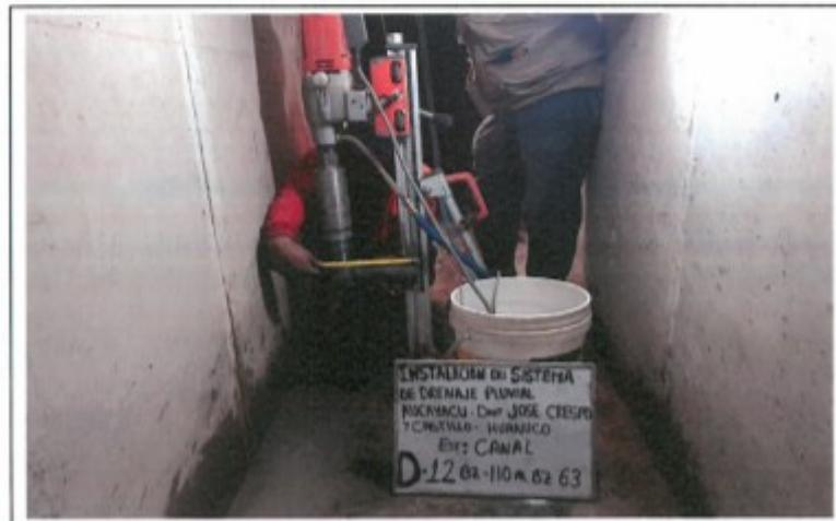
FOTO. 24.- MEDICION TESTIGO DIAMANTINA N° 12, D-12, CANAL BZ-110 AL BZ-63
