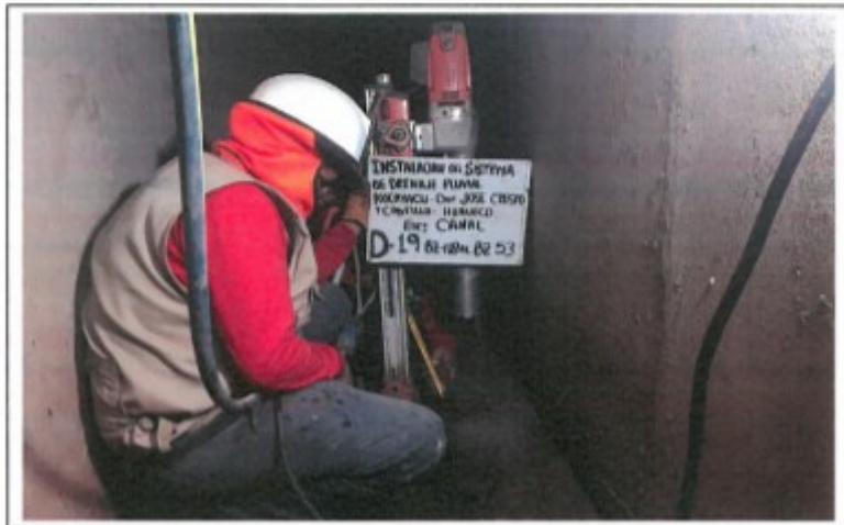
FOTO. 36.- MEDICION TESTIGO DIAMANTINA N° 19, D-19, CANAL BZ-118 AL BZ-53
