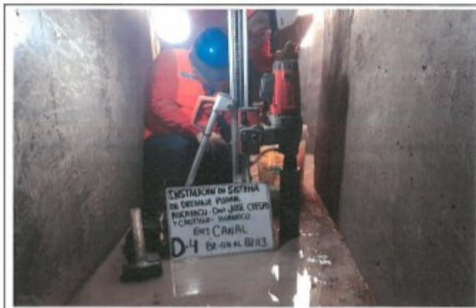
FOTO. 06.- PERFORACION DEL TESTIGO DIAMANTINO N° 04, D-4, CANAL BZ-114 AL BZ-113
