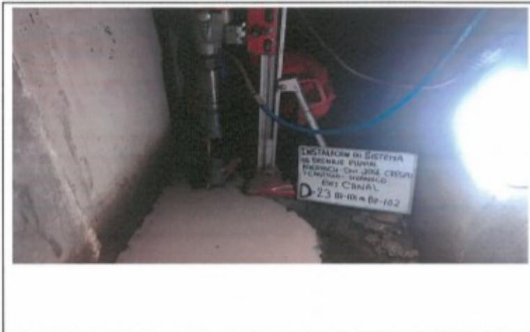
FOTO. 44.- MEDICION TESTIGO DIAMANTINA N° 23, D-23, CANAL BZ-101 AL BZ-102
