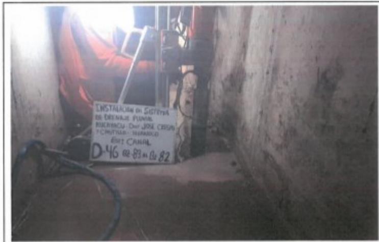
FOTO. 102.- PERFORACION DEL TESTIGO DIAMANTINO N° 46, D-46, CANAL BZ-83 AL BZ-82
