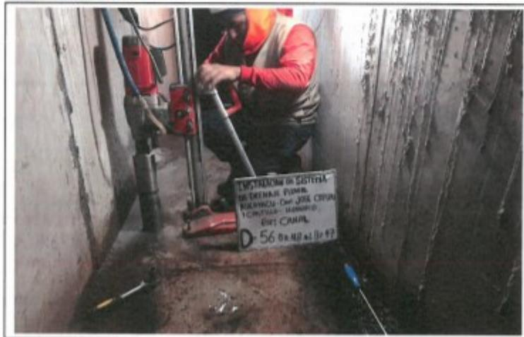
FOTO. 142.- PERFORACION DEL TESTIGO DIAMANTINO N° 56, D-56, CANAL BZ-48 AL BZ-47
