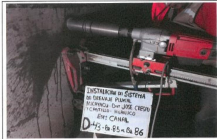
FOTO. 90.- PERFORACION DEL TESTIGO DIAMANTINO N° 43, D-43, CANAL BZ-85 AL BZ-86
