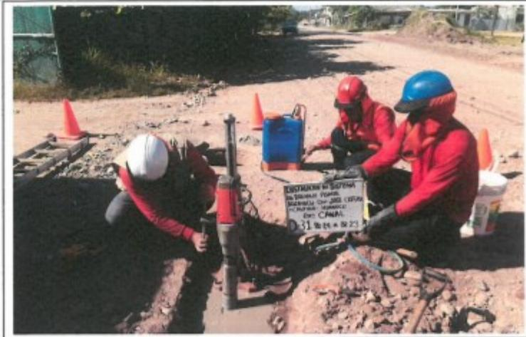
FOTO. 57.- VISTA PANORAMICA DEL TESTIGO DIAMANTINO N° 31, D-31, CANAL BZ-24 AL BZ-23
