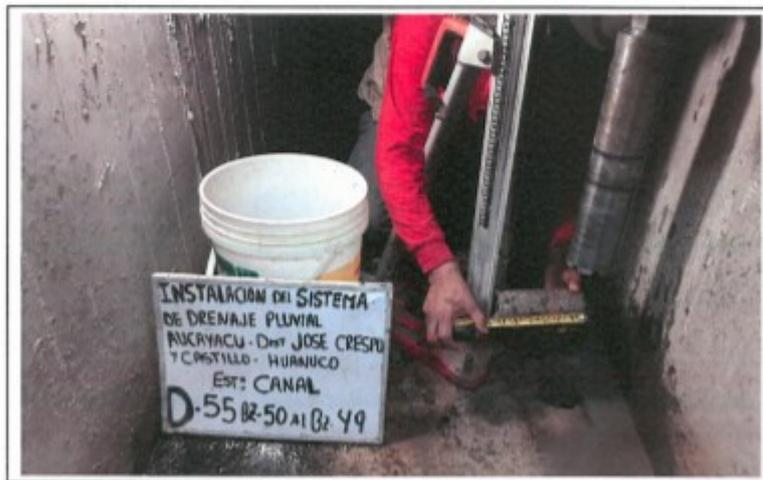
FOTO. 140.- MEDICION TESTIGO DIAMANTINA N° 55, D-55, CANAL BZ-50 AL BZ-49
