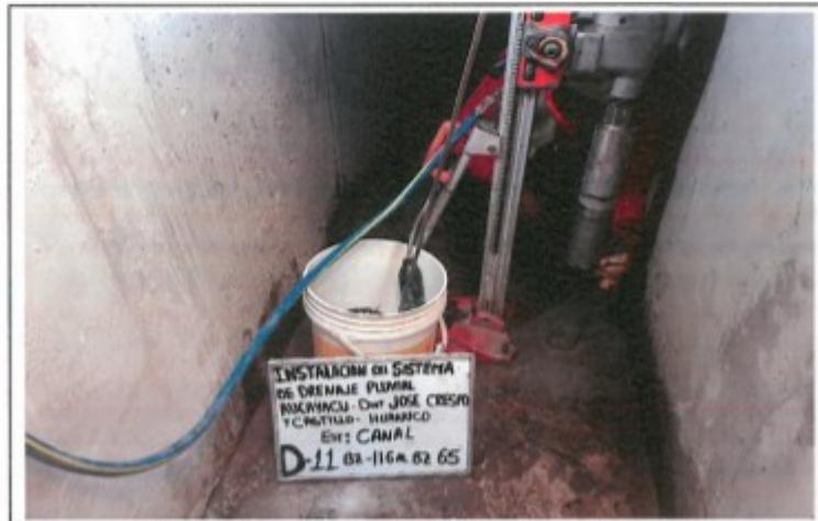
FOTO. 18.- PERFORACION DEL TESTIGO DIAMANTINO N° 11, D-11, CANAL BZ-116 AL BZ-65
