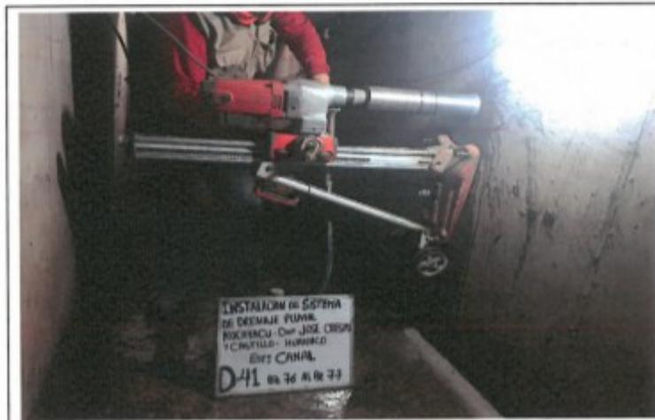
FOTO. 82.- PERFORACION DEL TESTIGO DIAMANTINO N° 41, D-41, CANAL BZ-76 AL BZ-77
