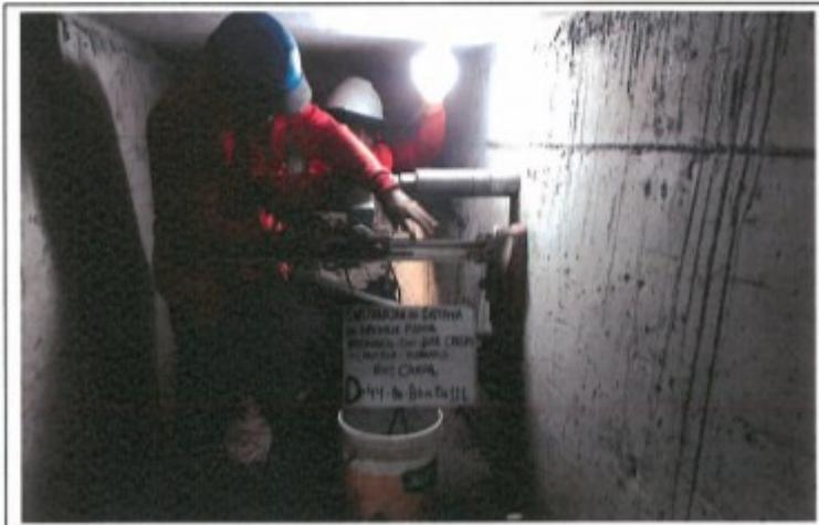
FOTO 94.- PERFORACION DEL TESTIGO DIAMANTINO N° 44, D-44, CANAL BZ-86 AL BZ-111
