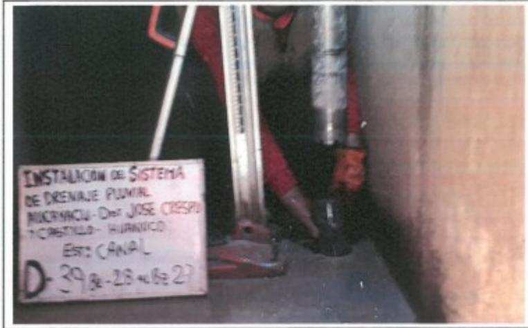
FOTO. 75.- EXTRACCION DEL TESTIGO DIAMANTINO N° 39, D-39, CANAL BZ-28 AL BZ-27.
