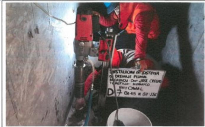
FOTO. 11.- EXTRACCION DEL TESTIGO DIAMANTINO N° 07, D-7, CANAL BZ-115 AL BZ-116
