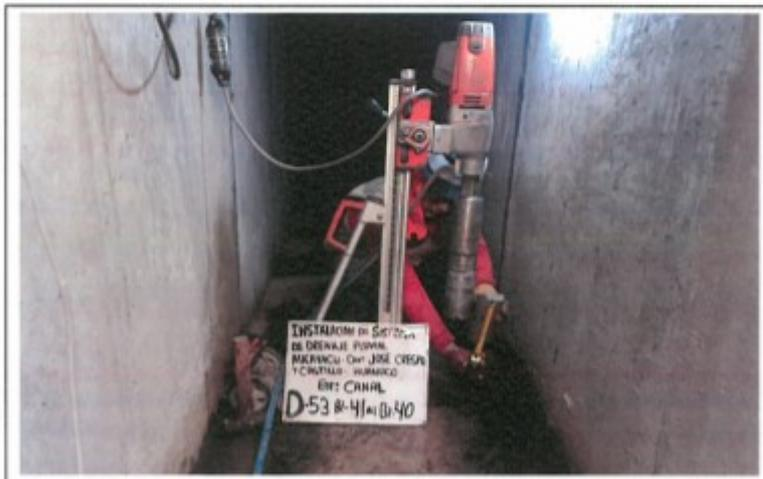
FOTO. 132.- MEDICION TESTIGO DIAMANTINA N° 53, D-53, CANAL BZ-41 AL BZ-40
