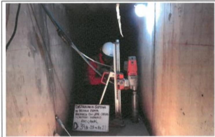
FOTO 74.- PERFORACION DEL TESTIGO DIAMANTINO N° 39, D-39, CANAL BZ-28 AL BZ-27.
