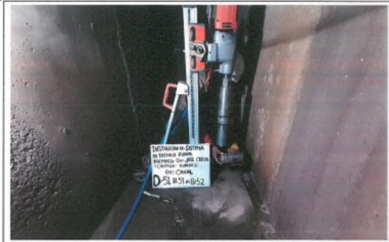
FOTO. 123.- EXTRACCION DEL TESTIGO DIAMANTINO N° 51, D-51, CANAL BZ-51 AL BZ-52
