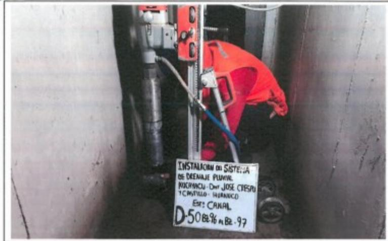
FOTO. 119.- EXTRACCION DEL TESTIGO DIAMANTINO N° 50, D-50, CANAL BZ-96 AL BZ-97
