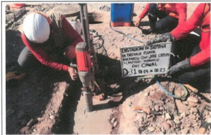
FOTO. 58.- PERFORACION DEL TESTIGO DIAMANTINO N° 31, D-31, CANAL BZ-24 AL BZ-23
