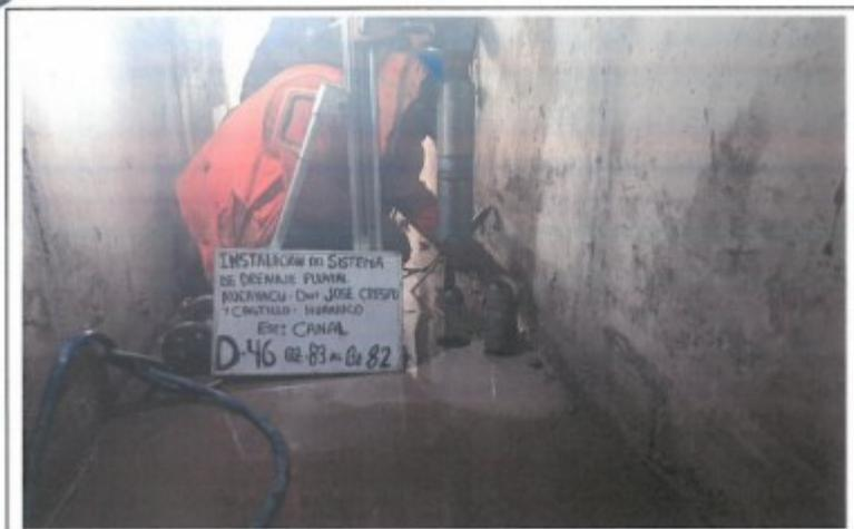
FOTO. 103.- EXTRACCION DEL TESTIGO DIAMANTINO N° 46, D-46, CANAL BZ-83 AL BZ-82
