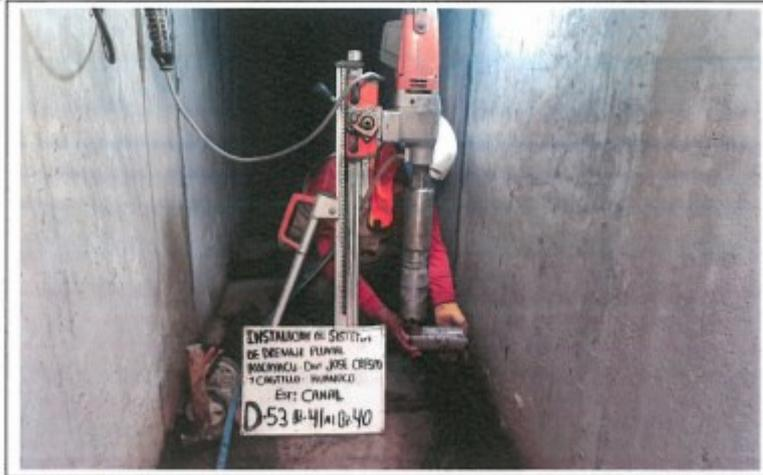
FOTO. 131.- EXTRACCION DEL TESTIGO DIAMANTINO N° 53, D-53, CANAL BZ-41 AL BZ-40
