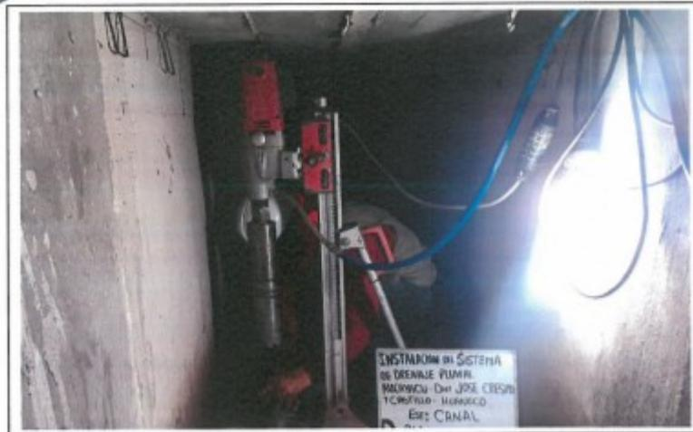
FOTO. 47.- EXTRACCION DEL TESTIGO DIAMANTINO N° 24, D-24, CANAL BZ-69 AL BZ-68
