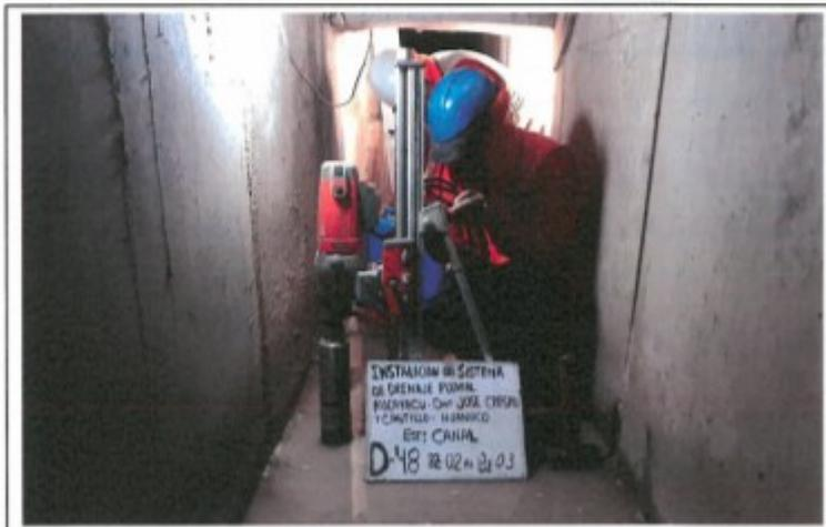
FOTO. 110.- PERFORACION DEL TESTIGO DIAMANTINO N° 48, D-48, CANAL BZ-02 AL BZ-03
