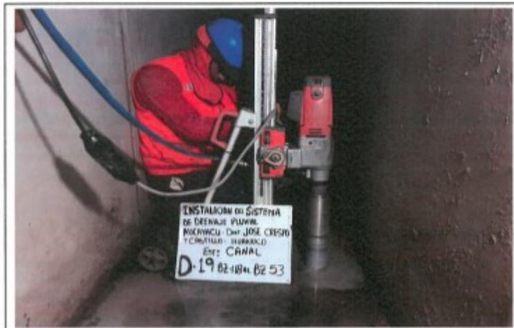
FOTO. 34.- PERFORACION DEL TESTIGO DIAMANTINO N° 19, D-19, CANAL BZ-118 AL BZ-53
