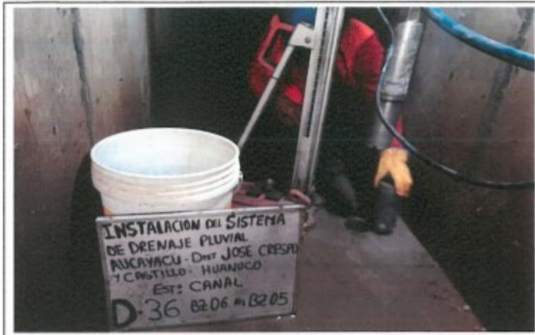
FOTO. 71.- EXTRACCION DEL TESTIGO DIAMANTINO N° D-36, CANAL BZ-06 AL BZ-05
