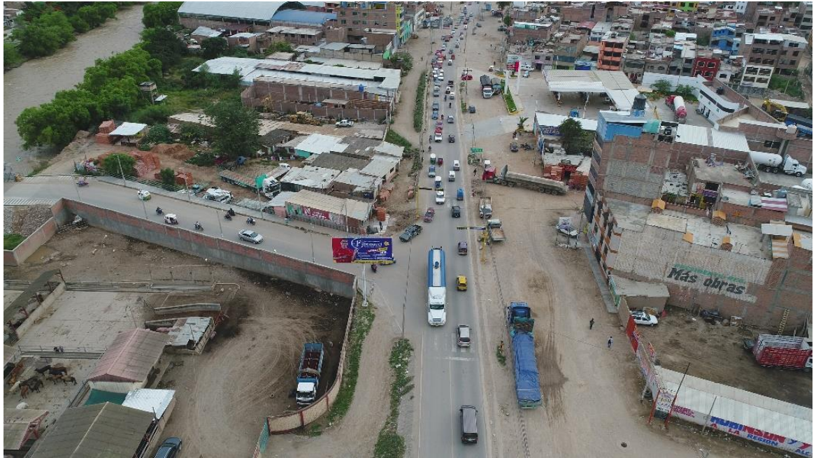
vista panorámica del lugar de estudio, PUENTE JOAQUIN GARAY - CARRETERA 18-A
