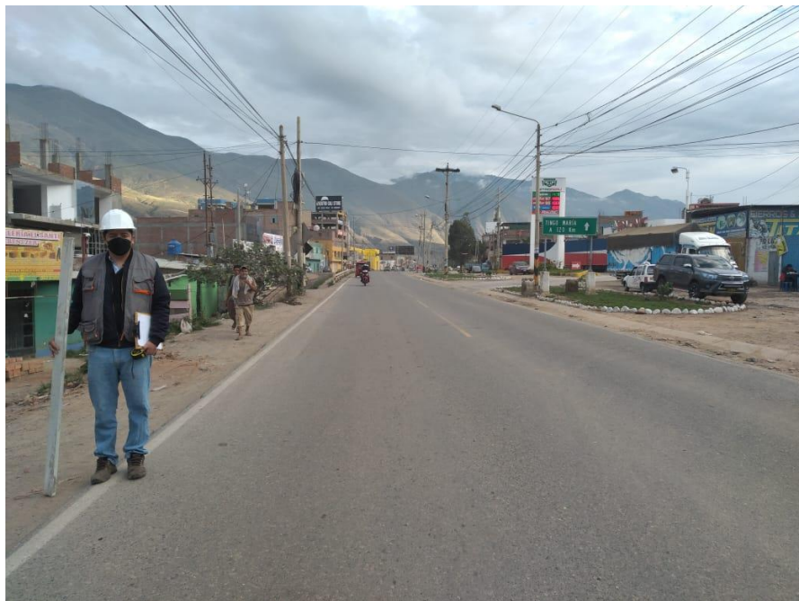
Punto de Referencia 0020-0021, se observa la vía sin deterioro o falla, un ancho de 130mx4m
