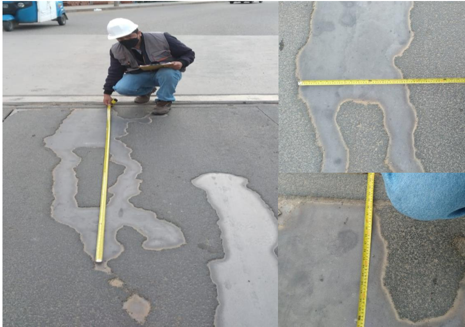
Punto de Referencia 0013-0014, se observa el tipo de deterioro “Peladura y Desprendimiento”, la falla es puntual y desprendimiento del concreto asfáltico de 2.49mx0.46m
