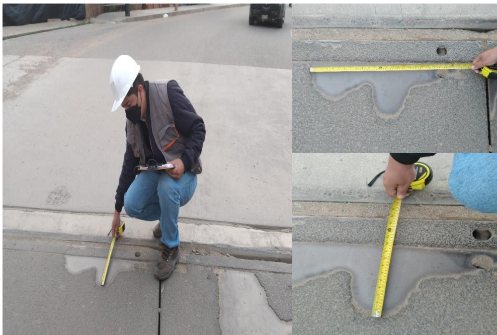
Punto de Referencia 0013-0014, se observa el tipo de deterioro “Peladura y Desprendimiento”, la falla es puntual y desprendimiento del concreto asfáltico de 2.49mx0.46m
