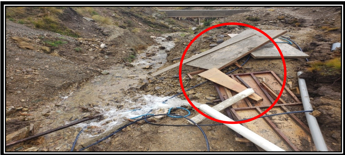
Imagen donde se muestra paneles en mal estado y expuestos a agua.
