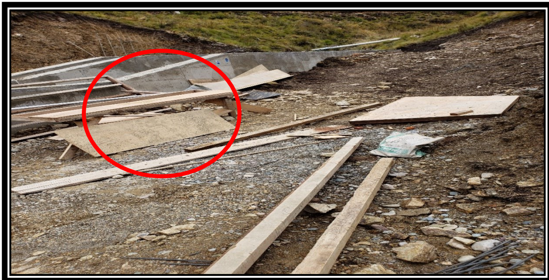
Imagen donde se muestra restos de madera usado para el encofrado.
