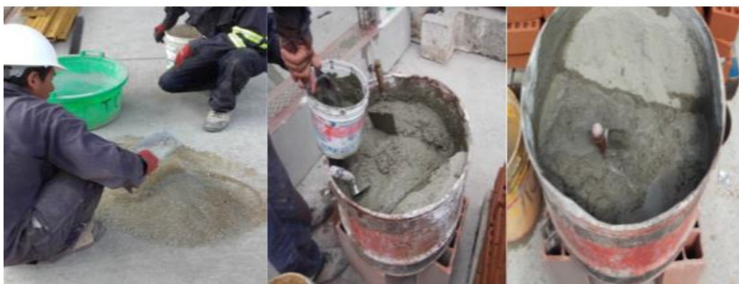
Figura N° 4. Proceso de preparación del mortero
