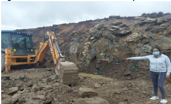
Figura 11: Acondicionamiento de zonas para material procesado
