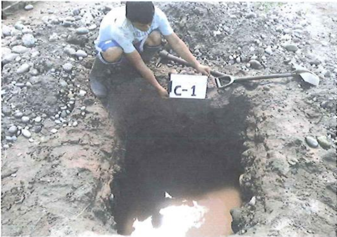
Excavación de la calicata 01, coordenadas UTM: 391372.55E; 8980180.078N
