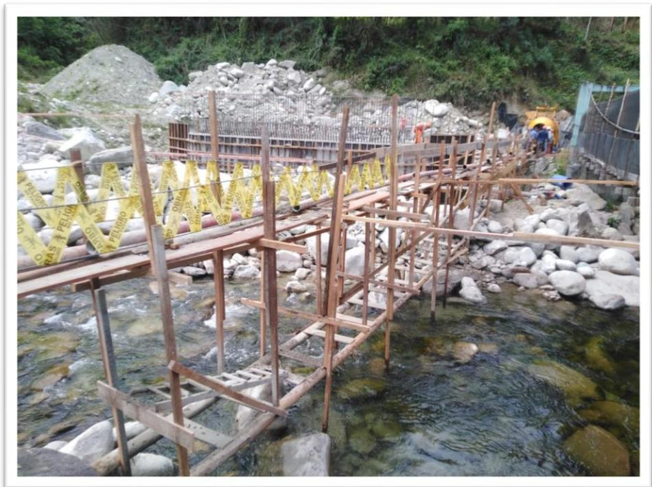
FALSO PUENTE PARA BOMBA DE CONCRETO
