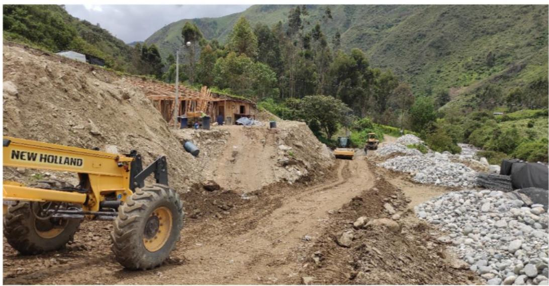
**EN LA IMAGEN SE MUESTRA LAS MAQUINARIAS TRABAJANDO EN EL RELLENO DEL ACCESO**
