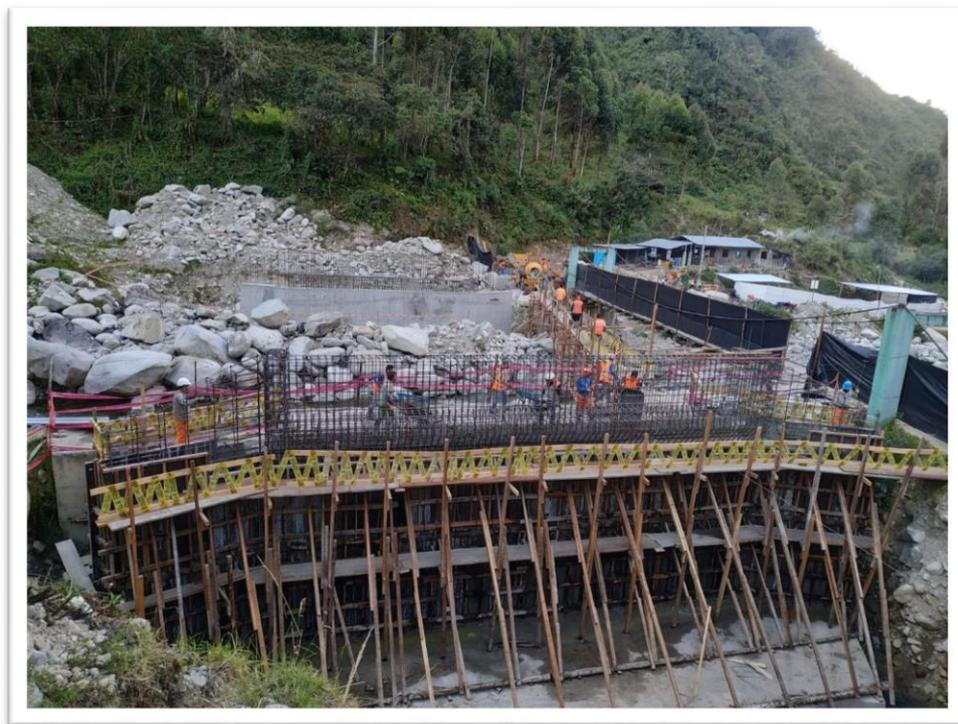
VACIADO DE ESTRIBO E-02 CON 3 CUADRILLAS DE 12 OBREROS
