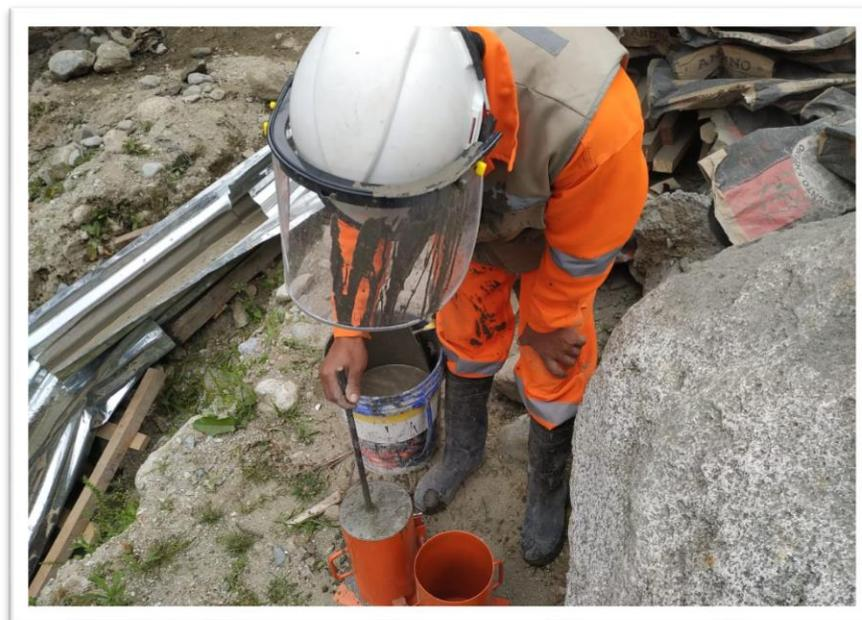
SACADO DE PROBETAS DEL ESTRIBO E-01
