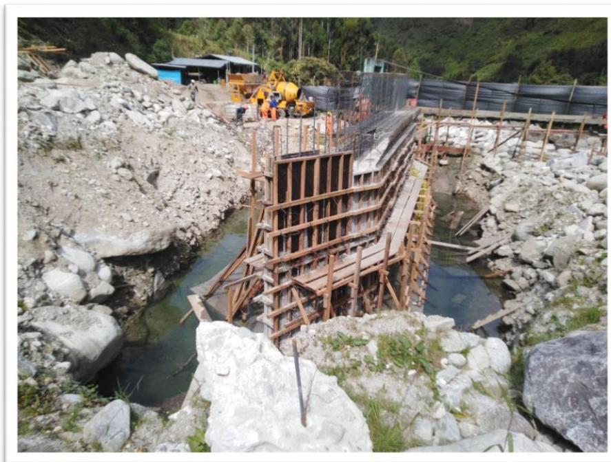
VACIADO DE ESTRIBO E-02 EL CUAL FUE ENCOFRADO CON PANELES DE 10 ML
