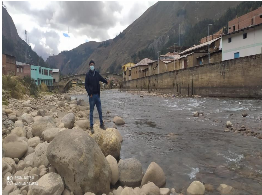
Se observa la acumulación de bolonería de gran tamaño en la margen izquierda de la ribera del río Vizcarra.
