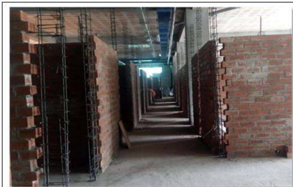
MUROS DE ALBAÑILERÍA Y ACERO EN COLUMNETAS **BLOQUE D**
