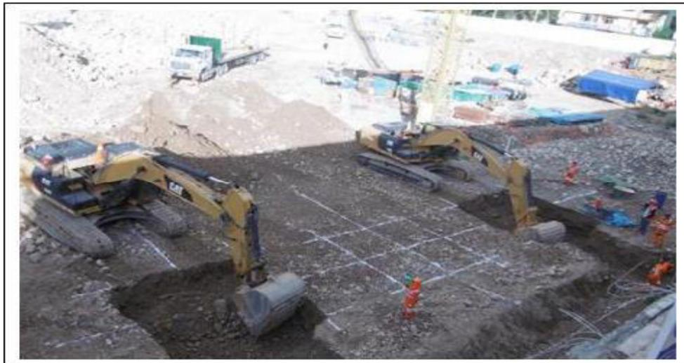
NIVELACIÓN Y EXCAVACIÓN DE LAS ZAPATAS.
