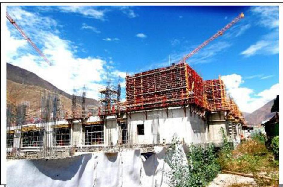
COLOCACIÓN DE GEOMEMBRANA Y ENCOFRADO DE PLACAS.
