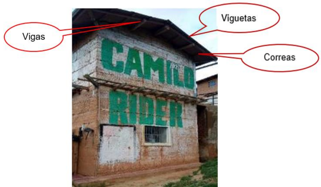
Figura 28 Cubiertas de la vivienda
