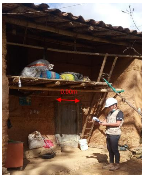
Figura 26 Vano de puerta
