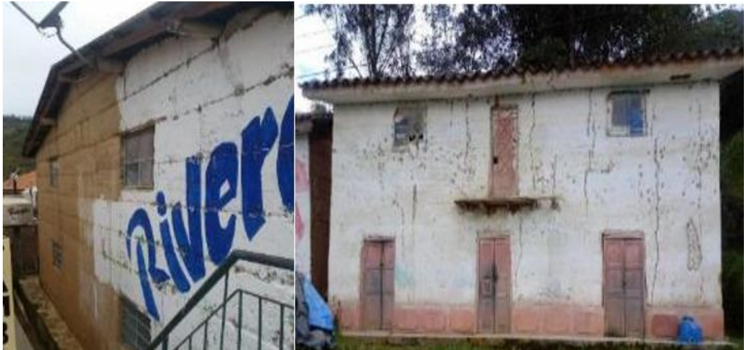
Figura 22 Zócalos y veredas de vivienda de tapial
