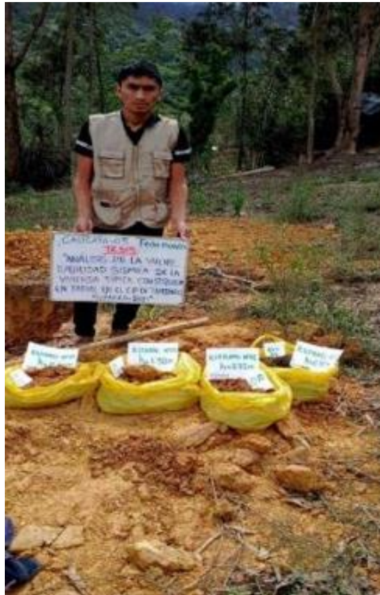
FOTOGRAFÍA N°09: Se observa la calicata C-03. La cual se realizó con la finalidad de verificar el perfil estratigráfico In-Situ. Y asimismo extraer muestras para ensayo en laboratorio de mecánica de suelos.
