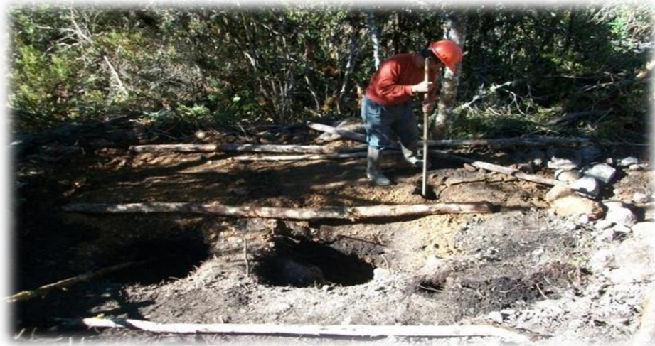
FOTO N° 11: EXCAVACIÓN PARA EL MICRO RELLENO SANITARIO
