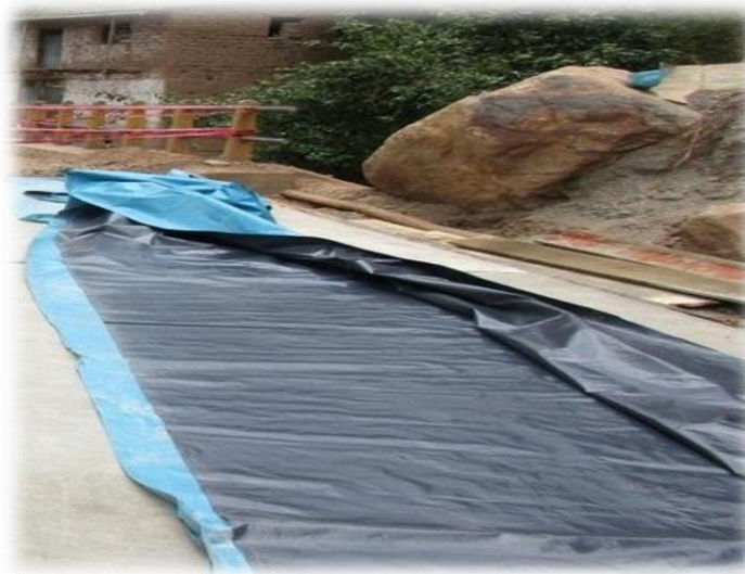
FOTO N° 12: PLASTICO DOBLE PARA CUBRIR LOS MATERIALES (AGREGADOS)
