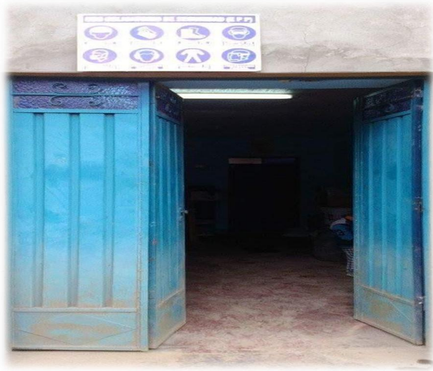
FOTO N° 07: LETREROS DE SEÑALIZACIÓN EN EL ALMACÉN
