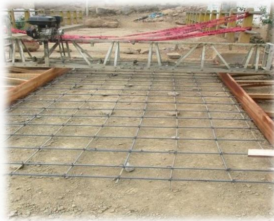
FOTO N° 08: SEÑALIZACIÓN EN LA OBRA CON CINTAS DE SEGURIDAD
