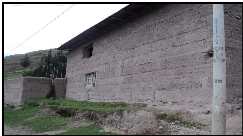
Fotografía N°3 viviendas de material rustico.
