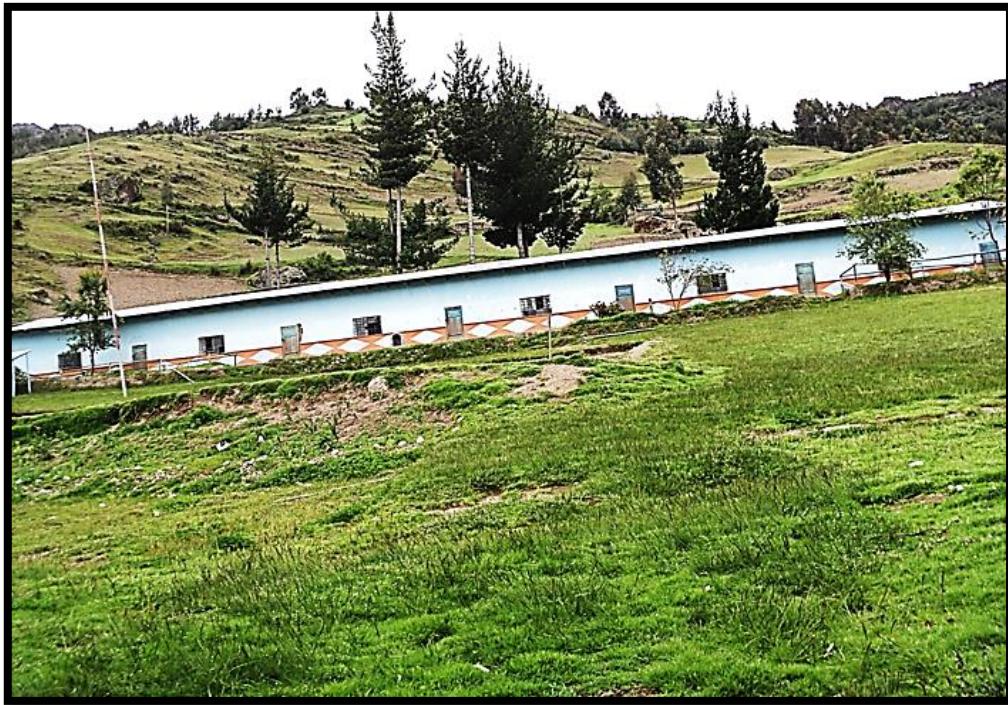
FOTOGRAFIA N° 8 Infraestructura antigua de la I. E. Integrado de Cascanga a la cual se le realizará la demolición.
