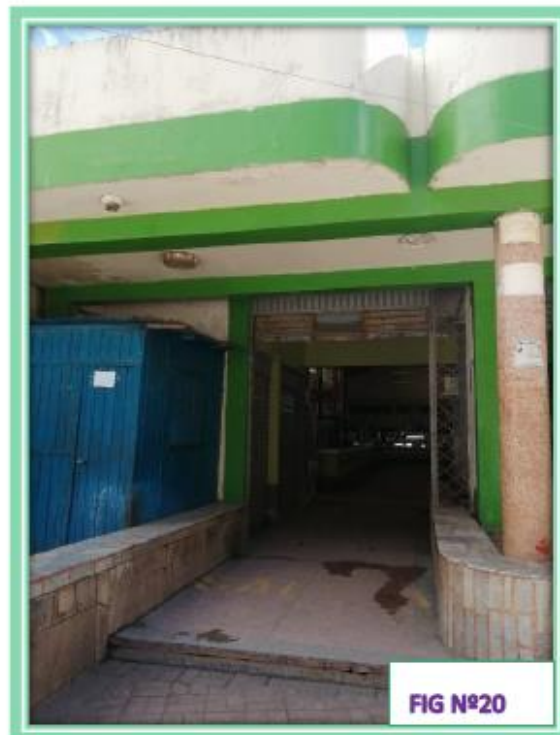
En la Fig. Nº20 se observa piso de acceso de salida con mayólica mármol
