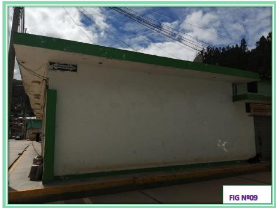
En la Fig. N°09 se observa el muro y voladizo de techo y el cableado de luz
