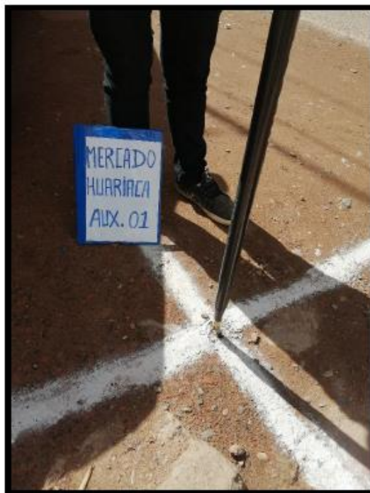
FIGURA 09: MONUMENTACION DE AUX-01 – POLIGONAL CERRADA
