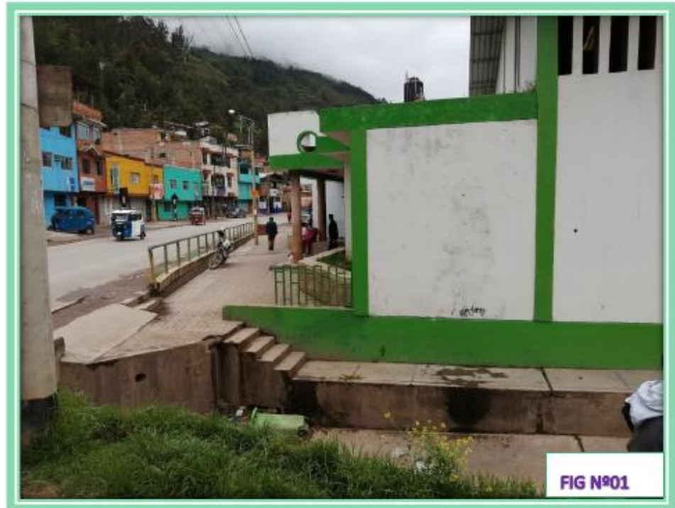
En la Fig. N°01 se observa el acceso a la entrada central al mercado
