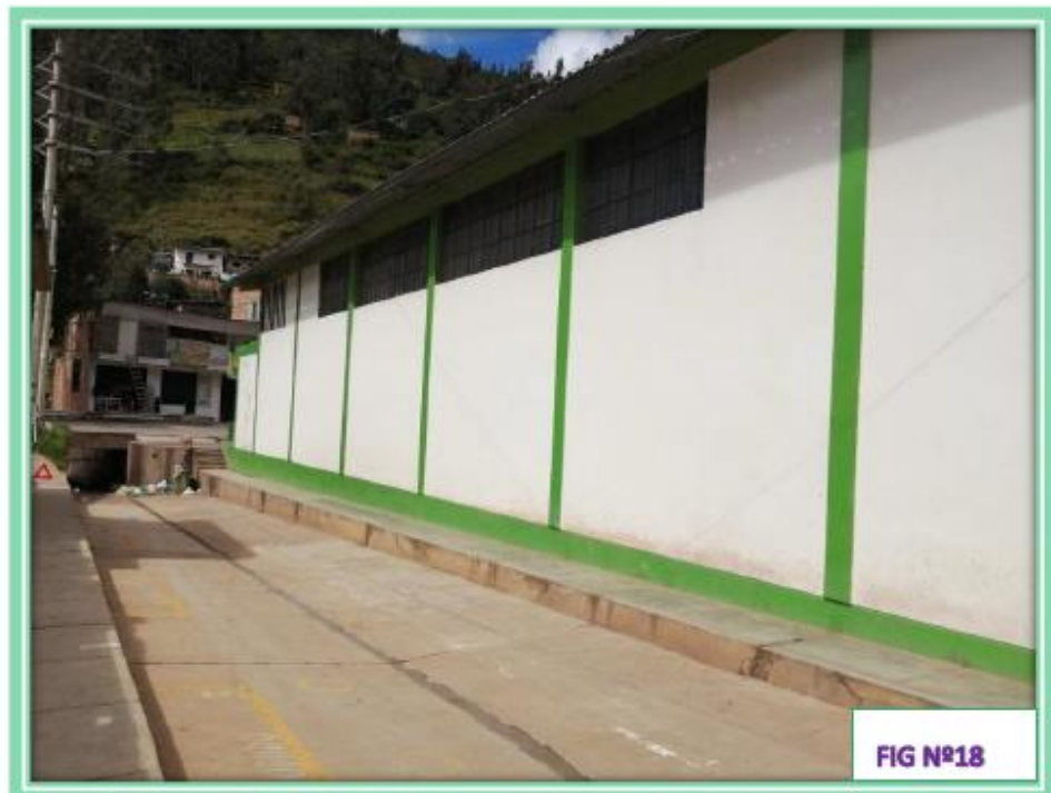
En la Fig. Nº18 vista de separación de paños del mercado
