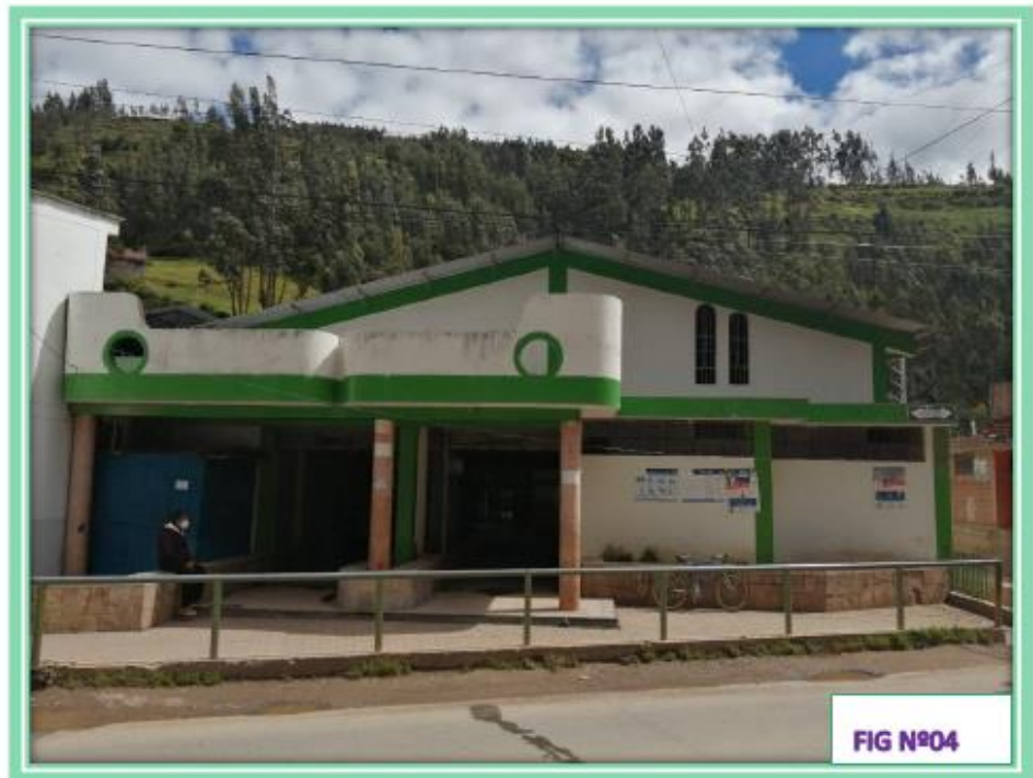
En la Fig. N°04 se visualiza las barandas metálicas de contención al ingreso del mercado
