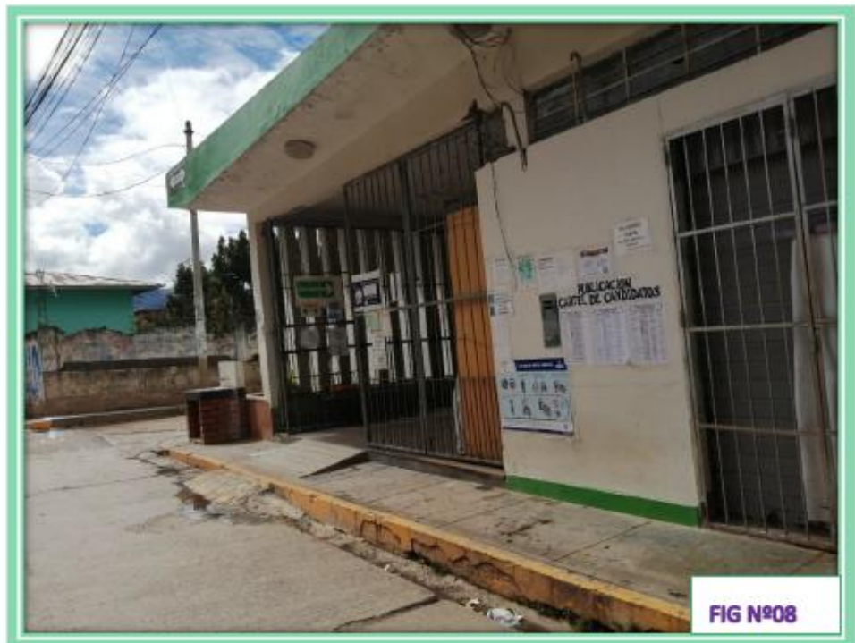
En la Fig. N°08 se observa el ingreso posterior contiguo a la calle de la localidad
