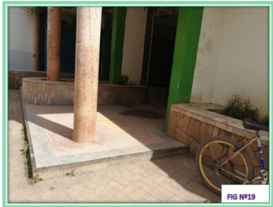
En la Fig. Nº19 se observa detalle de columna circular
