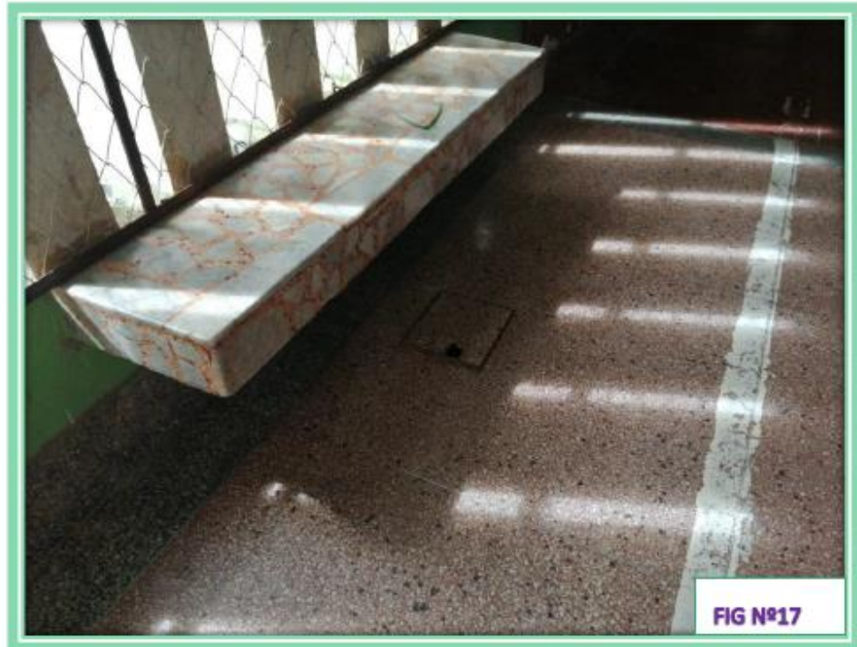
En la Fig. Nº17 se observa banco de espera de mármol y piso mayólica mármol
