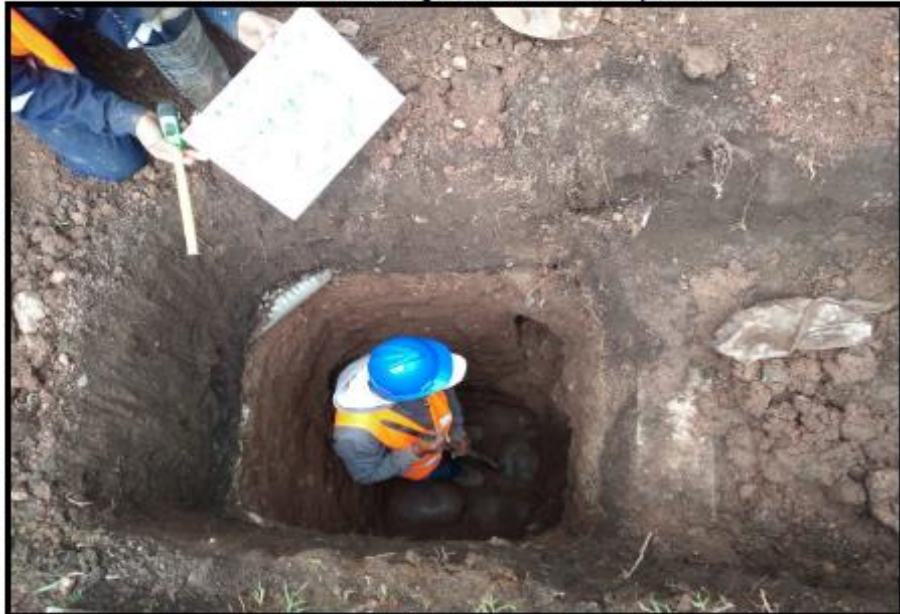
IMAGEN N° 10 – Vista fotográfica de la calicata explorada
