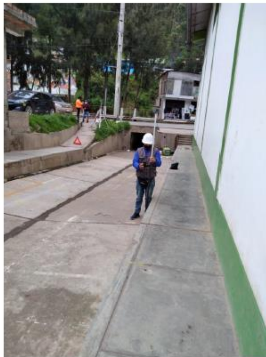
FIGURA N° 04: GRUPO DE TRABAJO EN LA ZONA DEL PROYECTO
