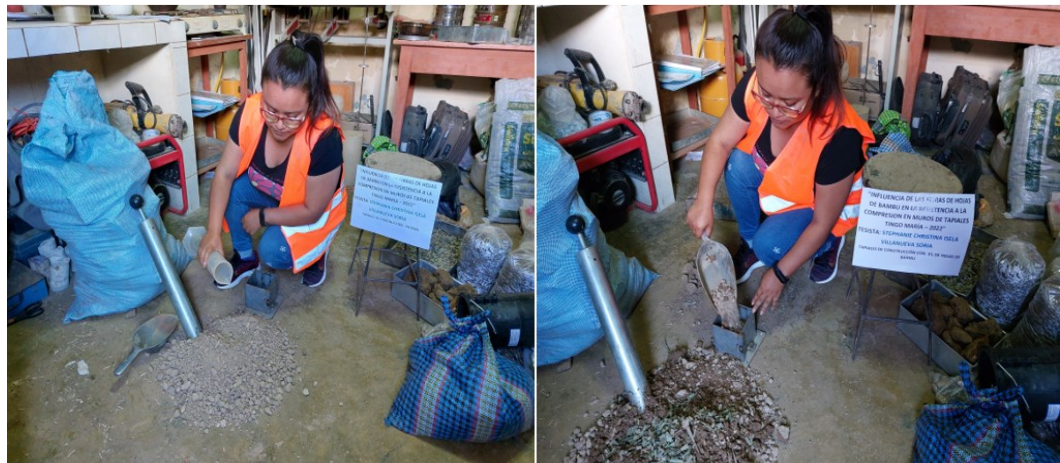
Figura 8 Proceso de mezcla de los materiales para los bloques de tapial.
