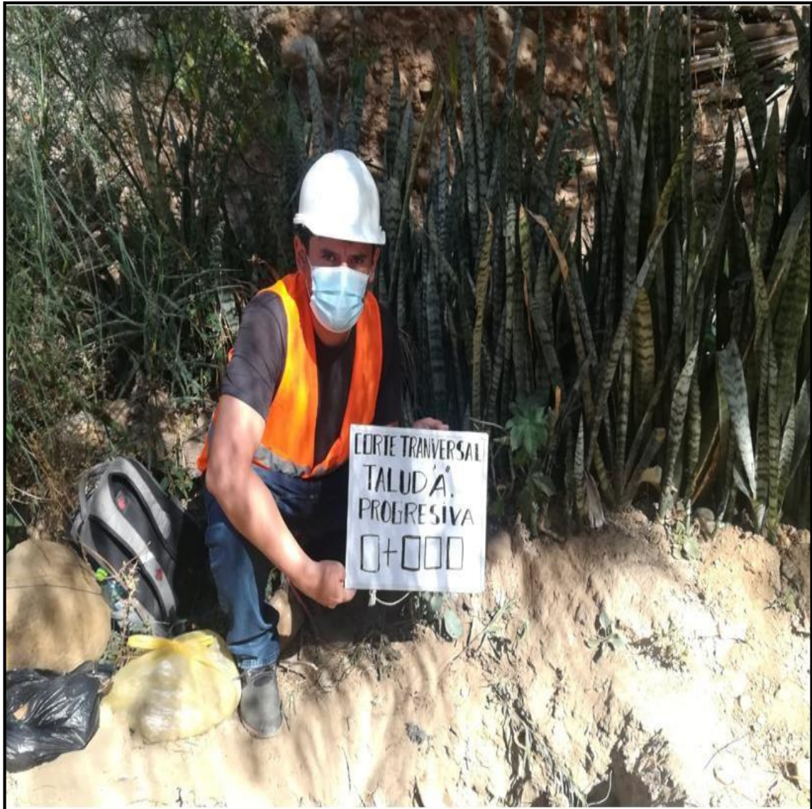
Vista Fotográfica de corte N°01 en la progresiva 0+000
