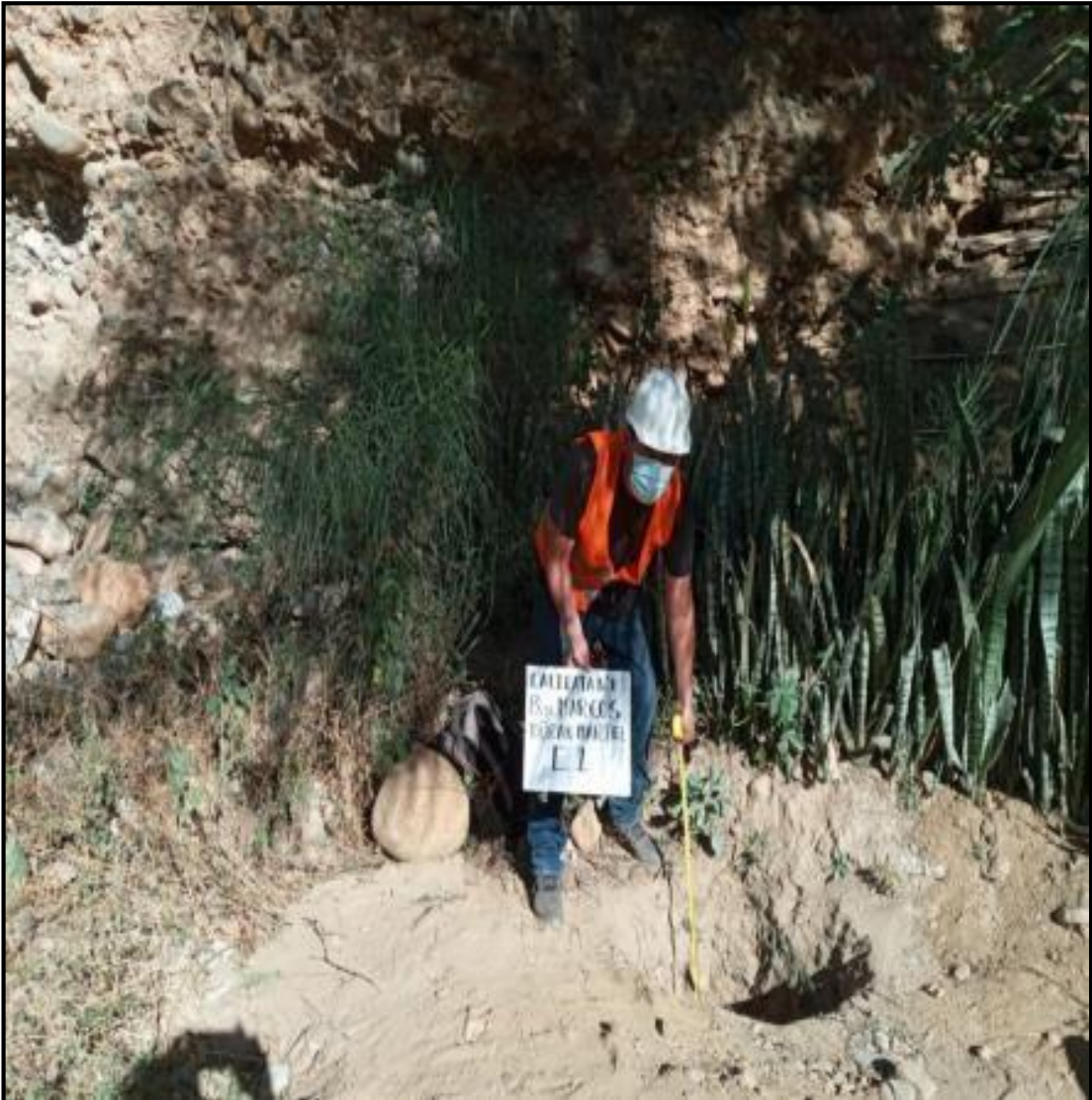
Vista fotográfica de la calicata N°02
