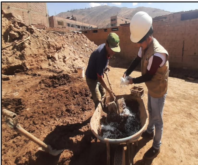
*Nota.* El gráfico muestra la adición de fibras de polietileno de alta densidad y aluminio reciclado al barro. Elaboración propia.
