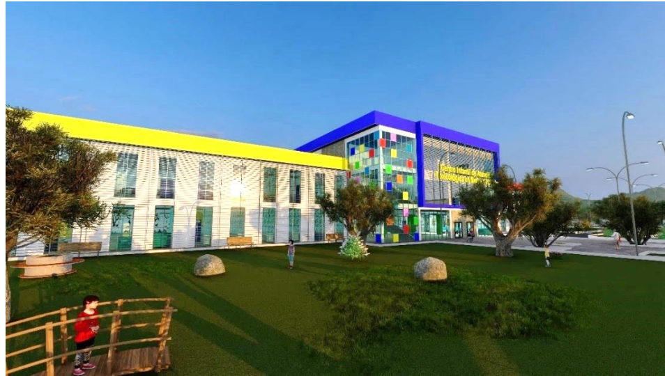
Figura 91 Parasoles en fachada principal
